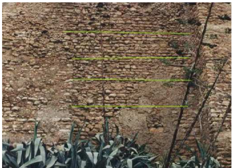
FIGURA 11.52: tramades d'encofrat o tabiya a banda i banda de la torre, abans de la restauració (A. Llorca- S. Viladrich, Direcció General del Patrimoni Cultural).
