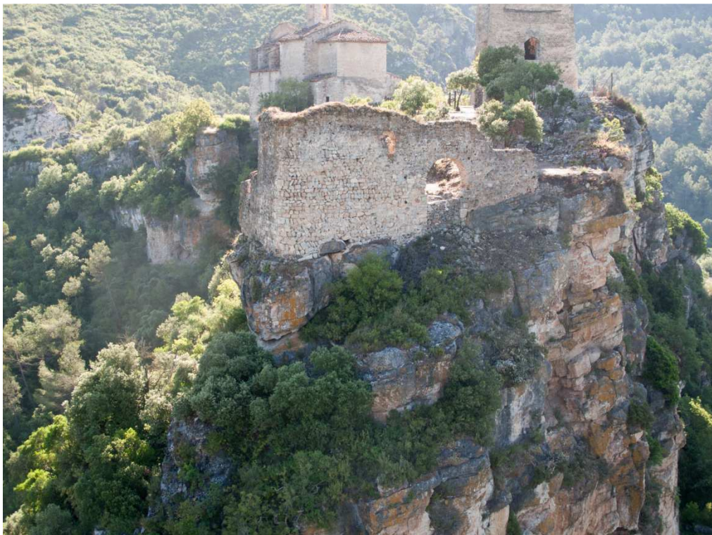
FIGURA 11.47: construccions del costat est del castell des de l'exterior. S'observa un gran arc de ferradura relacionable amb l'accés principal del castell, i al costat una sala o estança de planta quadrada i angles arrodonits construïda amb la tècnica de l'encofrat (Ajuntament de Pontils-ICAC-MRW).
