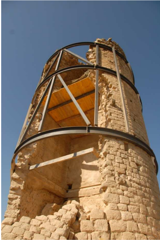
FIGURA 11.67: a l'esquerra, la torre del Caragol, a Ponts (La Noguera). La construcció circular d'època feudal no deixa de ser una camisa d'una torre andalusí de planta quadrada aixecada amb una base de maçoneria i un segon cos de tabiya de terra. Dalt, detall de la muralla islàmica del Pla d'Almatà, Balaguer, amb un impressionant aparell de carreus emiral, que es combina amb alçat de tàpia (Museu de la Noguera).
