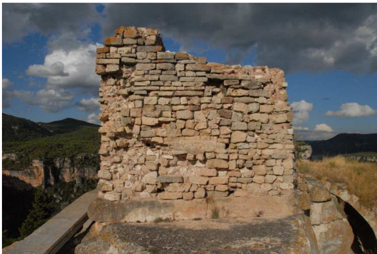
FIGURA 11.59: torre de la celòquia del castell, construïda mitjançant la tècnica de la tabiya o encofrat.
