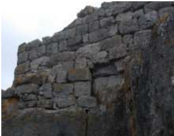
FIGURA 11.65: detalls de la construcció de la muralla oriental, on s'observa la construcció per tongades o caixons.
