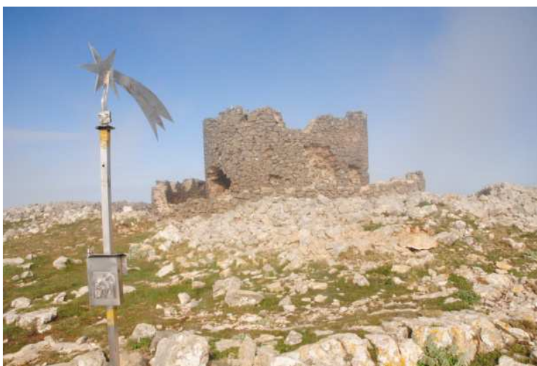
FIGURA 11.116: torre carlina de la mola de Coldejou (A. Cabré).
