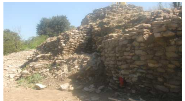
FIGURA 11.86: dos exemples de tradició constructiva d'arrel molt antiga. A l'esquerra la muralla de la medina de Sfax a Tunísia, on veiem cadenes de carreus combinades amb maçoneria, hereva dels aparells de tradició púnica i l'opus africanum; a la dreta la muralla visigòtica de l'Esquerda a Roda de Ter, de pedra seca.
