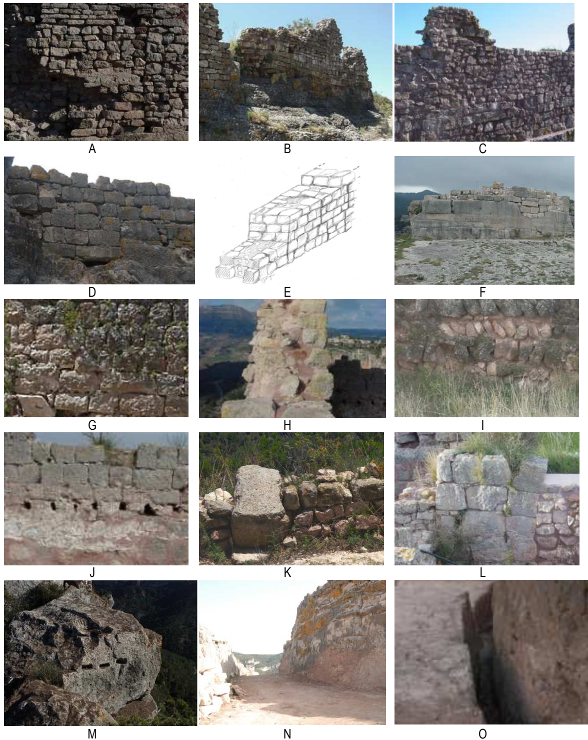
FIGURA 11.66: aparells andalusins del hisn de Siurana. A. encofrat o tabiya de la torre de la celòquia; B. murs de la celòquia; C. murs encofrats de la celòquia; D. mur d'aparell ciclopi de la muralla; E. croquis de la construcció de la muralla; F. muralla oriental sobre roca, retallada per aprofitar la pedra en l'obra; G. mur de la cuirassa, de grans blocs; H. secció parcial de la torre sobre la cuirassa; I. aparell d'espina de peix del tancament meridional, part que dona al castell; K. murs interiors dels habitatges, amb combinació de cadenes de carreus i maçoneria; L. arrencada d'arc del costat nord; M. tasconeres al peu de la torre de la celòquia, que mostren l'aprofitament com a front de pedrera; N. fossat oriental; O. excavació del fossat oriental, amb un gran regueró obert.
