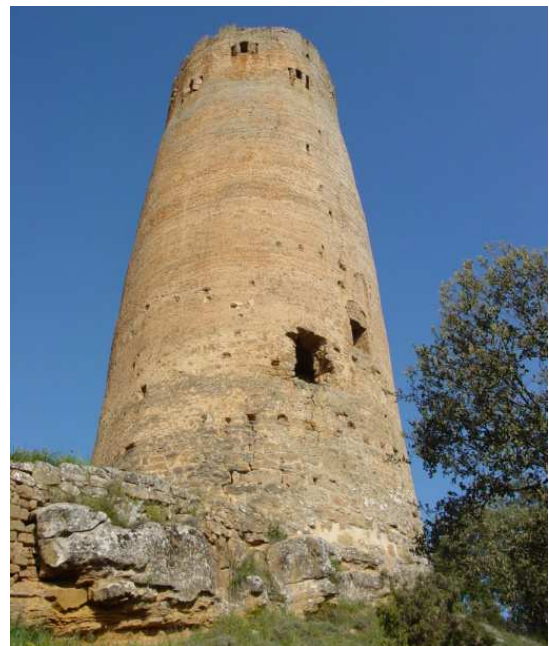
FIGURA 11.37: torre de Vallferosa, al municipi de Torà, comarca de La Segarra.
