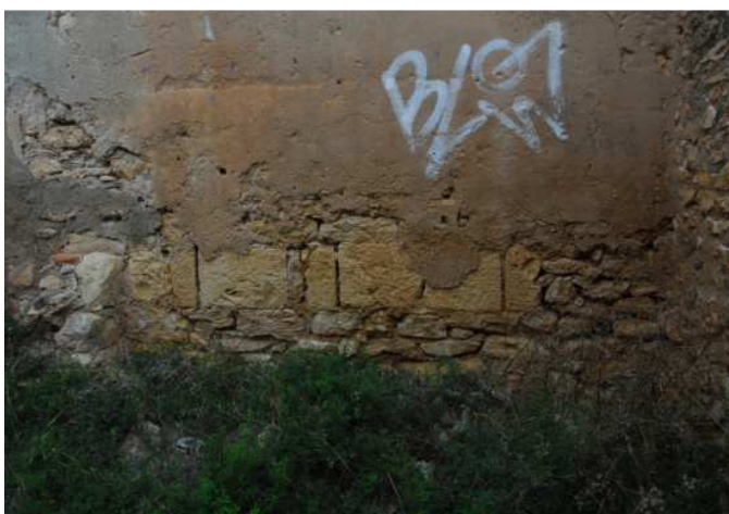
FIGURA 11.100: dos detalls de les bases de carreus de llarg i través del mas de Salort, al Catllar.
