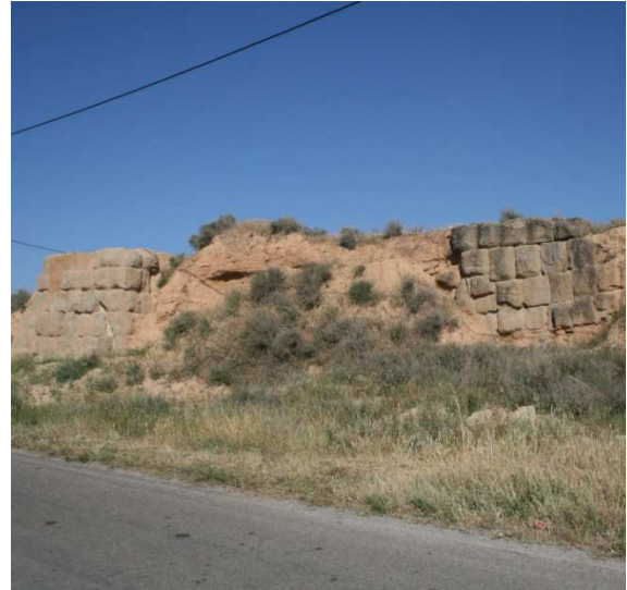
FIGURA 11.67: a l'esquerra, la torre del Caragol, a Ponts (La Noguera). La construcció circular d'època feudal no deixa de ser una camisa d'una torre andalusí de planta quadrada aixecada amb una base de maçoneria i un segon cos de tabiya de terra. Dalt, detall de la muralla islàmica del Pla d'Almatà, Balaguer, amb un impressionant aparell de carreus emiral, que es combina amb alçat de tàpia (Museu de la Noguera).
