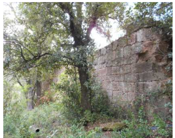
FIGURA 11.99: detall de la construcció de tàpia de la torre de Monravà i dels murs de l'edifici contigu, de carreuada lligada amb morter.
