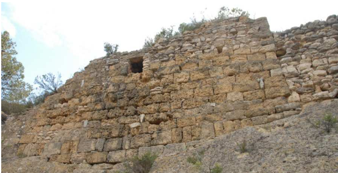
FIGURA 11.80: aparell de llarg i través del castell de Vespella de Gaià.
