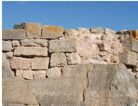
FIGURA 11.65: detalls de la construcció de la muralla oriental, on s'observa la construcció per tongades o caixons.
