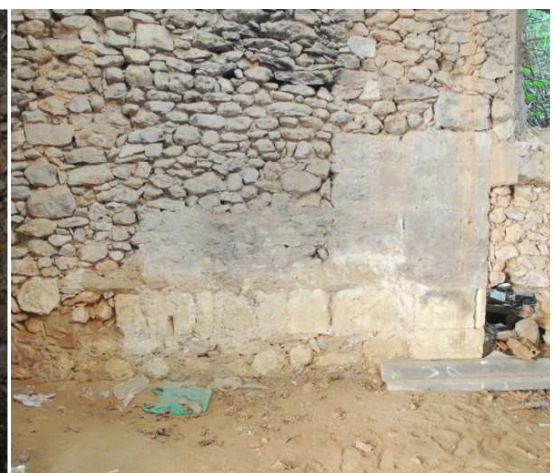
FIGURA 11.100: dos detalls de les bases de carreus de llarg i través del mas de Salort, al Catllar.
