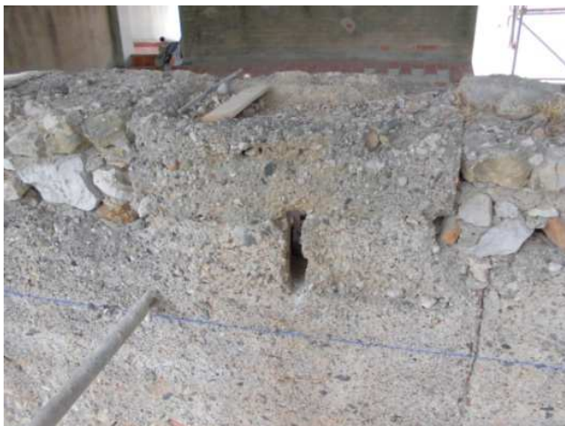
FIGURA 11.2: dos trams d'ampit de la muralla de Tarragona (Casa Canals i col·legi Lestonnac). Són obra realitzada en tàpia i conserven encara les llucanes o espitlleres i l'arrencada de merlets també de tàpia. Si bé Morera Llauredó els interpreta com obra islàmica, es tracta en aquests casos de sengles obres datables al segle XII, després del control de la ciutat per Robert d'Aguiló.
