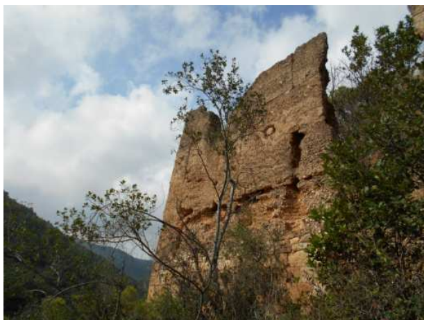
FIGURA 11.99: detall de la construcció de tàpia de la torre de Monravà i dels murs de l'edifici contigu, de carreuada lligada amb morter.
