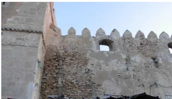
FIGURA 11.86: dos exemples de tradició constructiva d'arrel molt antiga. A l'esquerra la muralla de la medina de Sfax a Tunísia, on veiem cadenes de carreus combinades amb maçoneria, hereva dels aparells de tradició púnica i l'opus africanum; a la dreta la muralla visigòtica de l'Esquerda a Roda de Ter, de pedra seca.
