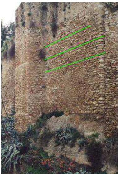
FIGURA 11.52: tramades d'encofrat o tabiya a banda i banda de la torre, abans de la restauració (A. Llorca- S. Viladrich, Direcció General del Patrimoni Cultural).
