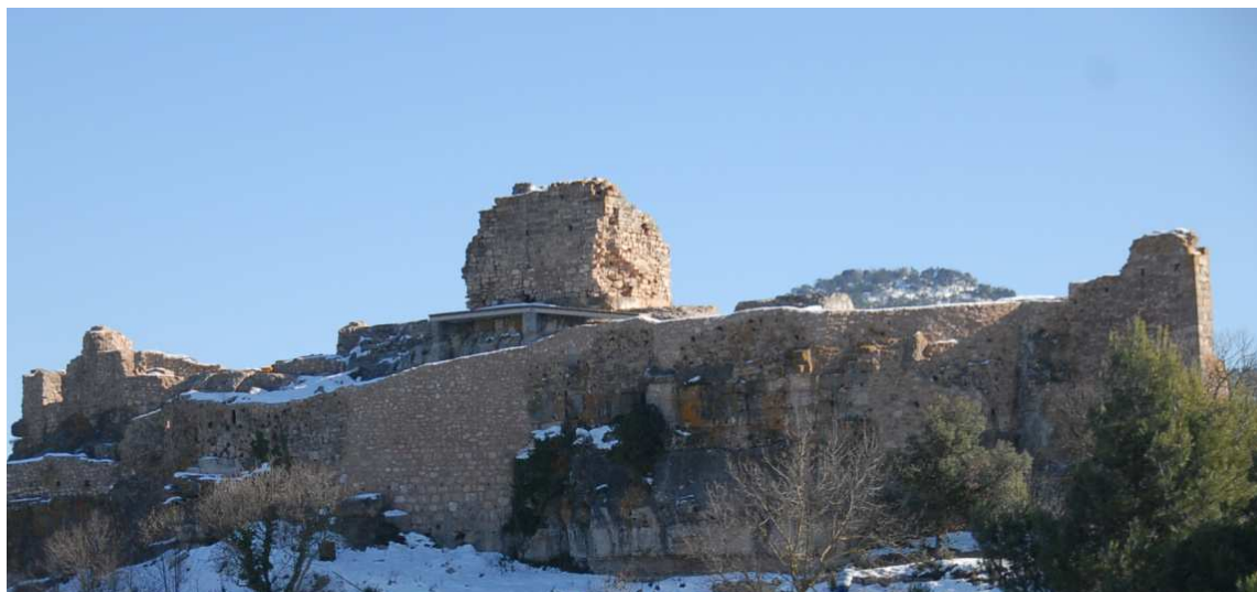
FIGURA 14.8: vista del hisn de Xibrana, actual Siurana.
