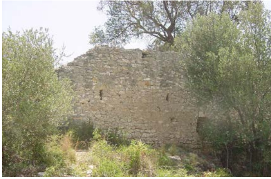
FIGURA 12.74: mur nord del castell dels Montgons.
