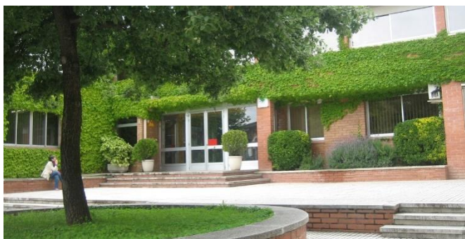
Figura 3 Entrada principal de la Escola Intermunicipal del Penedès
