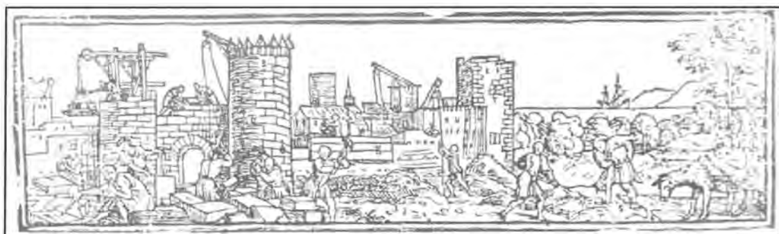
Construcció de les muralles de València segons la Crònica General... de Pere Antoni Beuter (1546). Es mostren treballs en fàbriques de tàpia i de pedra, que en aquest treball documentem als murs tortosins (il·lustració presa d'A. ZARAGOZÀ, Arquitectura gòtica valenciana )
