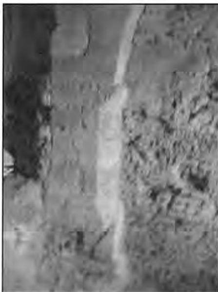
Arrencada d'un dels arcs conservats de la Casa de Sant Jordi
