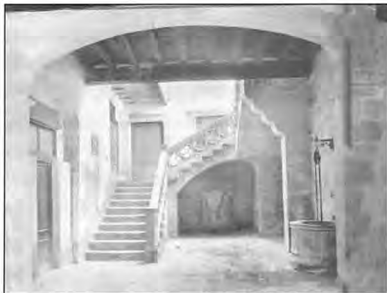
Pati de la Casa de la ciutat després del 1905 (AHCTE)
