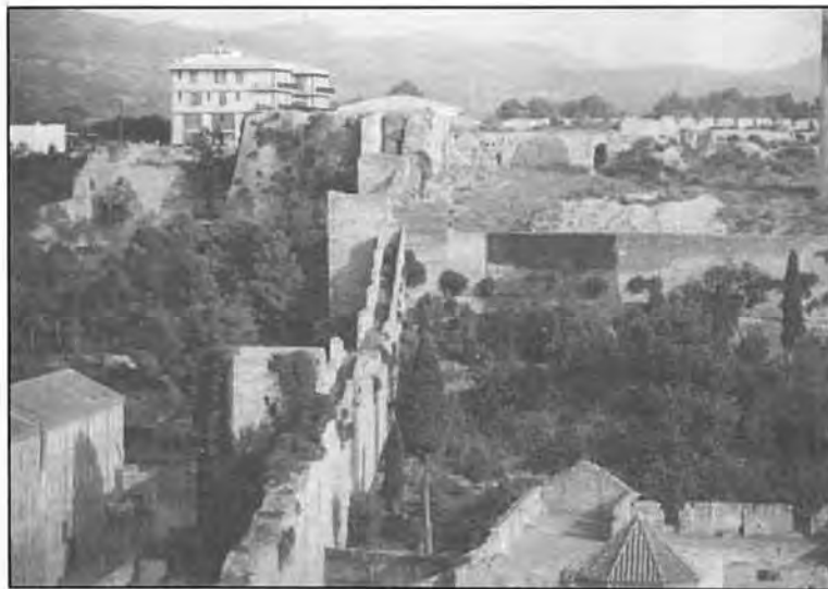
Muralla del sector de Santa Clara-Escorxeria (dècada de 1970)
