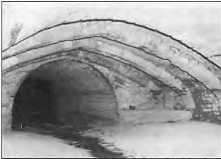
Arcades i pont de la peixateria al 2005
