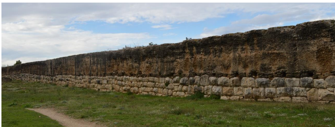
Fig. 67. Paramento de la muralla de la ciudad de Empúries.
