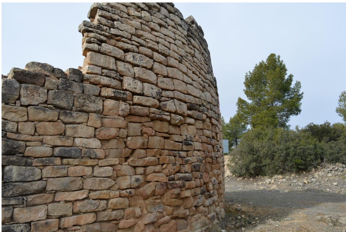
Fig. 218. Detalle del paramento de Torre Cremada.
