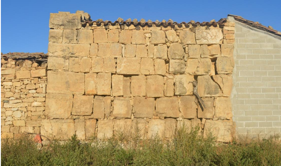
Fig. 155. Estado actual de la Torre dels Moros
