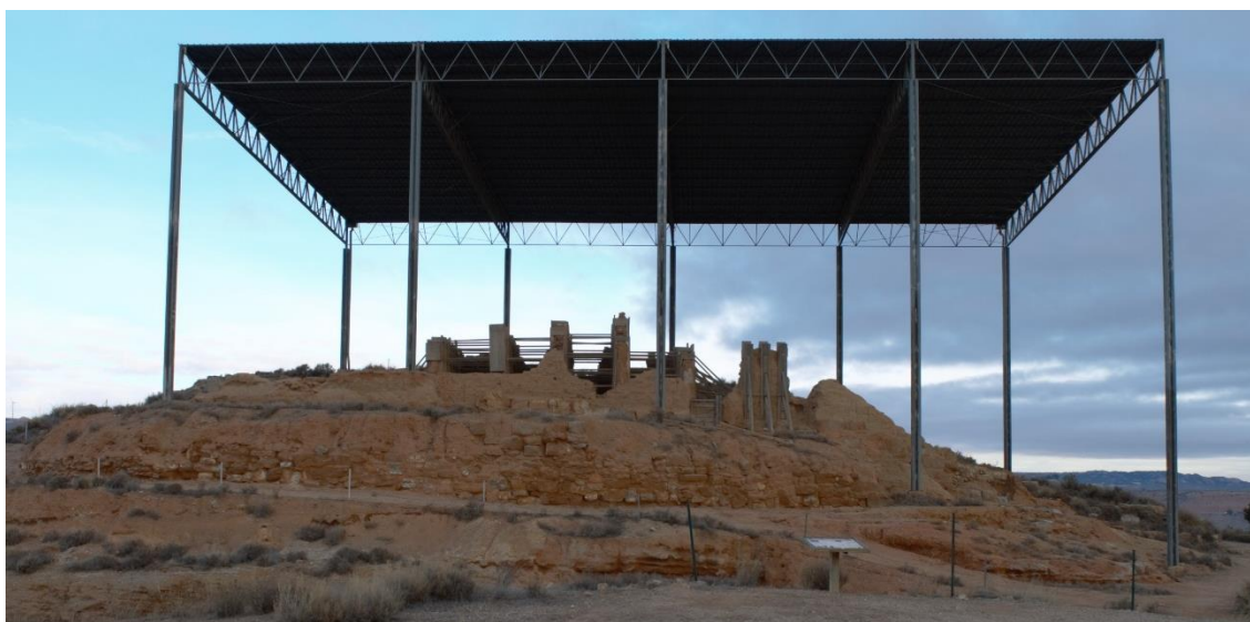
Fig. 183. Fotografía del estado actual de El Cabezo de las Minas.
