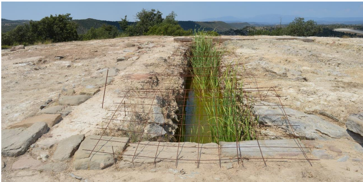
Fig. 113. Fotografía del estado actual de la cisterna de Puig Castellar de Biosca.
