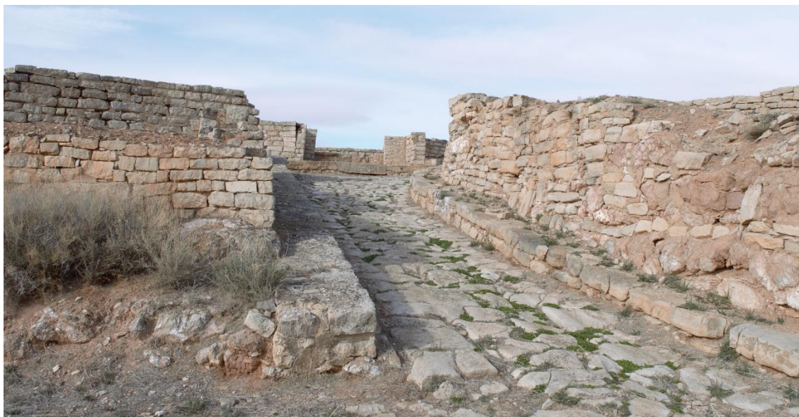
Fig. 179. Vista del sistema defensivo del Cabezo de Alcalá, concretamente de la entrada a la acrópolis.
