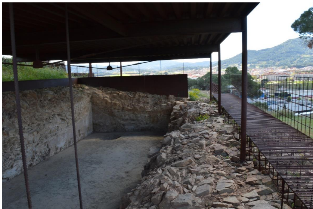
Fig. 26. Fotografía del estado actual de la cisterna 1 de Can Tacó.
