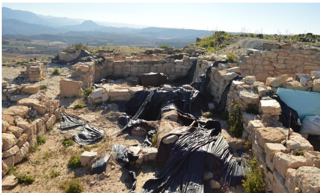
Fig. 61. Estado actual de las estructuras del Coll del Moro.
