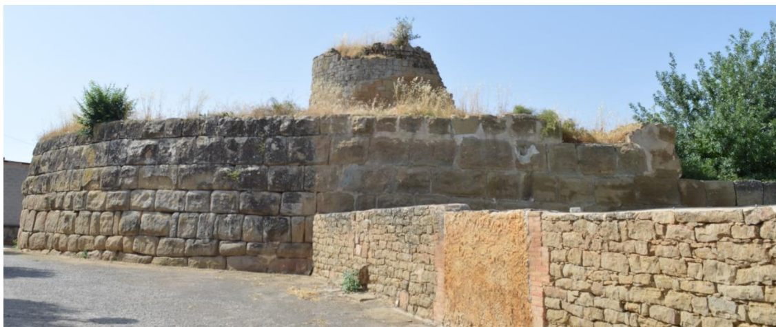
Fig. 33. Estado actual de la estructura de Castell Lliuró.
