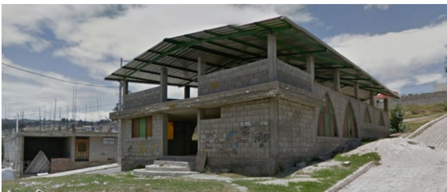
Figura 61. Estructura industrial tomada para reutilizarla en residencia.
