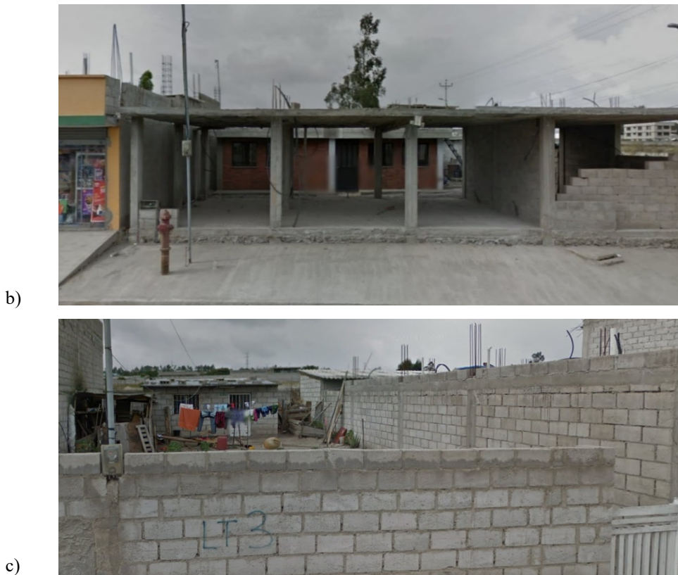
Figura 57. Propiedades con mediagua como origen de las edificaciones posteriores.
