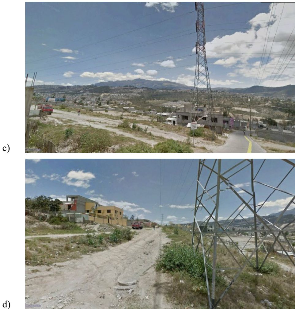
Figura 53. Asentamientos y caminos alrededor de plantas de tratamiento de agua potable (a y b) y torres de alta tensión (c y d), barrio Luz y Vida, cerca de la zona de estudio. Fuente: imágenes tomadas de GoogleEarth/Google Street Map (2021).
