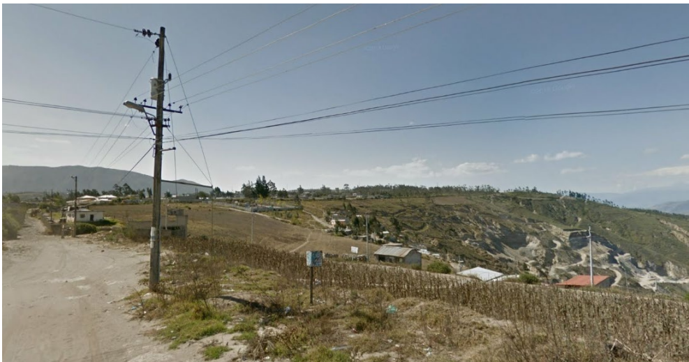
Figura 63. Tendido eléctrico domiciliario en zona de asentamientos dispersos.
