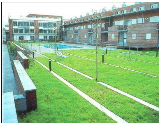
Figura 54. Espai comunitari de l'illa 6. (ConSORCI de la Vila Olímpica).
