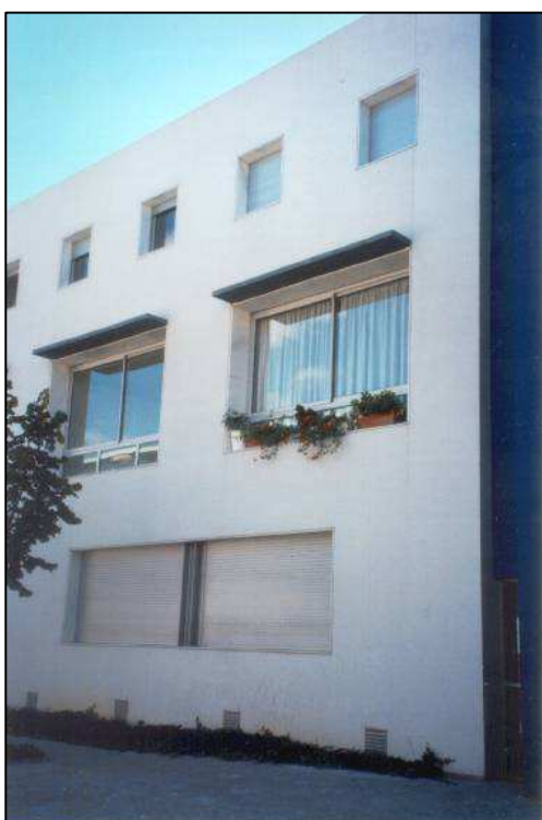
Figura 51. Illa 7. Vista des del carrer Francesc Macià.
