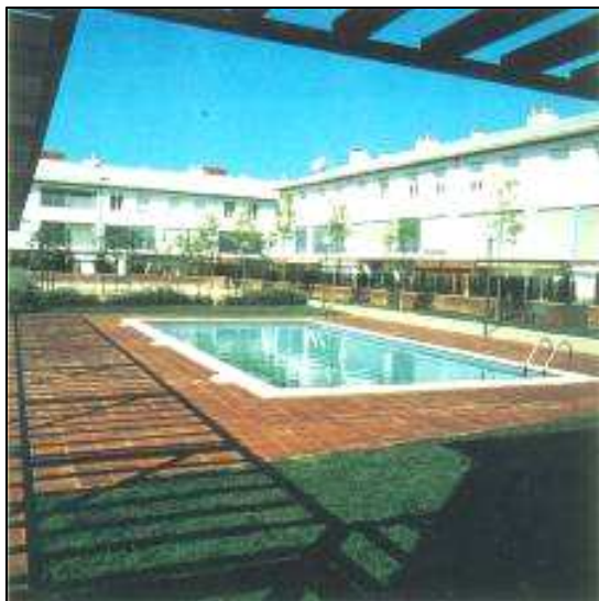
Figura 56. Espai comunitari de l'illa 5. (ConSORCI de la Vila Olímpica).
