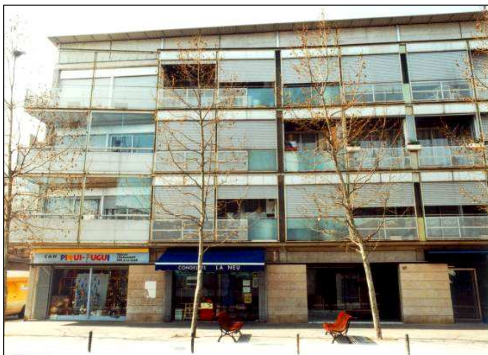
Figura 50. Illa 3. Vista des del carrer Alfons XIII.
