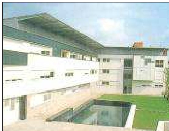
Figura 55. Espai comunitari de l'illa 10. (ConSORCI de la Vila Olímpica).
