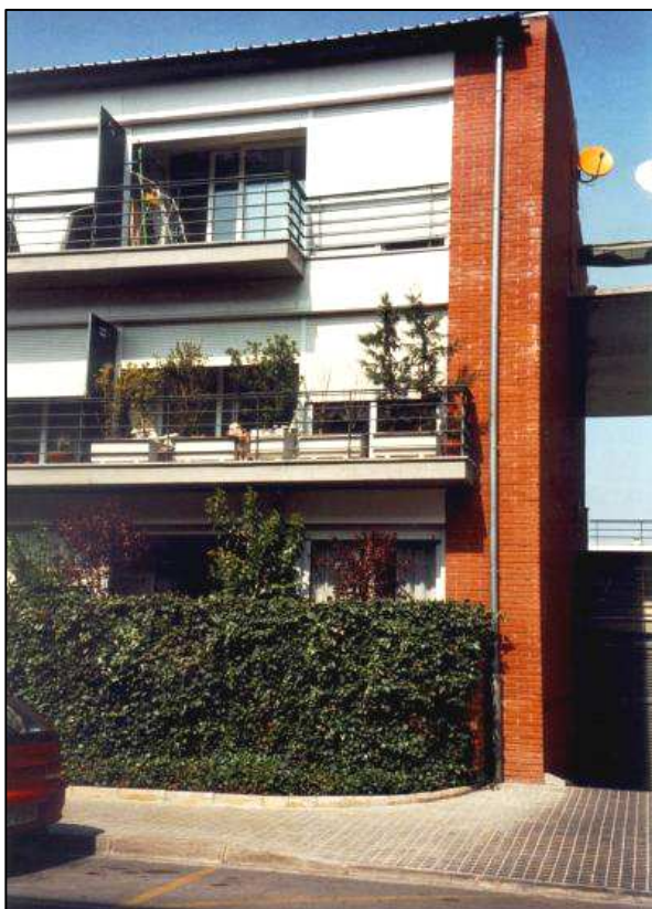
Figura 58. Exterior habitatge illa 6. Vista des del carrer Francesc Macià.
