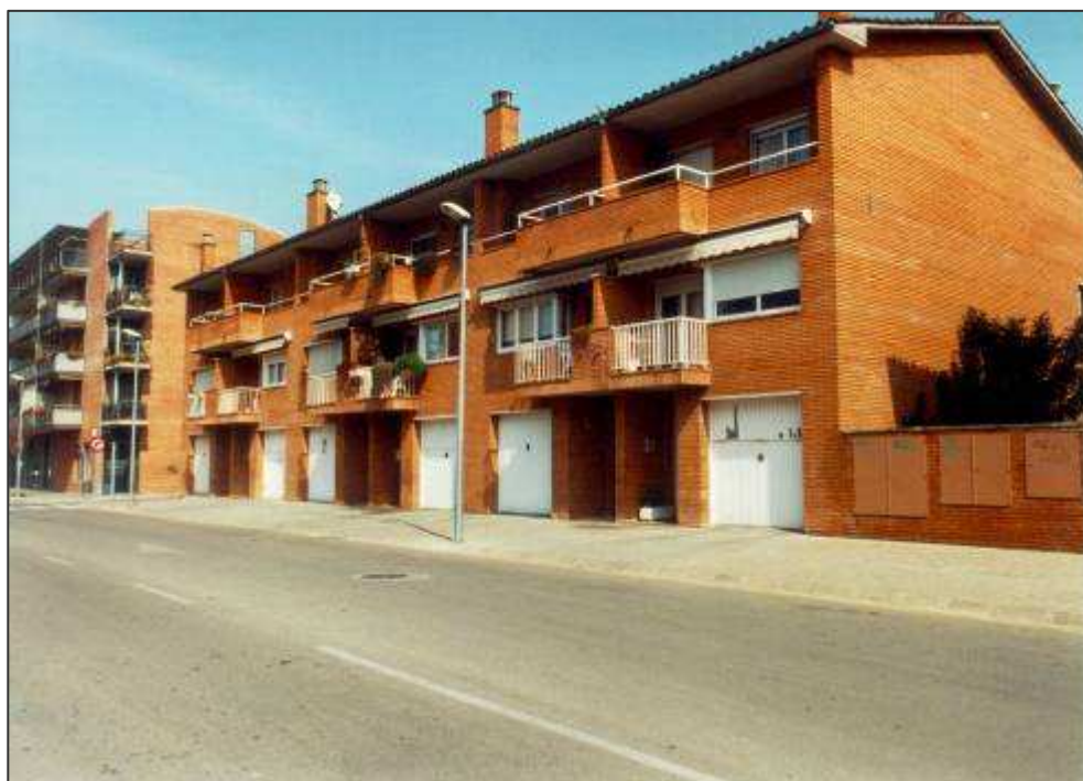
Figura 30. Habitatges unifamiliars Vista des del Passeig de la Generalitat
