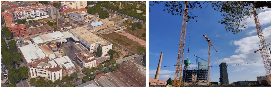
Il·lustració 36. A la dreta, l'illa de Can Ricart vista des del xamfrà de la Frigo de Martínez, sistemes i arquitectes associats (2018). A l'esquerra, les obres a les illes adjacents a Can Ricart a l'agost de 2021.
