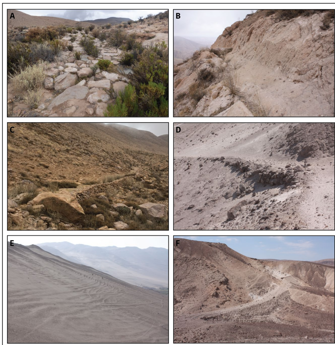
Figura 11. Acondicionamientos. A) empedrado, B) corte de ladera, C y D) terraplenes con muro de pirca seca (sierra y valles bajos), E y F) sin acondicionamientos (surcos múltiples y vía central con surcos menores).
