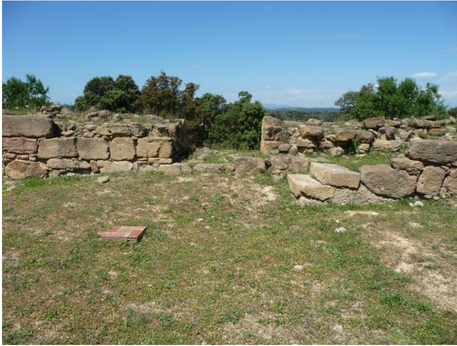
Figura 6.25: Poterna del palacio y escalera de acceso al adarve
