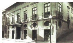
Casa da Companhia Geral da Agricultura das Vinhas do Alto Douro, na rua das Flores.
