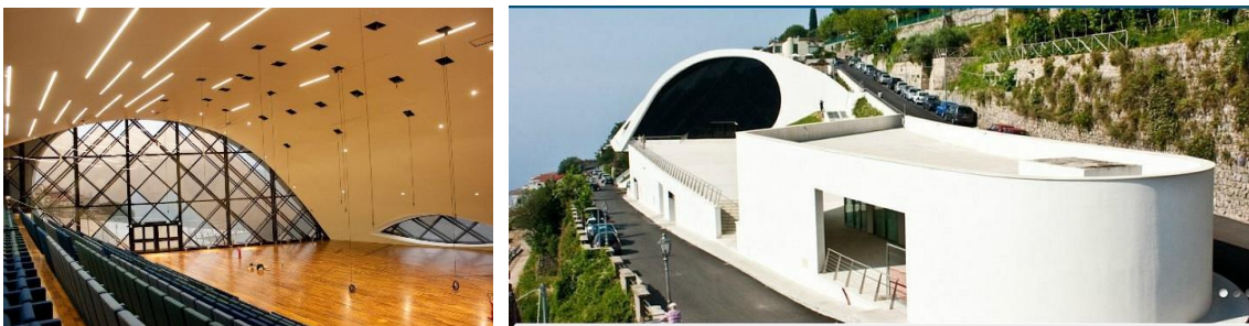
Figura 2.19. Interior y exterior del Auditorio de Ravello
