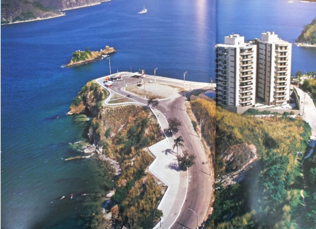
Figura 4.69. Mirador de Boa Viagem antes de la implantación del MAC
