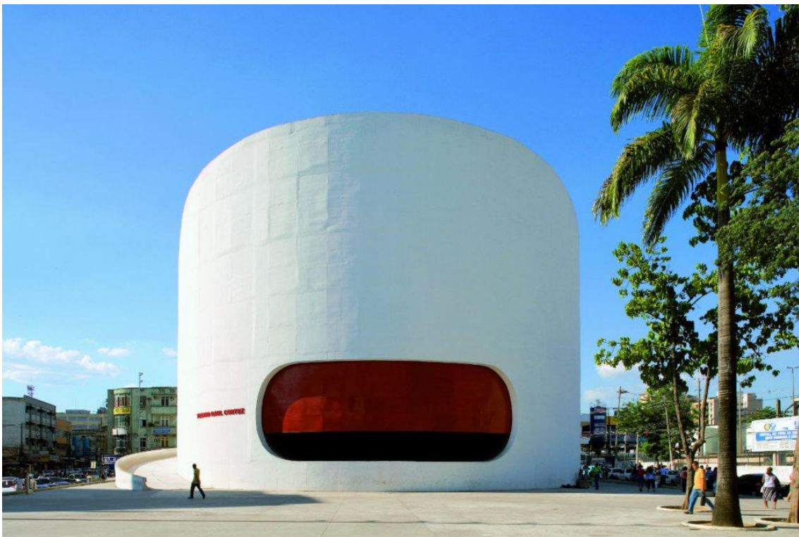
Figura 2.23. Exterior del Teatro Municipal Raul Cortez
