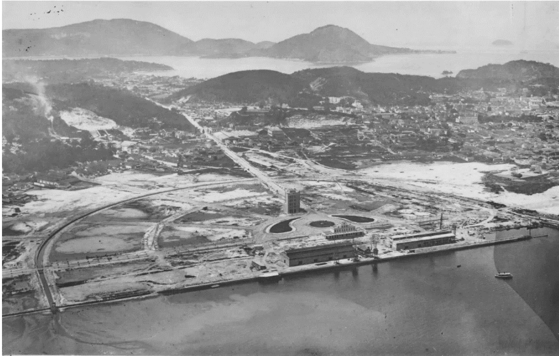
Figura 4.16. Obras del Puerto de São Lourenço
