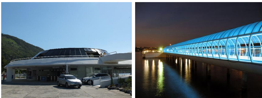
Figura 2.55. Cuerpo principal y acceso a barcas de la estación de Charitas
