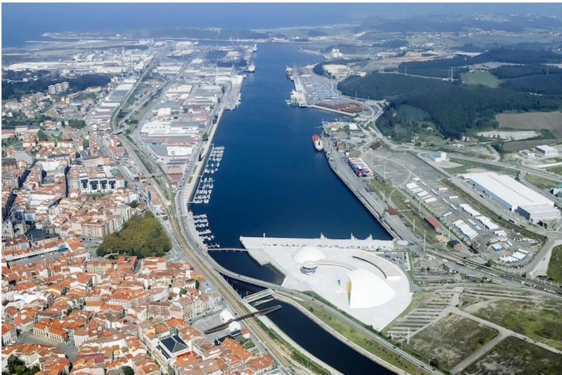
Figura 3.32. Imagen aérea en 2019, con la obra ya finalizada
