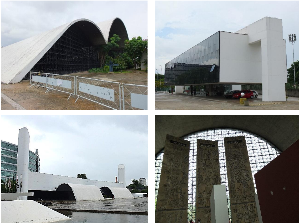
Figura 2.12. Auditorio, Edificio de Administración, Biblioteca y Salón de Actos (interior)
