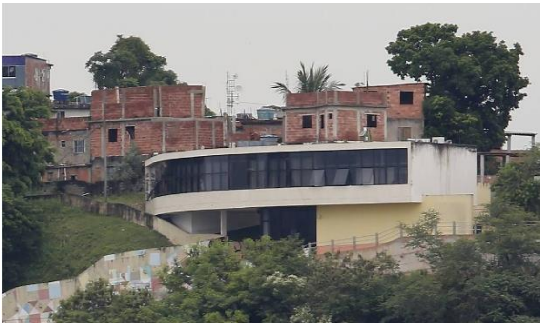
Figura 4.67. Verticalización en la favela Morro de Palacio, detrás del MACquinho
