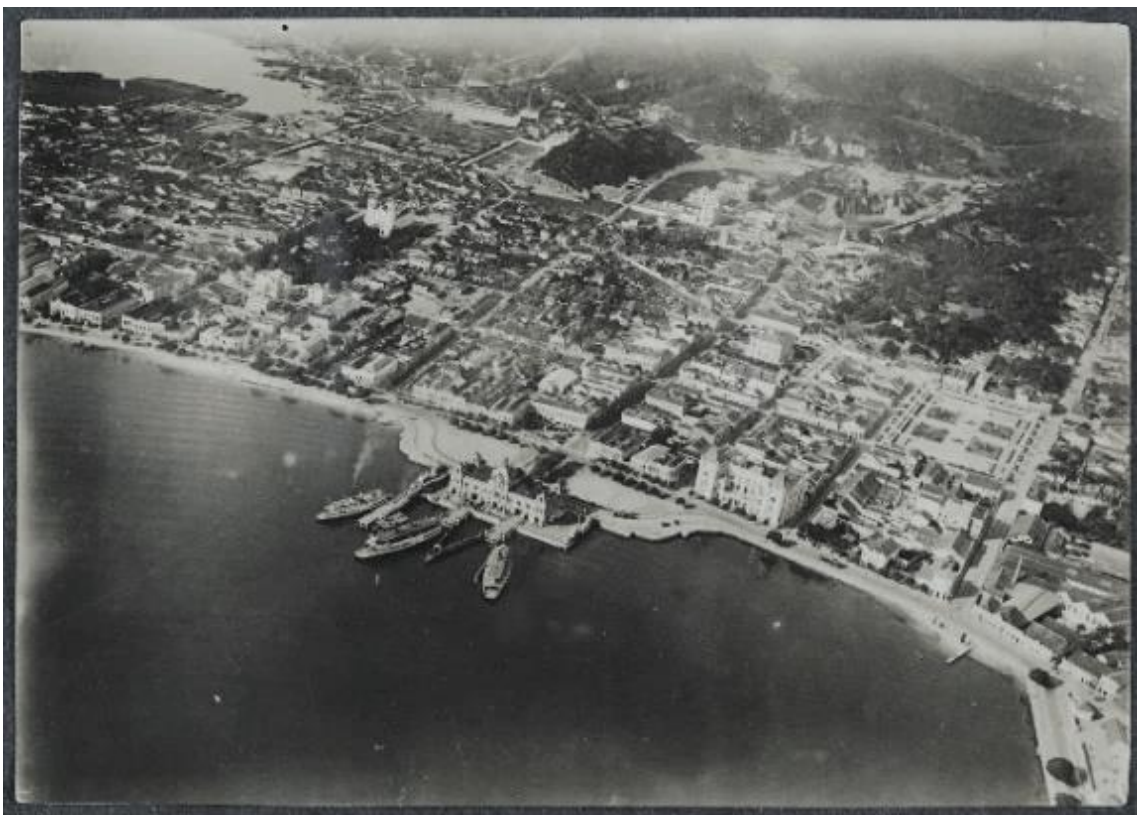
Figura 4.6. Vista general de la zona centro de Niterói antes del relleno de Praia Grande
