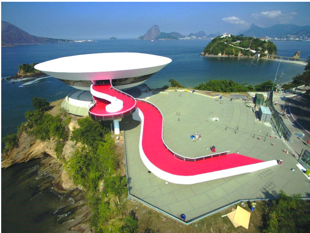
Figura 4.70. Mirador de Boa Viagem después de la implantación del MAC
