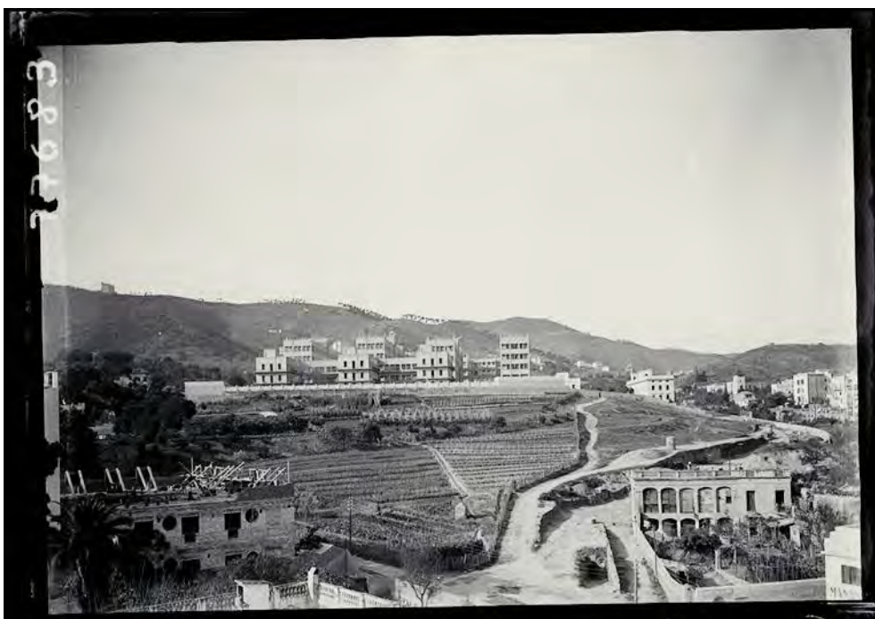
Nuevo Hospital Militar de Barcelona. Vista de las obras. Fechas: 11.09.1936 - 13.09.1936 Fuente: ANC1- 42- n -14713 - firma 077683
