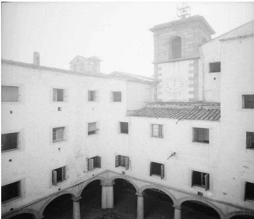
Hospital Militar de Barcelona, después de ser desalojado, antes de su derribo. Patio interior.
