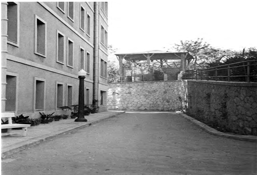
H.M. del Generalísimo - Hospital en construcción Fuente: ANC1 - 42 - n -34785 - foto 1 - firma 000068(3) T. (1-4) – Desde el 01.03.1939 al 31.12.1942
