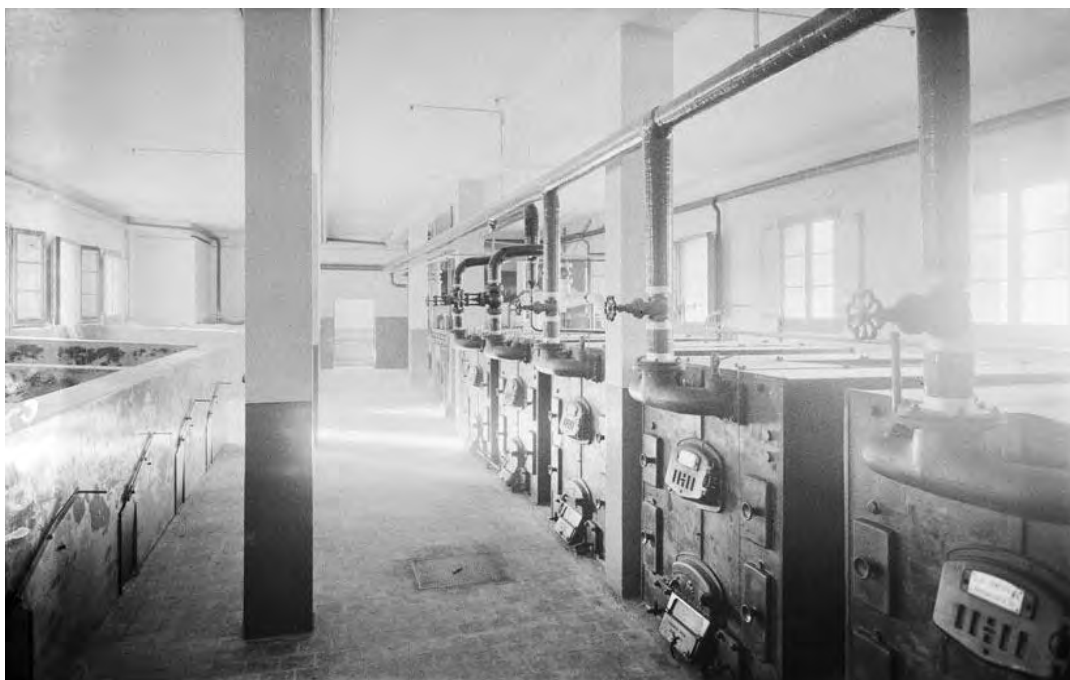
H.M. del Generalísimo - Hospital en construcción - Sala de máquinas Fuente: ANC1 - 42 - n -15532 - firma 075661 – Desde el 01.01.1936 al 31.12.1936
