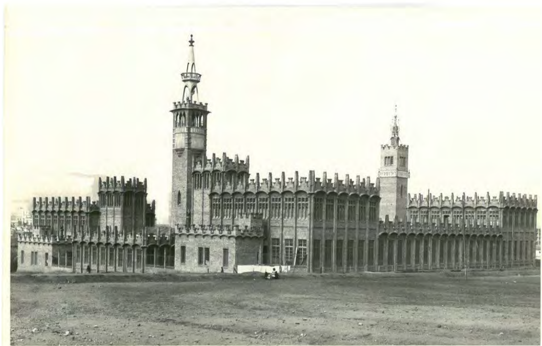
Fábrica Casarramona, ofrecida como sede para Hospital Militar por Casimiro Casarramona. Fachada del edificio. Foto núm. 18. Año 1923 Fuente: A.G.M.S. 3ª Sección, 3ª división, legajo 422
