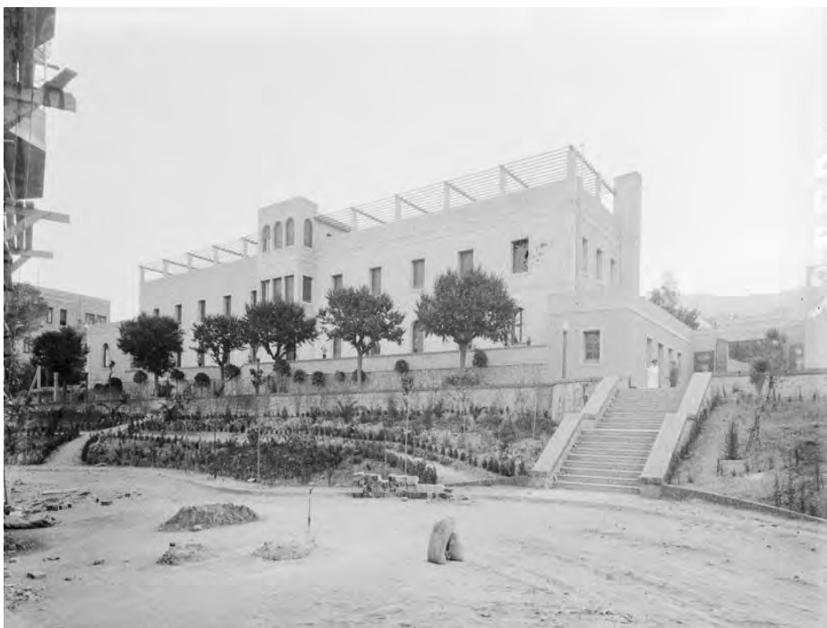
Nuevo Hospital Militar de Barcelona. Construcción del pabellón de las Hermanas. Fechas: 01.01.1936 - 31.12.1936 Fuente: ANC1- 42- n -155331 - firma 075660
