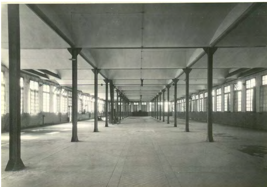
Fábrica Casarramona. Sala de hilados. Foto nº 14. Año 1923
