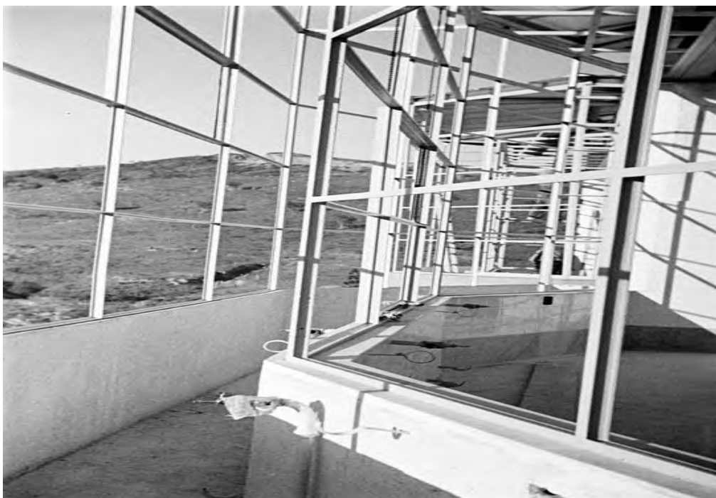
Hospital Militar del Generalísimo - Hospital en construcción Fuente: ANC1 - 42 - n -34785 - firma 000068(3) T.(1-4) – Desde el 01.03.1939 al 31.12.1942
