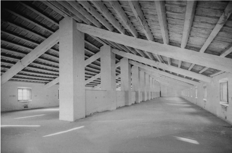
Hospital Militar de Barcelona después de ser desalojado y antes de su derribo. Buhardilla en la techumbre.
