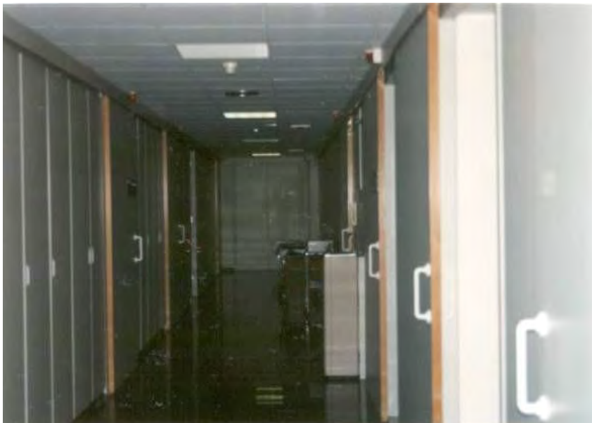
Hospital Militar de Barcelona. Pabellón cirugía 1 y 2 Bis, pasillo Fuente: INVIED
