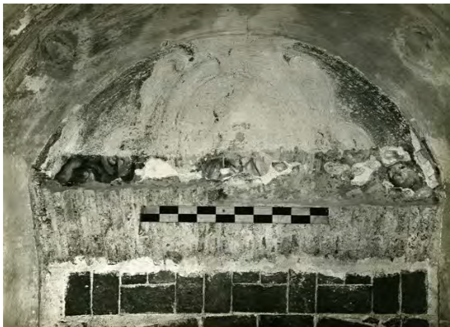
Rehabilitación Iglesia H.M. calle Tallers. Fecha siete de agosto de 1947 Autor: Francesc Ribera Colomer Fuente: Archivo fotográfico Barcelona. Urb _ 0544 (pinturas altar lateral)
