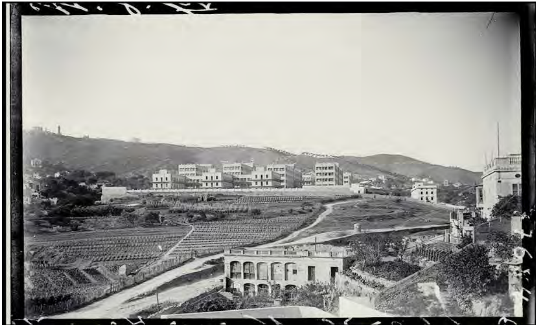
Nuevo Hospital Militar de Barcelona. Vista de las obras en Vallcarca. Fechas: 11.09.1936 - 13.09.1936 Fuente: ANC1- 42- n -14715 - firma 077685
