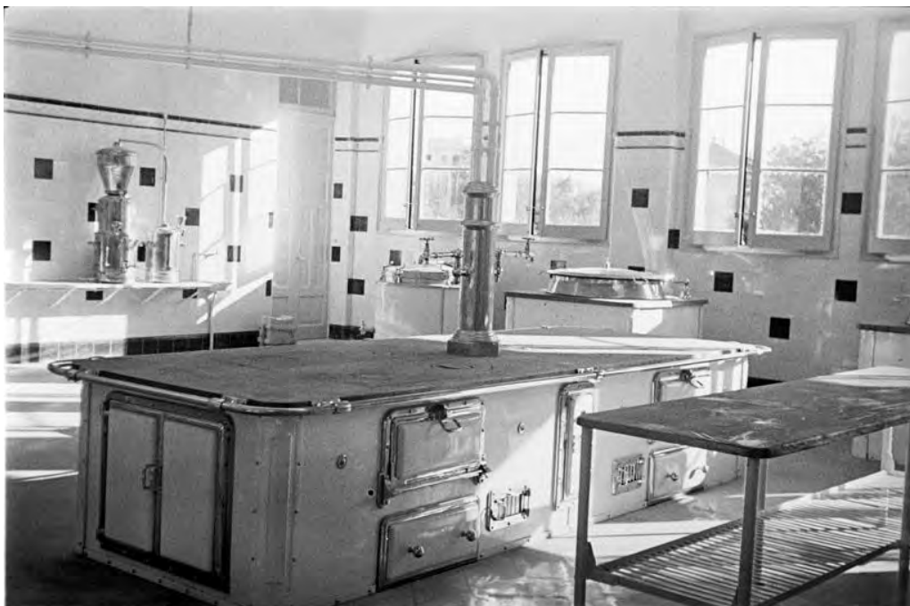
H.M. del Generalísimo - Hospital en construcción (futura cocina) Fuente: ANC1 - 42 - n -34785 - firma 000068(3) T.(1-4) – Desde el 01.03.1939 al 31.12.1942
