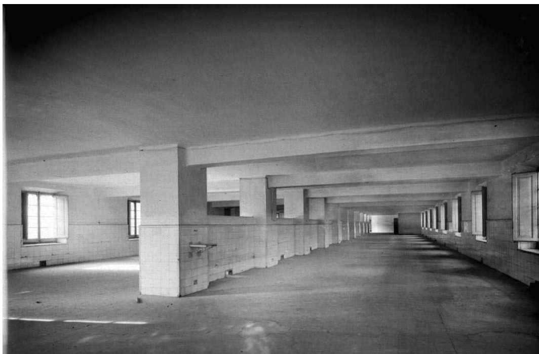
Hospital Militar de Barcelona, ubicado en el antiguo convento de los Padres Paúles en la calle de Tallers, después de ser desalojado y antes de su derribo. Fuente: ANC1-42-N-15523, firma 062151. Fechas desde 01.01.1940 al 31.12.1942
