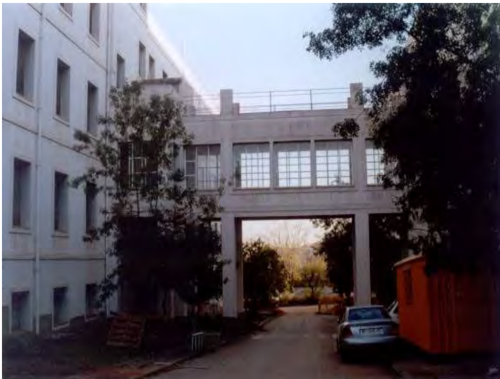
Hospital Militar de Barcelona. Conexión entre pabellones Fuente: INVIED
