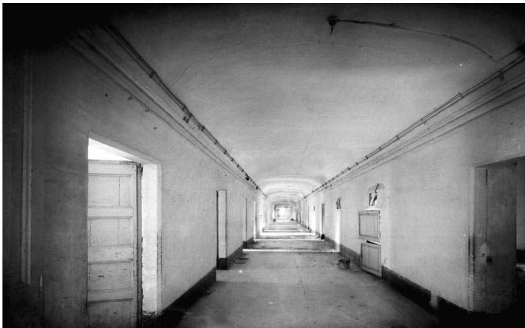
Hospital Militar de Barcelona, después de ser desalojado y antes de su derribo. Pasillo con antiguas celdas del Seminario. Fuente: ANC1-42-N-15522, firma 062150. Fechas desde 01.01.1940 al 31.12.1942
