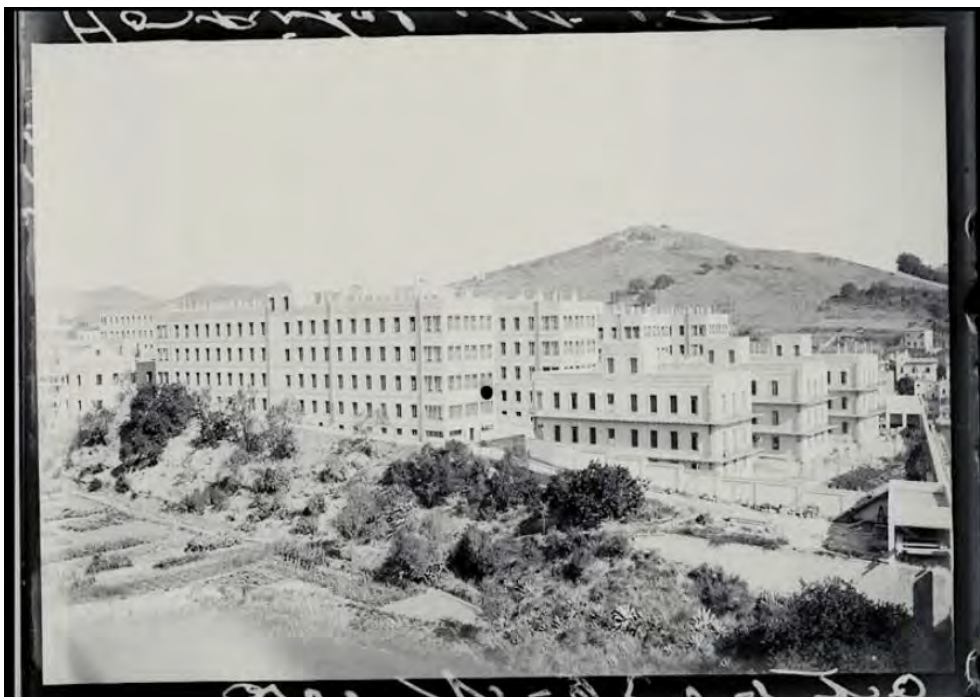
Nuevo Hospital Militar de Barcelona. Vista de las obras. Fechas: 11.09.1936 - 13.09.1936 Fuente: ANC1- 42- n -14712 - firma 077682.
