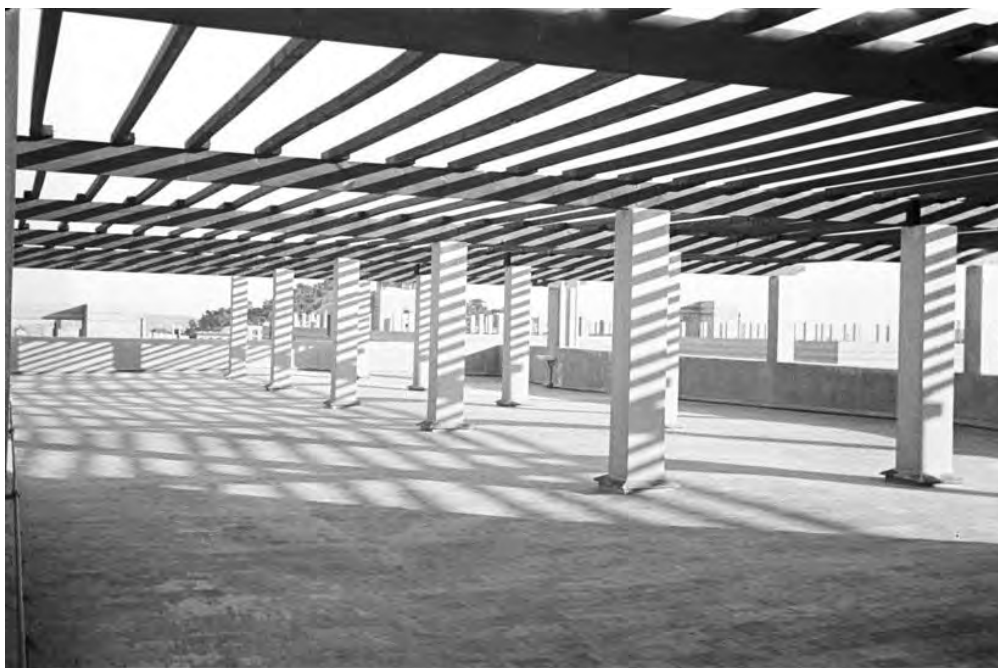
Hospital Militar del Generalísimo - Hospital en construcción
