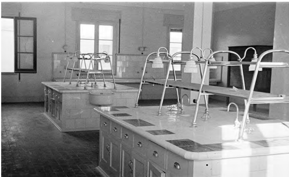
Hospital Militar del Generalísimo. Futuro laboratorio, en construcción. Fuente: ANC1 – 42 – n -34785 – foto 6 - firma 000068(3) T.(1-4) – Desde el 01.03.1939 al 31.12.1942
