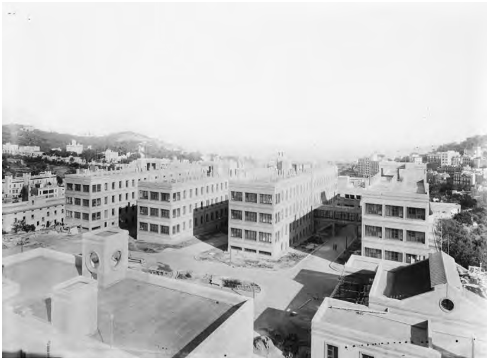
Nuevo Hospital Militar de Barcelona. Pabellones en construcción Fechas: 01.01.1936 - 31.12.1936 Fuente: ANC1- 42- n -15530 - firma 075659
