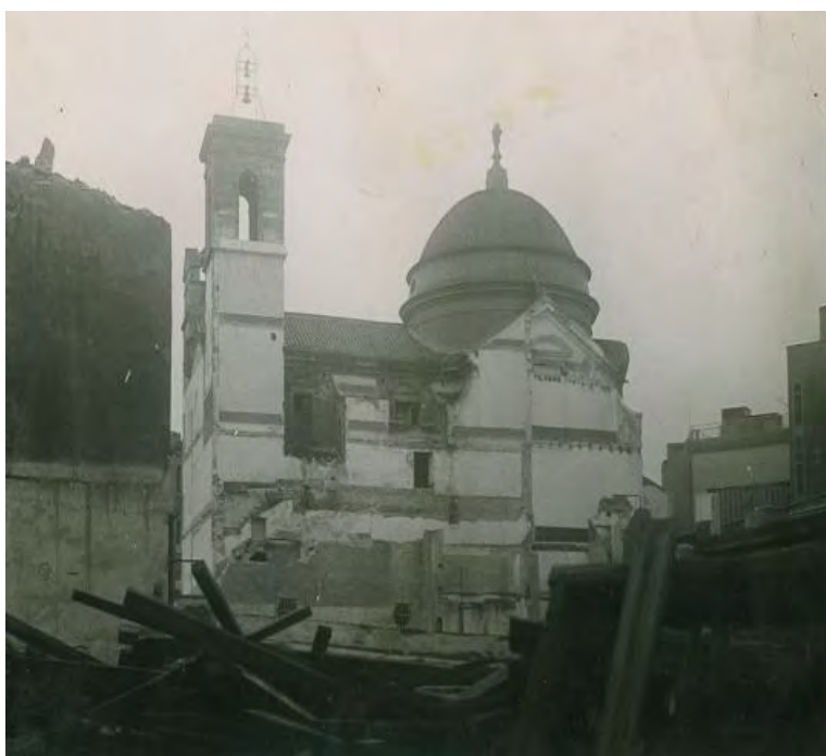
Derribo antiguo Hospital Militar Barcelona. Destrucción prevista desde 1905. Fuente: Archivo fotográfico Barcelona (A.F.B.) - C_038_185
