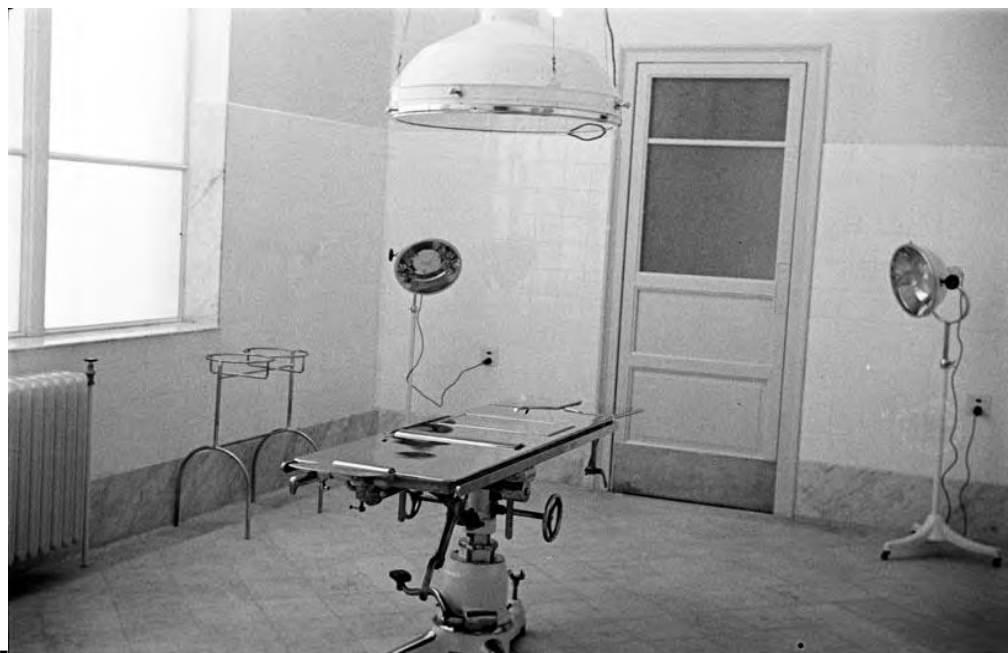
Hospital Militar del Generalísimo - Hospital en construcción (futuro quirófano)
