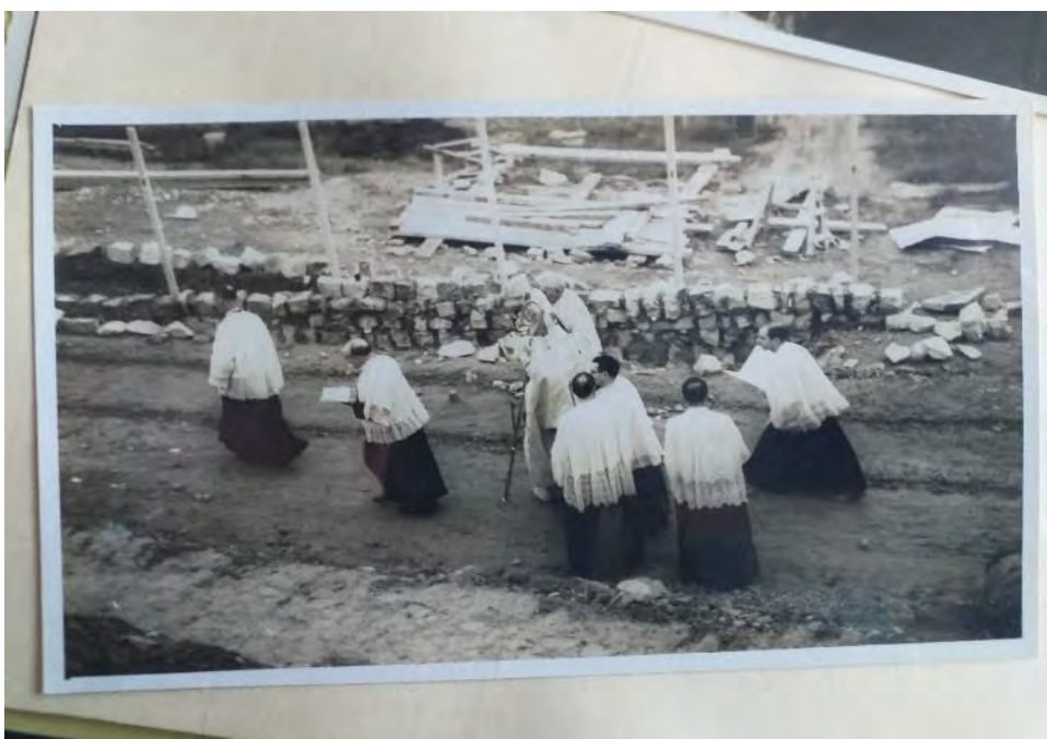
El administrador apostólico, Miguel de los Santos Díaz Gomara, finalizada la inauguración oficial y colocación de la Primera Piedra de la Capilla central. Fuente: Archivo de las Hijas de la Caridad - fotos
