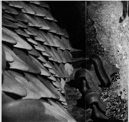
Casa Batlló del Paseo de Gracia, Barcelona. Detalles de los tejados.
