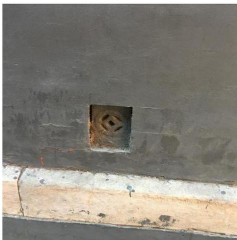
Figura 61. Salidas de aire en la pared. Propia.
