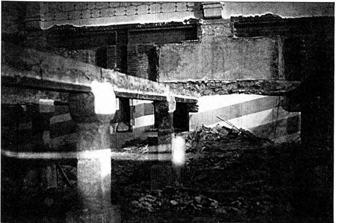
Novembre de 1990. S'aixeca el doble terra i es treuen les bigues de fusta i els pilars de pedra de 1393.
