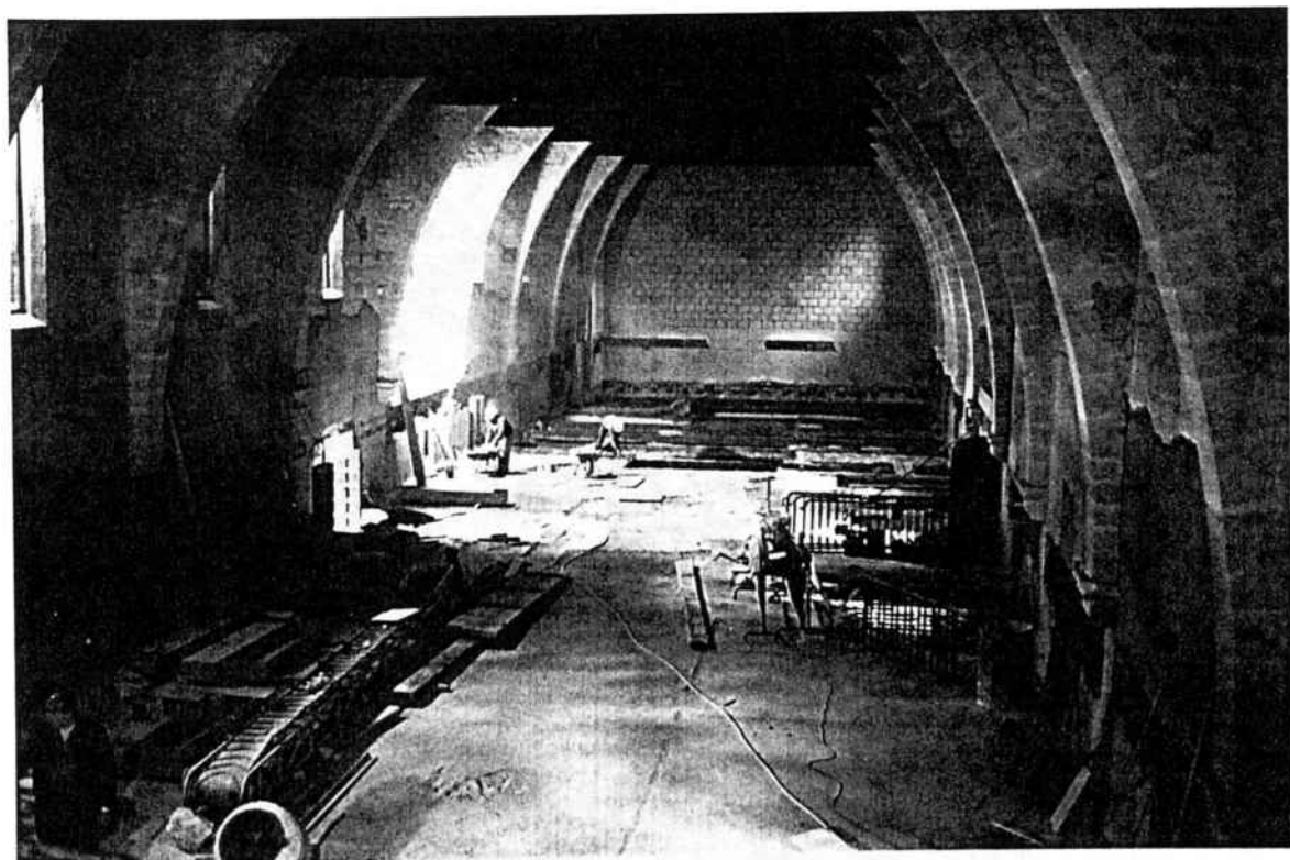
Novembre de 1990. La finestra és cegada i l'escala també. El sòl comença a aixecar-se.
