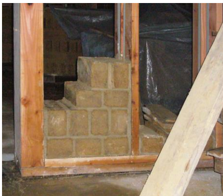
Figure 17 Murs de refend en ossature bois et remplissage BTC (©Le moniteur (première photo)).
