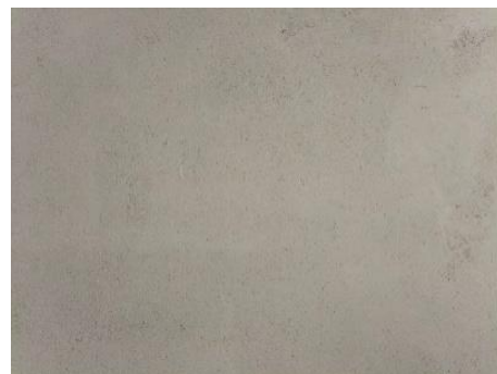
Enduit terre (après)
