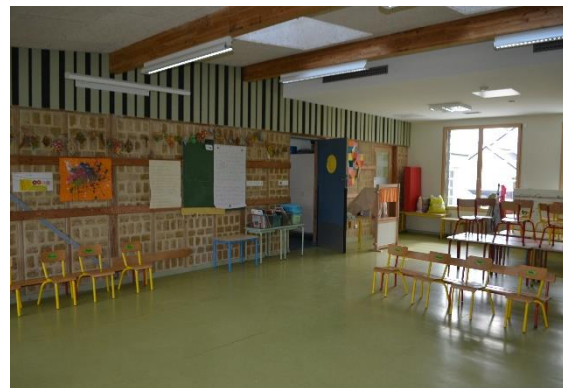
Figure 17 Murs de refend en ossature bois et remplissage BTC (©Le moniteur (première photo)).
