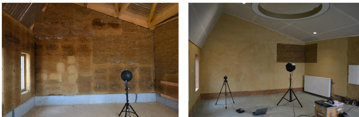
Figure 95 État de parois de la bibliothèque avec et sans enduit.
