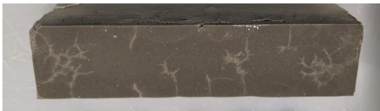
Figura 35. Muestra de mortero VL-mix D#3. Se observan múltiples fisuras en la superficie relación A/P =0.3.
