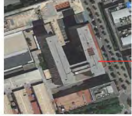
VISTA AEREA DENTRO DEL CAMPUS
