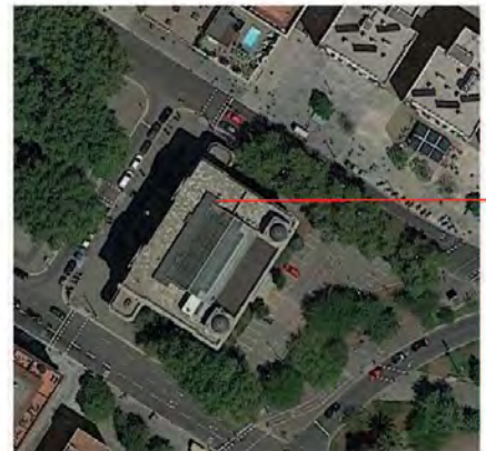
VISTA AEREA DENTRO DEL CAMPUS
