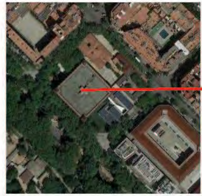
VISTA AEREA DENTRO DEL CAMPUS
