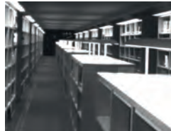
PLANTA BAJA – PASILLO 3 FOTO 19
