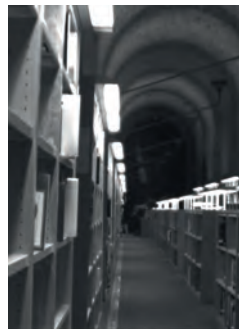
PLANTA 2 – PASILLO 1 FOTO 25
