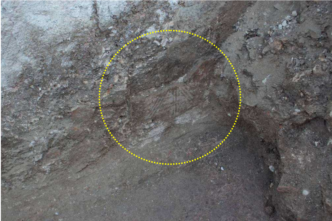
Figura 45. Vista de uno de los ladrillos de regularización del paramento interno del corredor septentrional de la palestra. Obsérvense las digitaciones radiales que servían para aumentar la adherencia de las capas pictóricas. Fotografía del autor.
