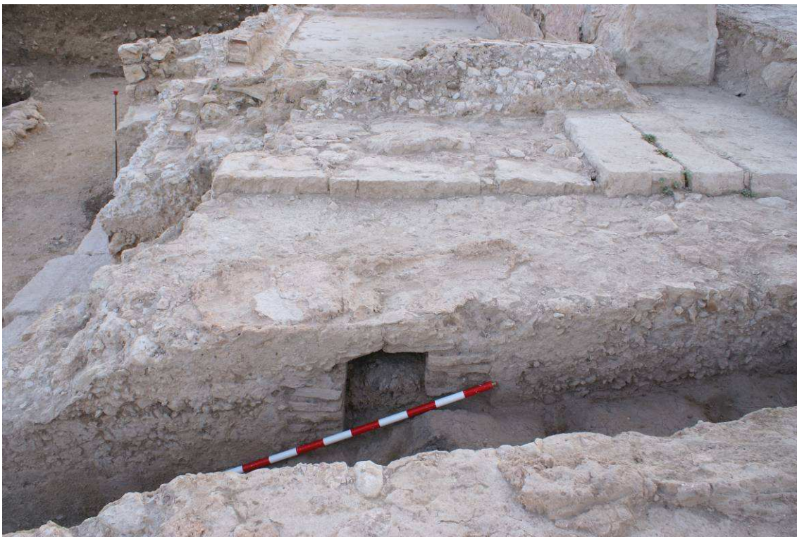
Figura 88. Imagen del encuentro entre el desagüe original de la piscina y el canal de evacuación principal del edificio termal. Fotografía del autor.
