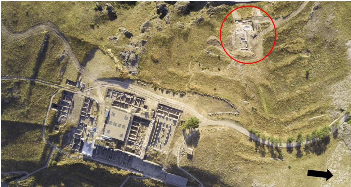
Figura 24. Vista cenital del área forense de Valeria y su relación espacial con el complejo termal (indicado mediante círculo rojo). Elaboración del autor a partir de fotografía de Jorge Yagües Martín.
