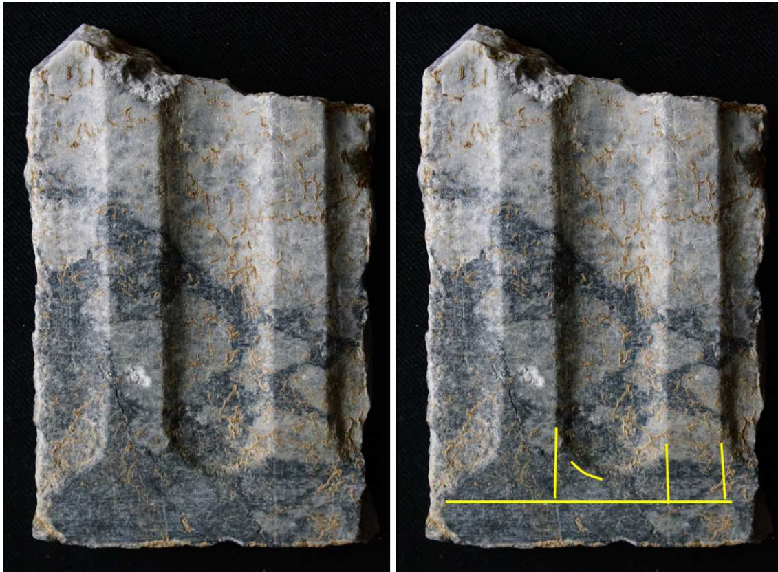
Figura 334. Fragmento basal de fuste acanalado de lesena en el que todavía se pueden apreciar parte de los trazos preparatorio para el diseño de la decoración. Fotografías y elaboración del autor.
