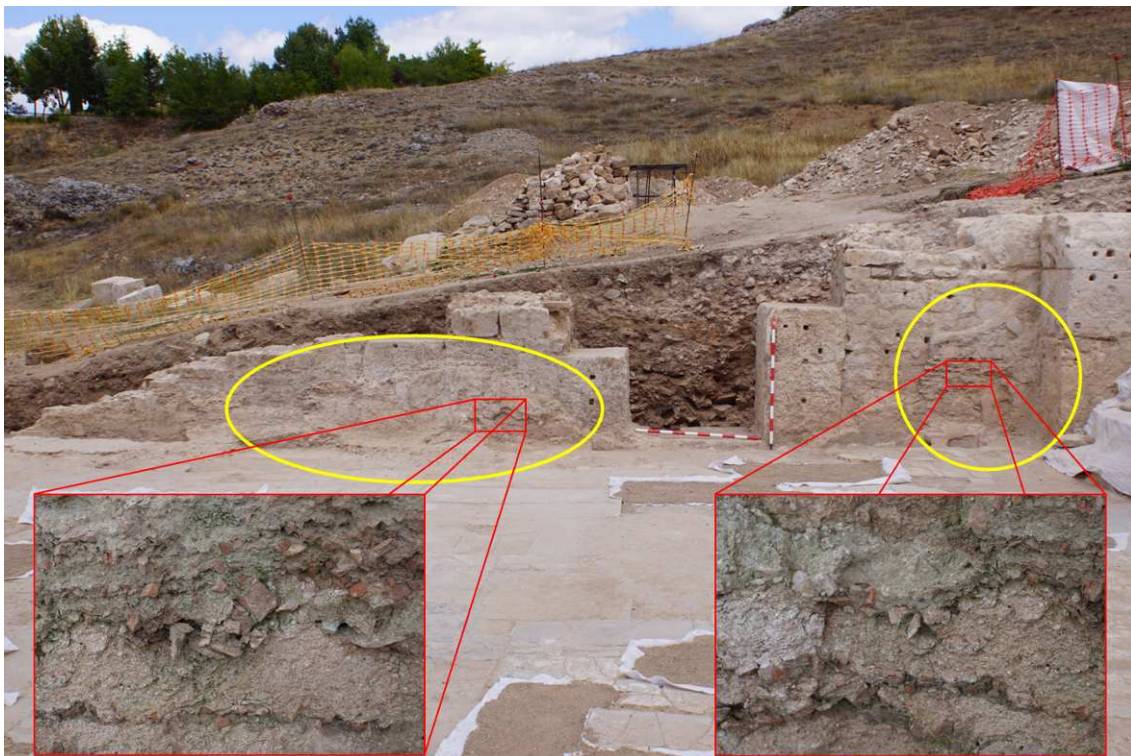
Figura 303. Vista del CF-4 desde la parte central del vestibulum. Los círculos amarillos señalan las zonas en las que se ha conservado la capa de mortero de agarre. En la parte inferior, las imágenes en detalle de dos zonas donde se observan descartes de labra marmórea amalgamados con el mortero. Fotografías y elaboración del autor.
