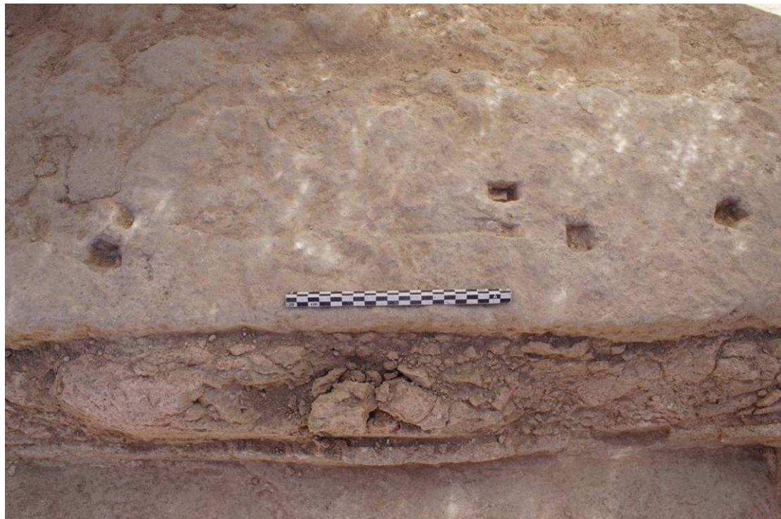
Figura 93. Vista cenital de la capa de mortero que se interpone entre la fábrica de obra de los peldaños y las placas marmóreas de revestimiento externo. Fotografía del autor.
