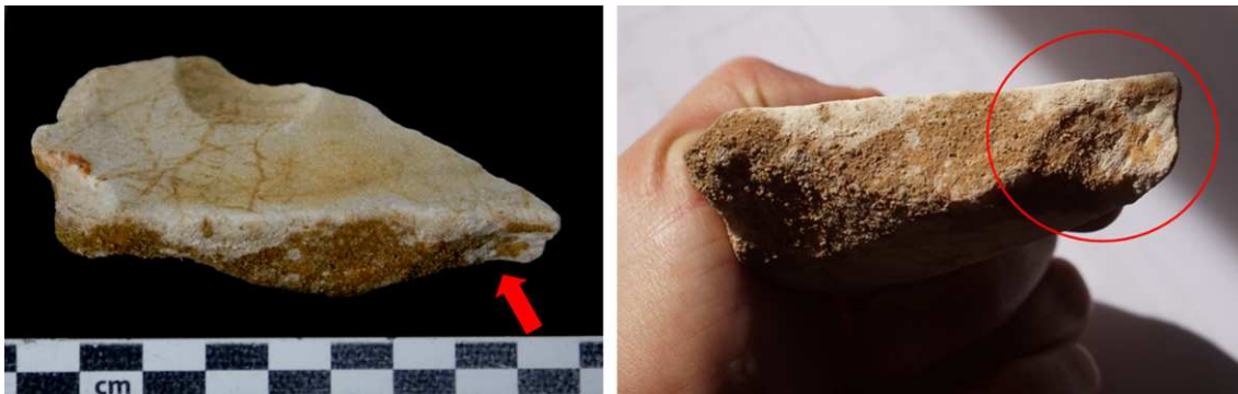
Figura 314. Ejemplo de pieza que presenta un cajeado en una de sus caras perimetrales labrado con cincel dentado o gradina. Fotografías y elaboración del autor.
