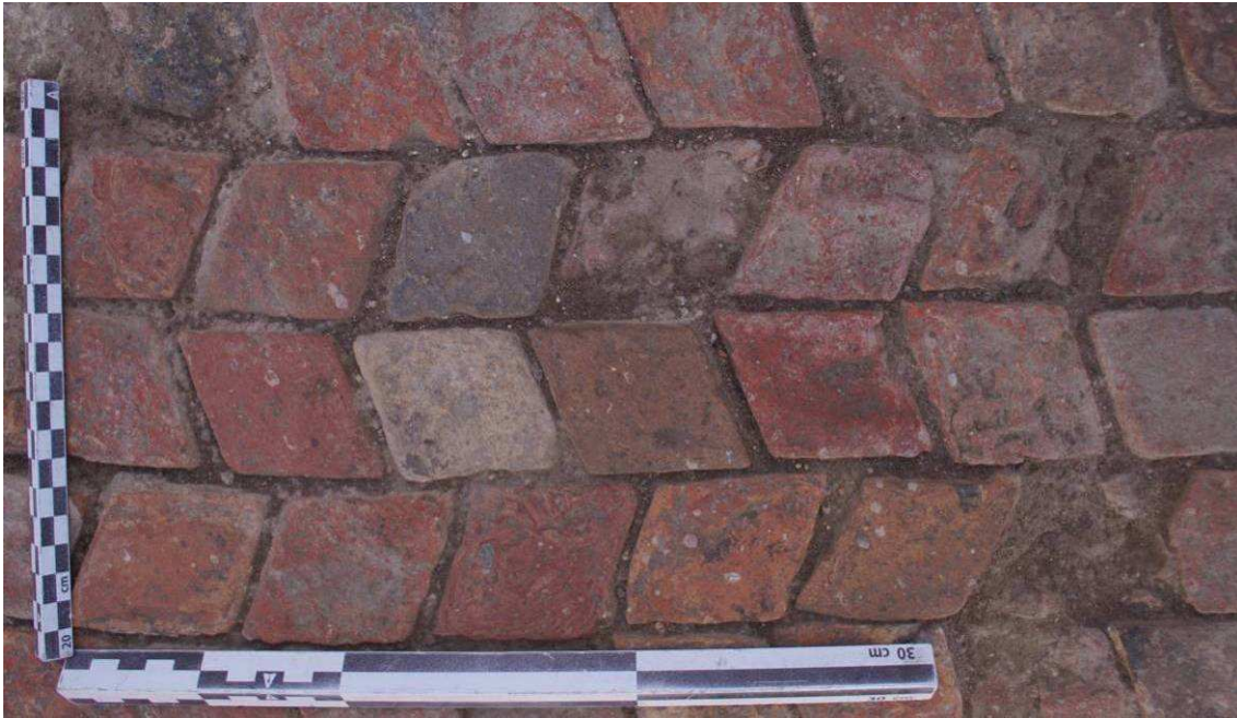
Figura 49. Detalle del pavimento localizado en la parte central de la palestra elaborado a base de piezas cerámicas romboidales. Fotografía del autor.
