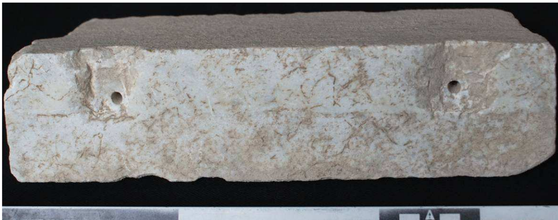
Figura 319. Vista de la cara frontal de un fragmento de cornisa de coronación con dos agujeros de trépano practicados en el lecho de sendos cajeados labrados con puntero. Fotografía del autor.
