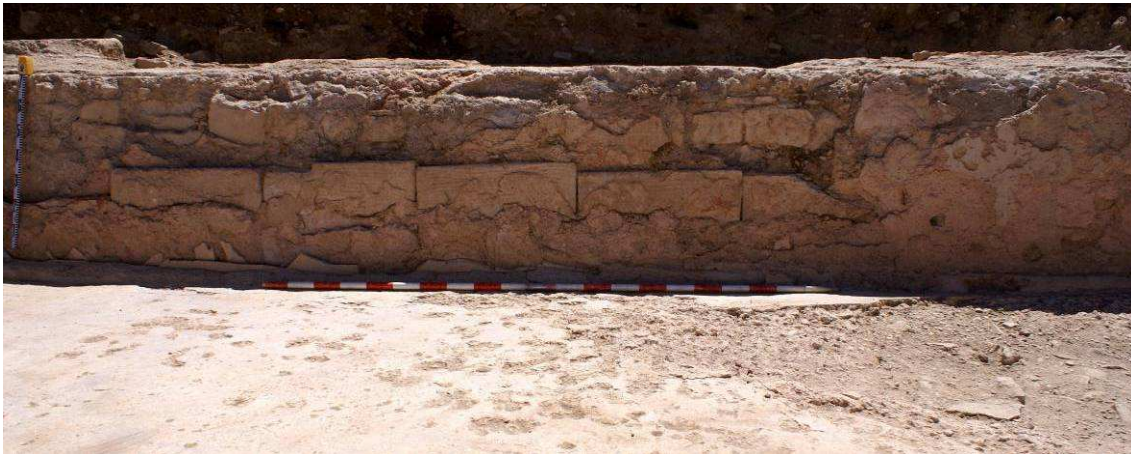
Figura 82. Vista del lado oriental del vaso de la piscina. Obsérvense las diferentes capas de preparación del soporte, los elementos cerámicos que regularizan el paramento y los restos de las placas marmóreas de revestimiento. Fotografía del autor.
