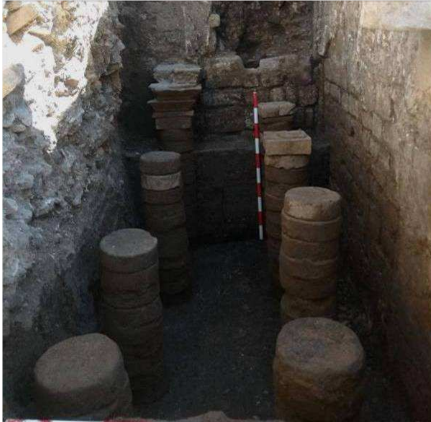
Figura 20. Aspecto de las pilae del hipocausto localizado en el sondeo realizado en el ambiente situado al norte del frigidarium . Foto del autor.
