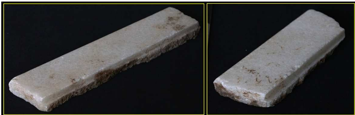
Figura 224. Ejemplos de molduras en forma de baquetón con la cara posterior de las piezas definidas parcialmente con un corte de sierra. Fotografías del autor.
