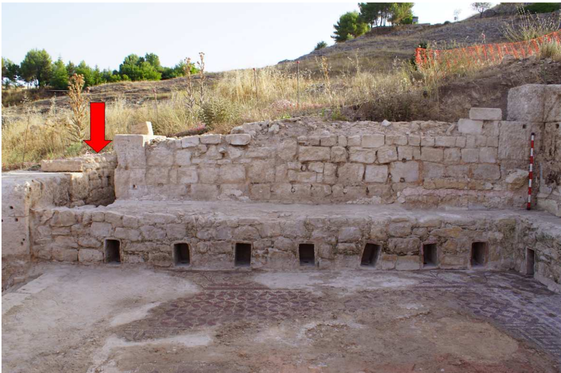
Figura 101. Vista del estado de conservación del CF-4 desde el punto central del apodytherium . La flecha indica la ubicación del vano de acceso a las estancias septentrionales. Fotografía del autor.
