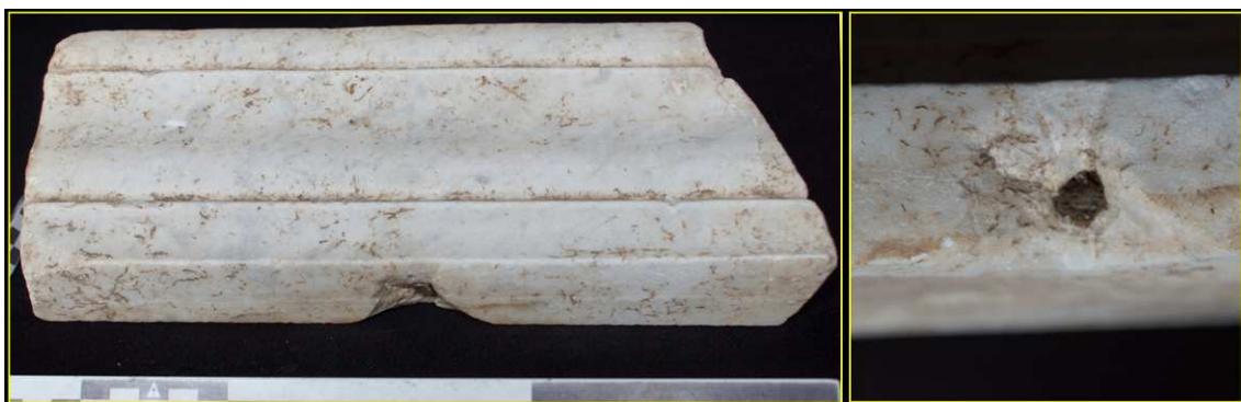
Figura 277. En el lado izquierdo, vista de la cara inferior de la cornisa de coronación del tipo 3. A la derecha, vista en detalle del rebaje labrado y de los restos de la espiga metálica todavía in situ , inserta en un agujero de trépano. Fotografías del autor.
