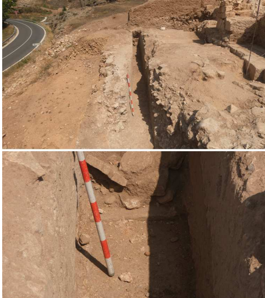
Figura 137. En la parte superior, vista general del tramo de cloaca localizado en el Ambiente 6. La imagen inferior muestra la parte inferior de la cloaca, en la que se puede observar cómo todavía permanece in situ una tegula como revestimiento del fondo. Fotografías del autor.
