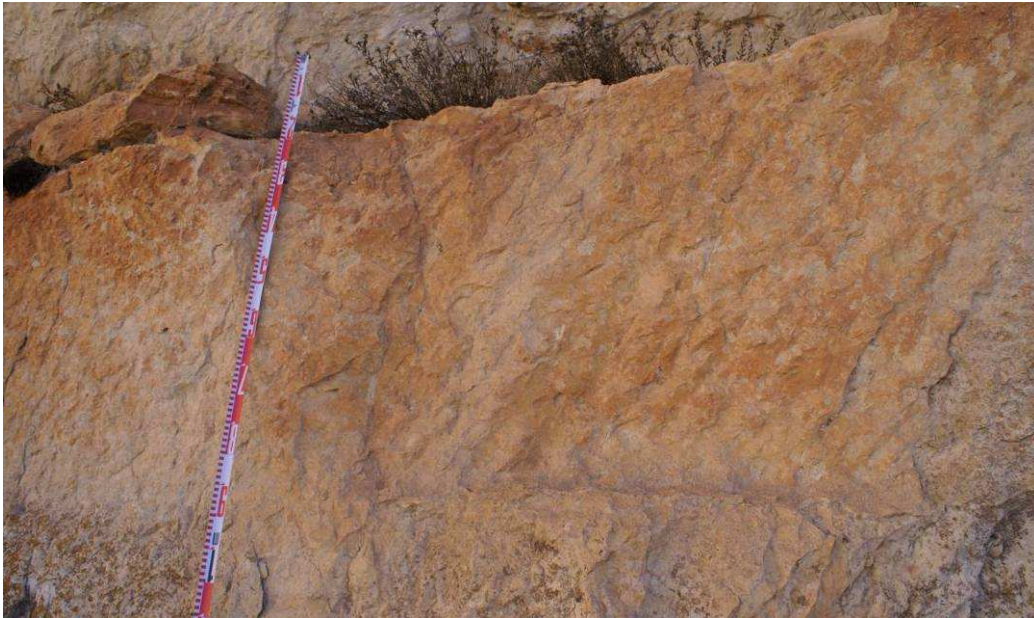
Figura 195. Vista de uno de los frentes de extracción cercanos a Valeria donde se puede observar su superficie cubierta por surcos dejados por la herramienta utilizada, así como la impronta en negativo de uno de los bloques extraídos. Fotografía del autor.
