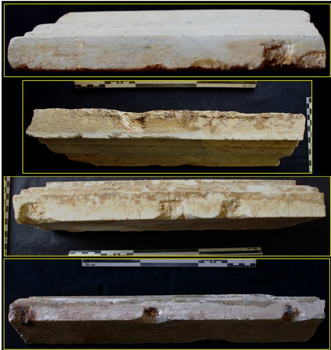
Figura 266. Vista de algunos ejemplos de rebajes labrados en las caras inferiores de algunas cornisas de coronación del tipo 1. Fotografías del autor.
