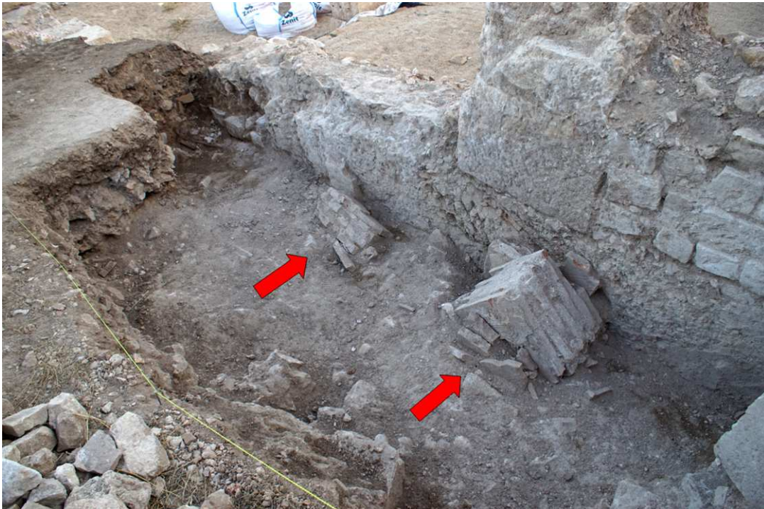
Figura 118. Fragmentos de cadenas de ladrillos de bóveda, pertenecientes a la cubrición del apodythreium , localizados durante la campaña de 2021 caídos sobre el pavimento del corredor porticado septentrional. Fotografía del autor.
