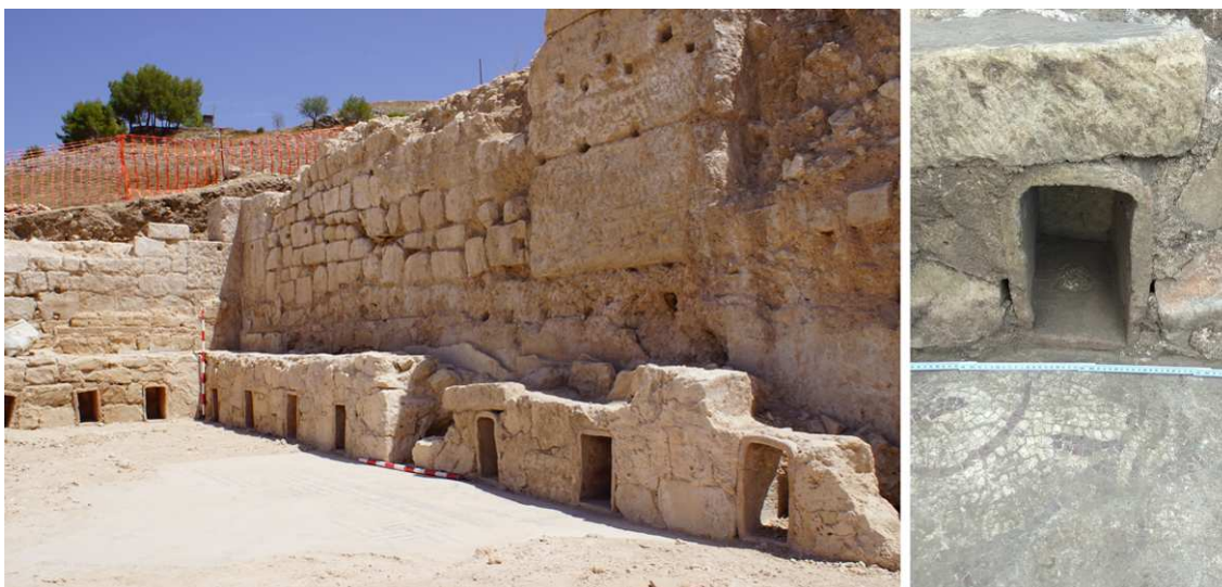
Figura 107. La imagen de la izquierda muestra el aspecto del rebanco corrido adosado a los muros interiores del apodytherium y su estructura interna en la que se insertan tubuli latericii cerámicos. La imagen de la derecha muestra un detalle de cómo el la estructura del rebanco se apoya en el pavimento musivo, al que cubre parcialmente. Fotografías del autor.
