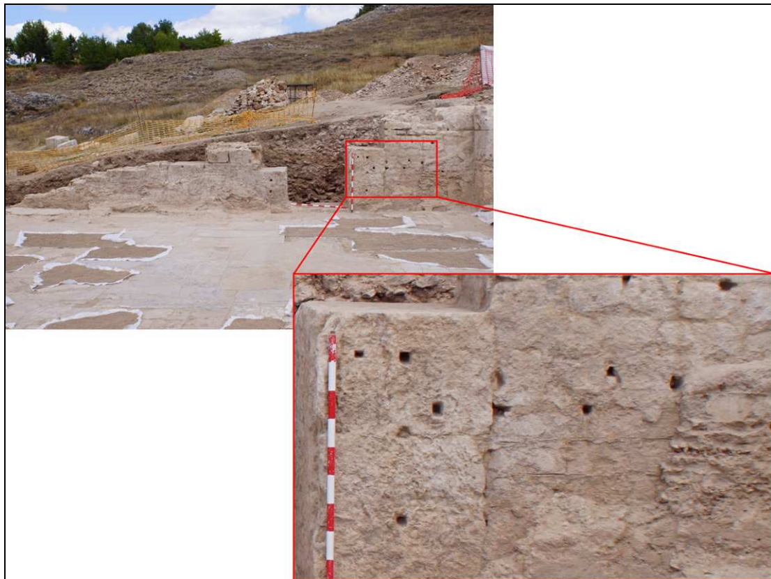
Figura 65. Vista de los restos del CF-4 (al fondo) donde se ha indicado la zona en la que se han detectado las marcas de rejuntado en los mampuestos que conforman su fábrica. En la imagen frontal se muestra un detalle del aparejo con las incisiones en las juntas tanto horizontales como verticales. Fotografías del autor.
