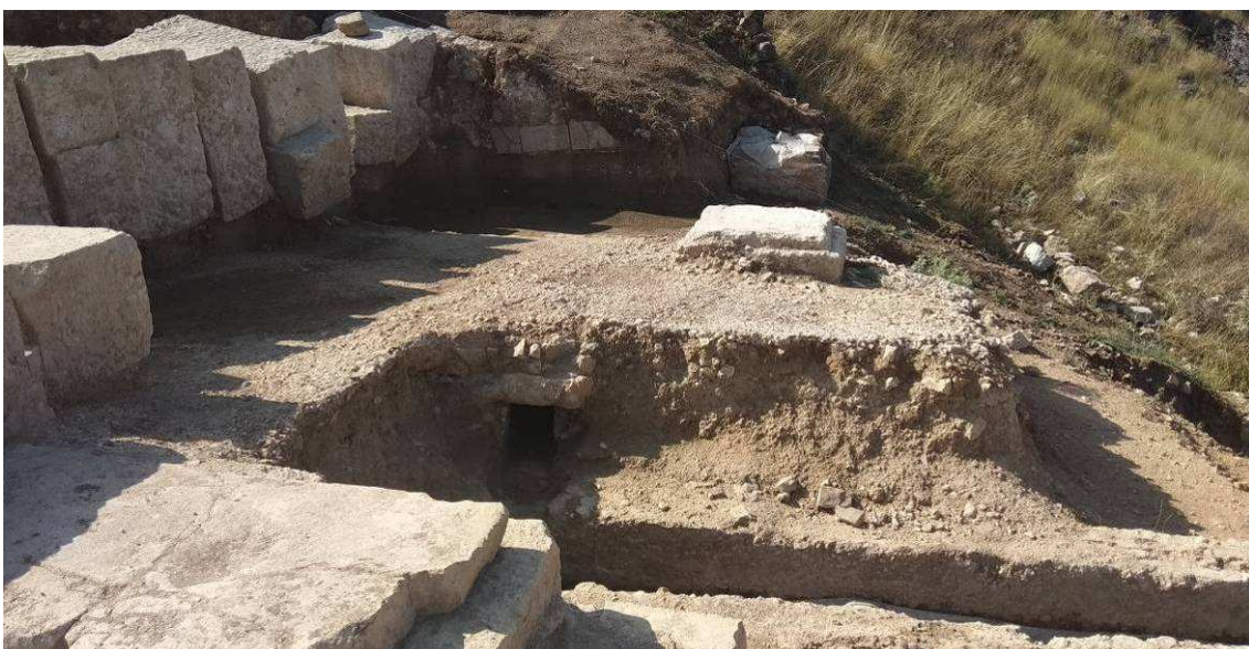
Figura 50. Perfil estratigráfico producido por la degradación del paquete de relleno del corredor septentrional donde se puede apreciar, seccionado el canal de evacuación de aguas pluviales localizado en la palestra. Fotografía del autor.
