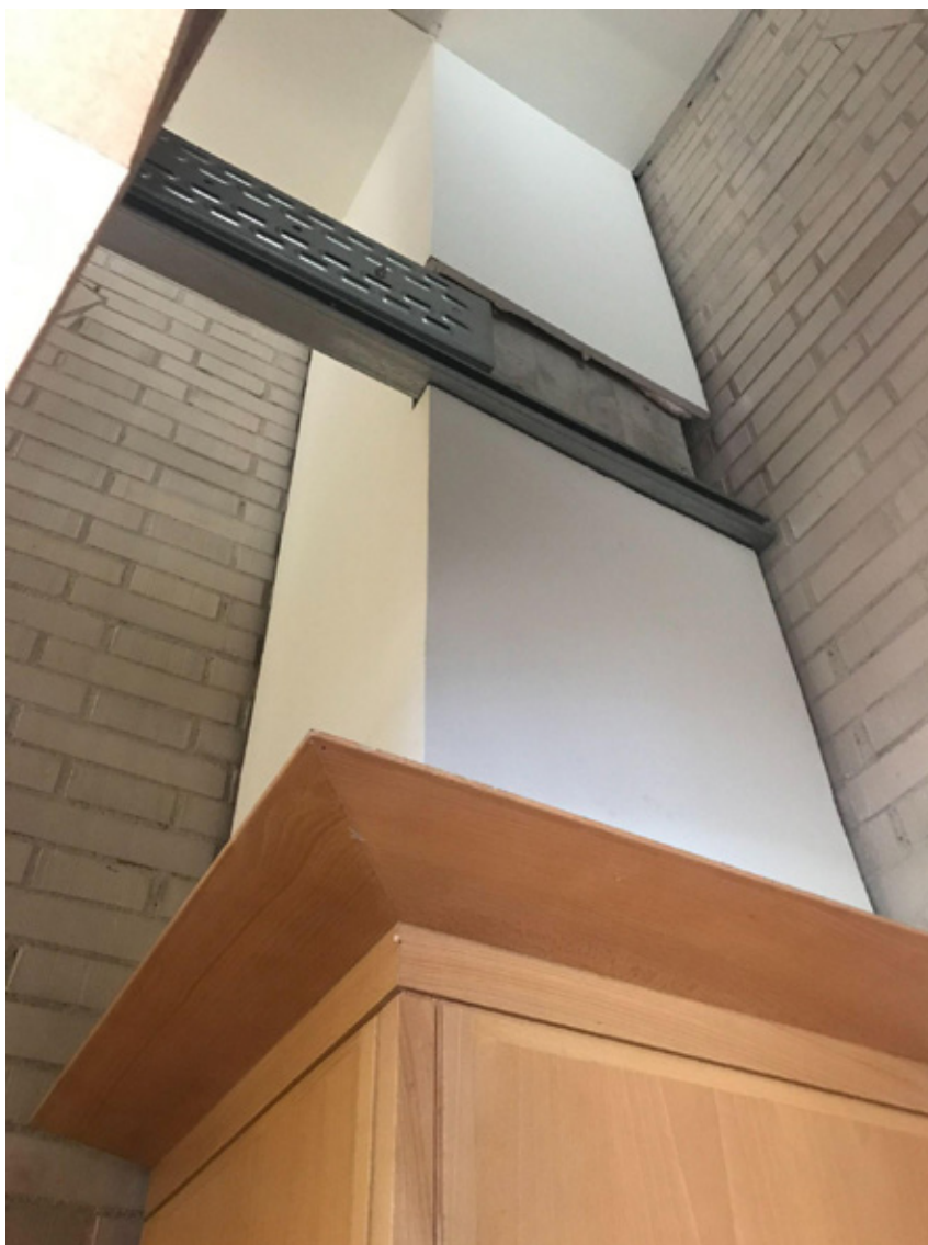
FIGURA 105. Enric Farrés Duran, Coses que passen , 2020, MACBA, Barcelona. Documentació de l'espai arquitectònic de l'arxiu: detall de les capes que formen part de l'element estructural columna.
