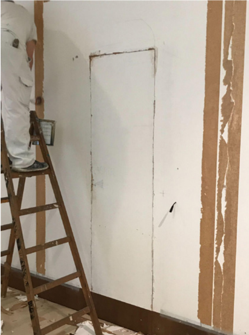
FIGURA 106. Enric Farrés Duran, Coses que passen , 2020, MACBA, Barcelona. Documentació de l'espai arquitectònic de l'arxiu: detall de la porta secreta a través de la qual s'accedeix a l'exterior del cub blanc.
