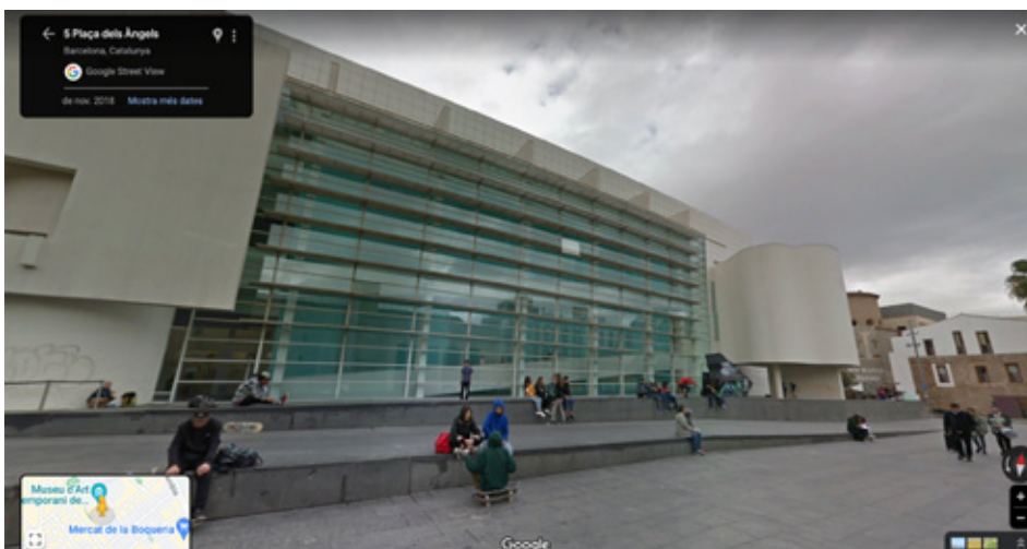
FIGURA 113. Enric Farrés Duran, Coses que passen , 2020. Captura de pantalla de Google Maps en què s'observa l'edifici Meier i el seu context.
