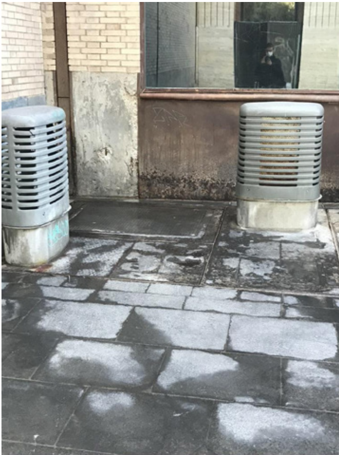
FIGURA 114. Enric Farrés Duran, detall de la descomposició de l'estructura exterior de l'arxiu a causa de la interacció amb l'orina dels usuaris. Arxiu del MACBA, Barcelona, 2021.
