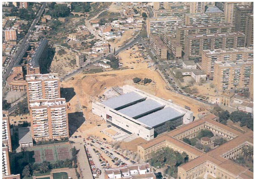
El Fòrum Nord i l'antic Hospital Mental, integrats en l'espai del futur Parc Central de Nou Barris (1995-2003)
