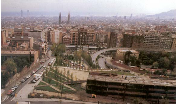
Boca sud del túnel de la Rovira (1985)
