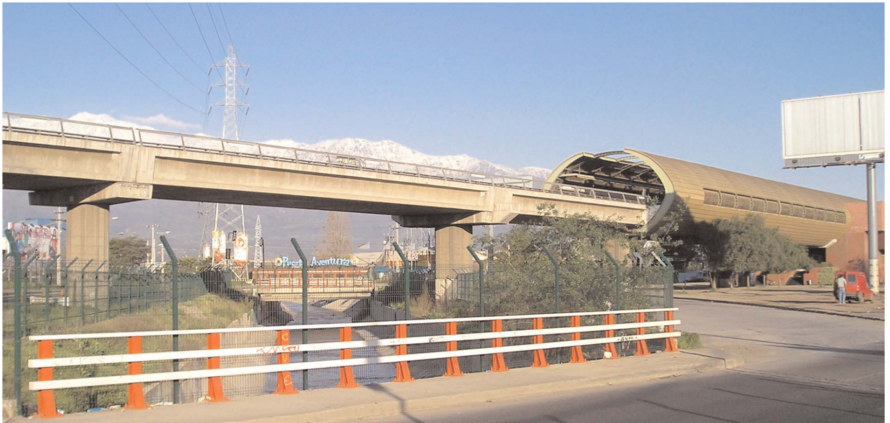
Cruce del Zanjón de la Aguada con la Avenida Vicuña Mackenna y línea 5 del Metro
