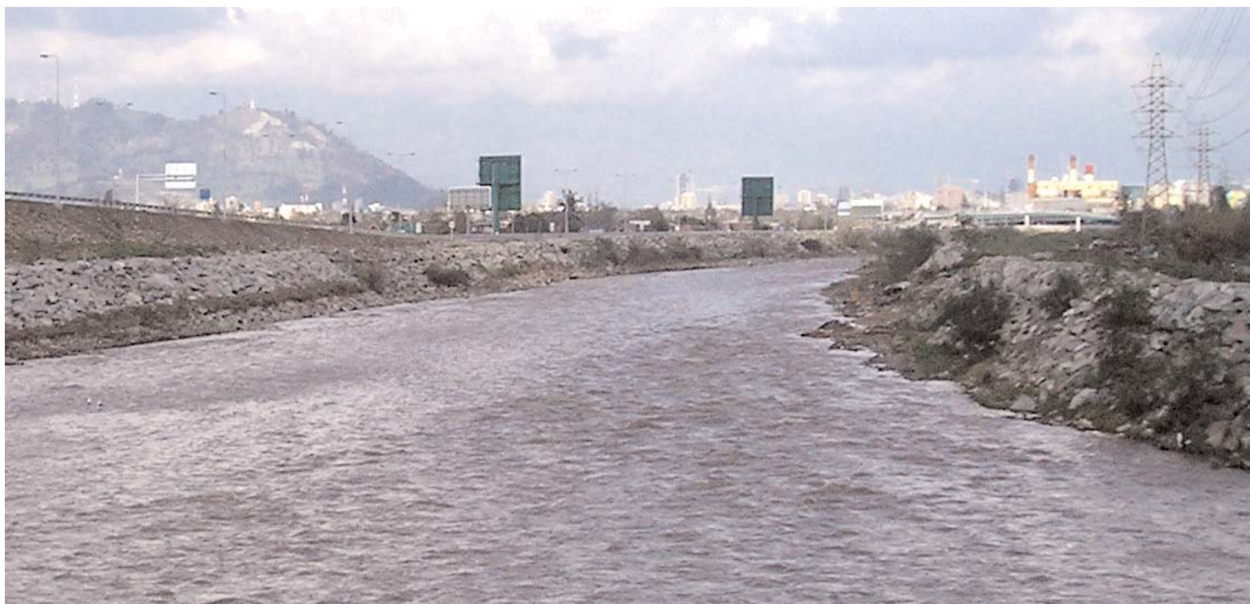
En el sector poniente de Santiago, vista hacia el oriente desde el cauce del río. Se observa la ausencia del tratamiento de sus bordes.
