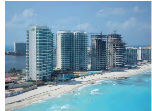
Figura 150. Residencial Porto Fino en construcción Fuente: Buscador de Arquitectura, 2009
