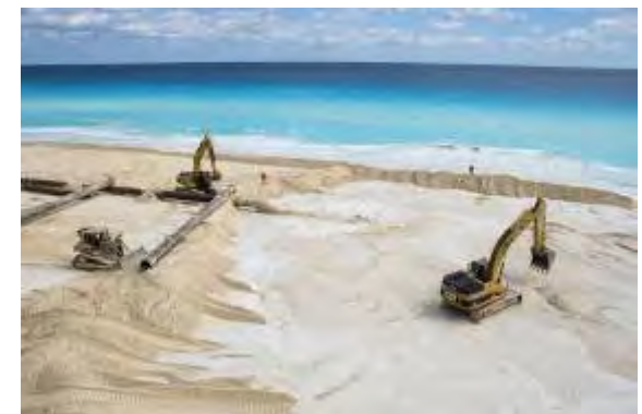
Figura 110. Trabajos de relleno en la playa frente al Royal Resorts
