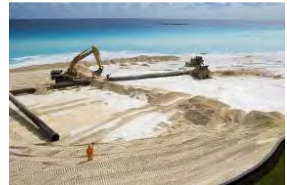
Figura 109. Trabajos de relleno en la playa frente al Royal Resorts
