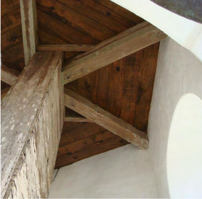
57). Estructura y cubierta de madera.
