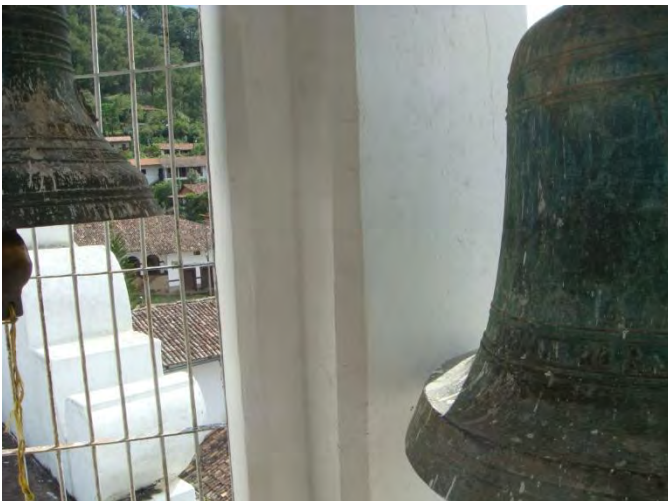
51). Grietas en los pilares.
