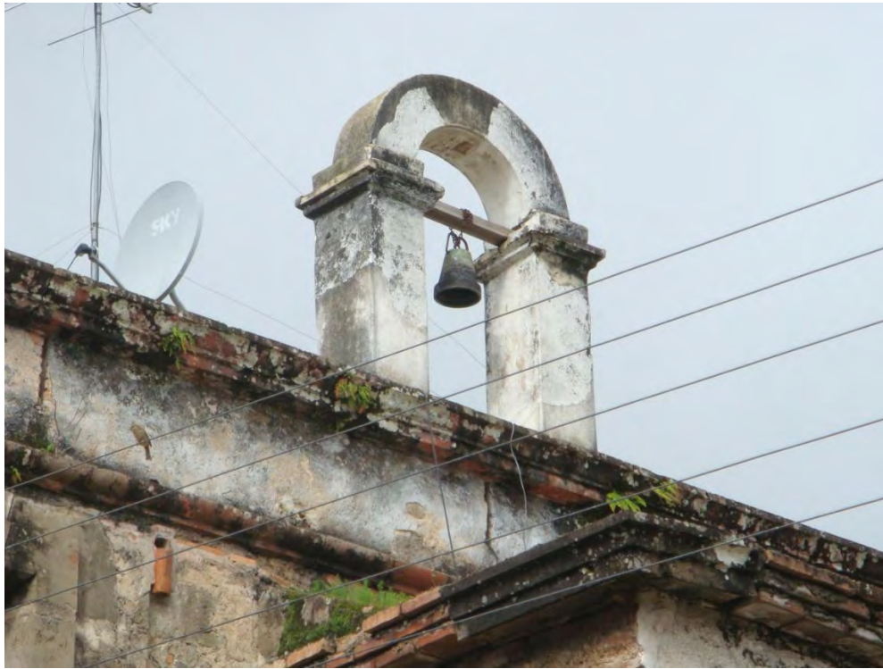
40.) Detalle de espadaña, vista norte.
