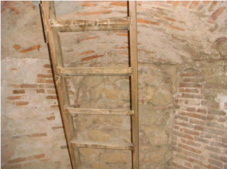
58). Obsérvese la mezcla de materiales en el cuerpo intermedio del campanario.
