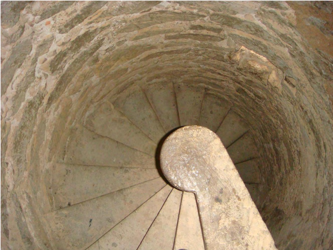
59). Vista superior de la escalera de caracol.
