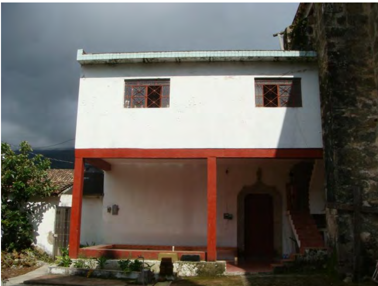
9). Vista de la sacristía y de los salones de doctrina, lado poniente.
