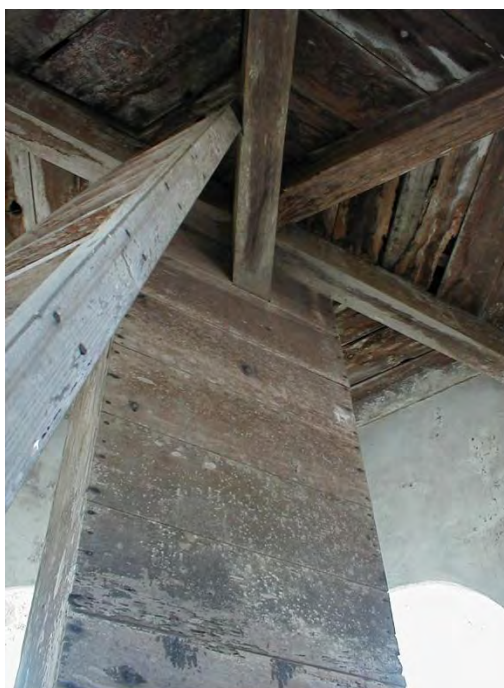
18.) Detalle de la cubierto tipo tapanco sobre el campanario.
