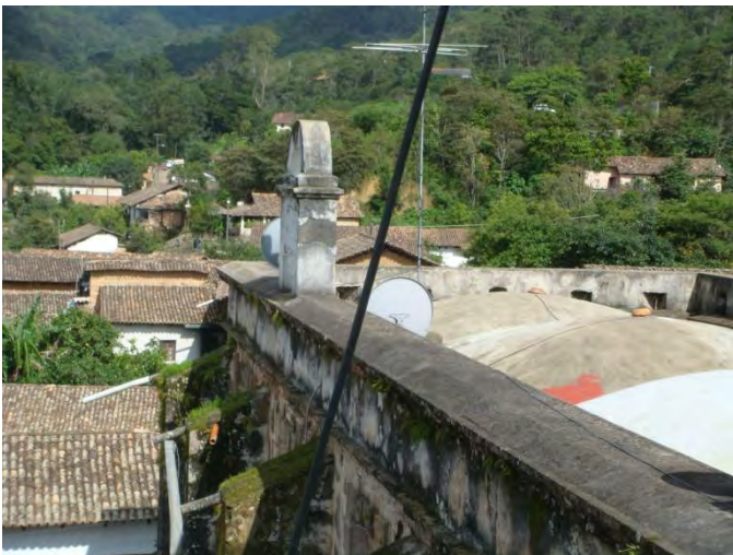
43). Detalle de azoteas y pretil del muro norte.
