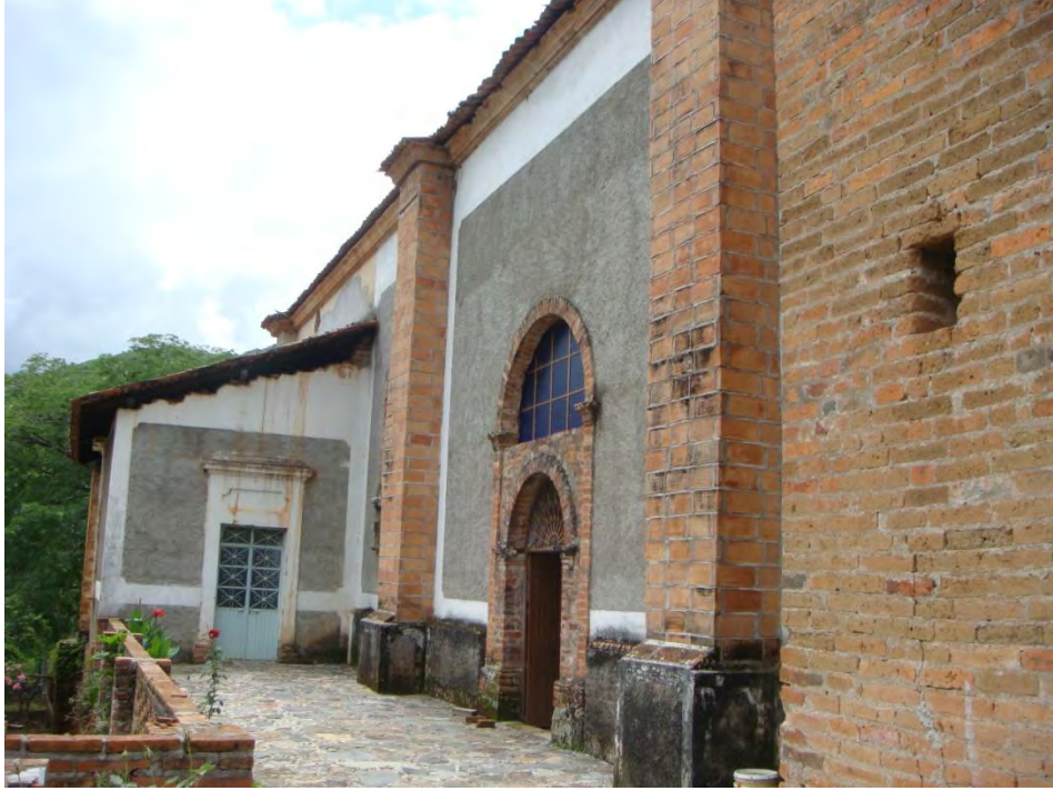
26.) Detalle de arco de medio punto del muro norte.
