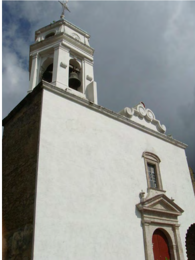
12.) Vista frontal del lado oeste.
