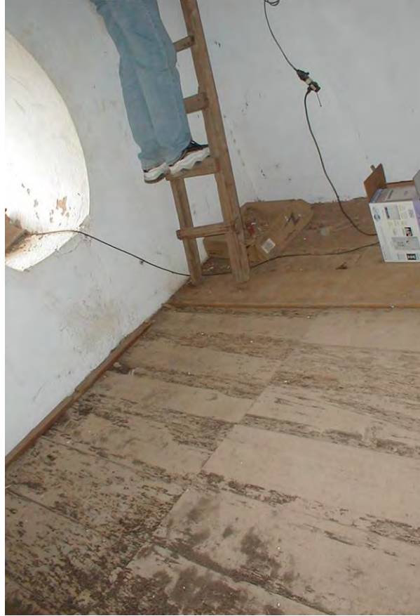
34.) Detalle del tapanco del coro por la parte superior y la escalera que sube a la cumbre.
