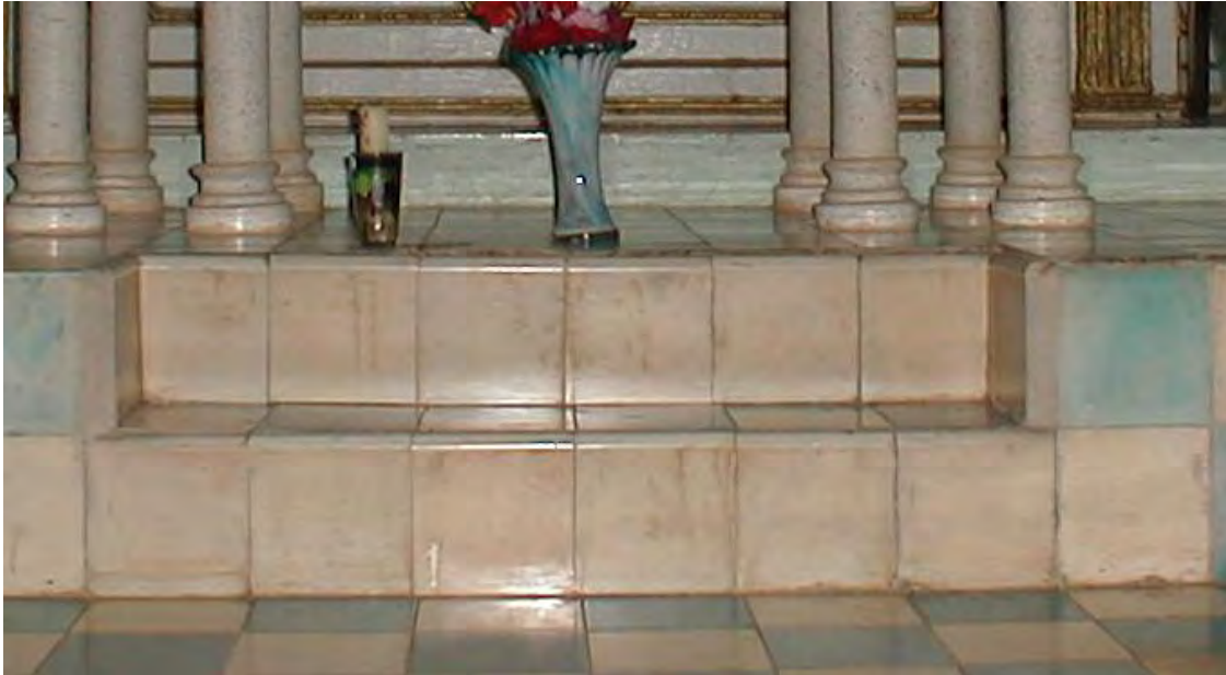
36.) Escalera del altar cubierta con mosaico, el piso original era de madera.
