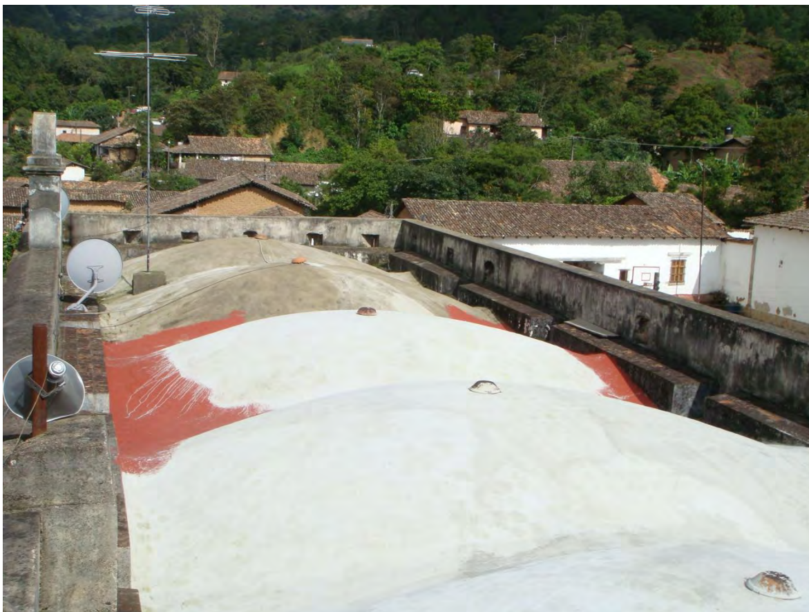
16.) Detalle de la cubierta por la parte exterior.
