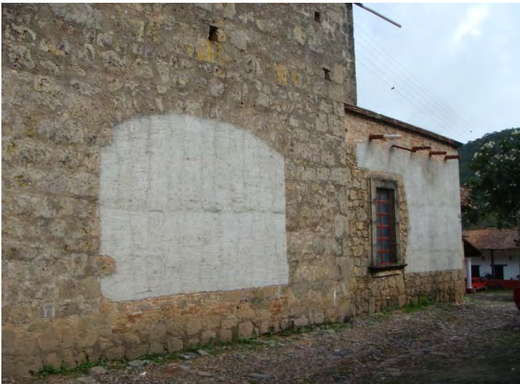
24). Detalle de unión entre el testero y la sacristía. Obsérvese el cambio de sistema constructivo de piedra a ladrillo.
