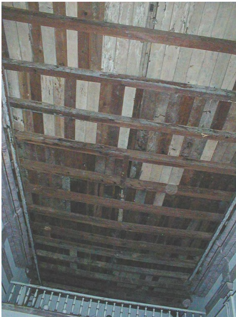
14.) Vista hacia el coro de la parte superior de la cubierta.
