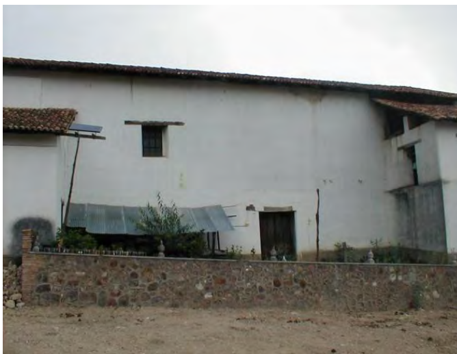
22.) Detalle del muro lateral oriente.
