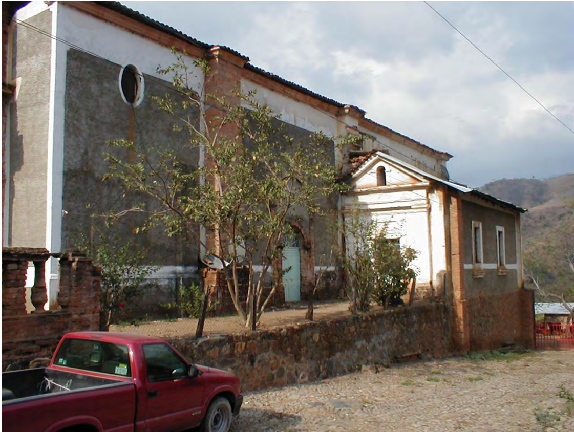
6.) Vista del Muro Sur.
