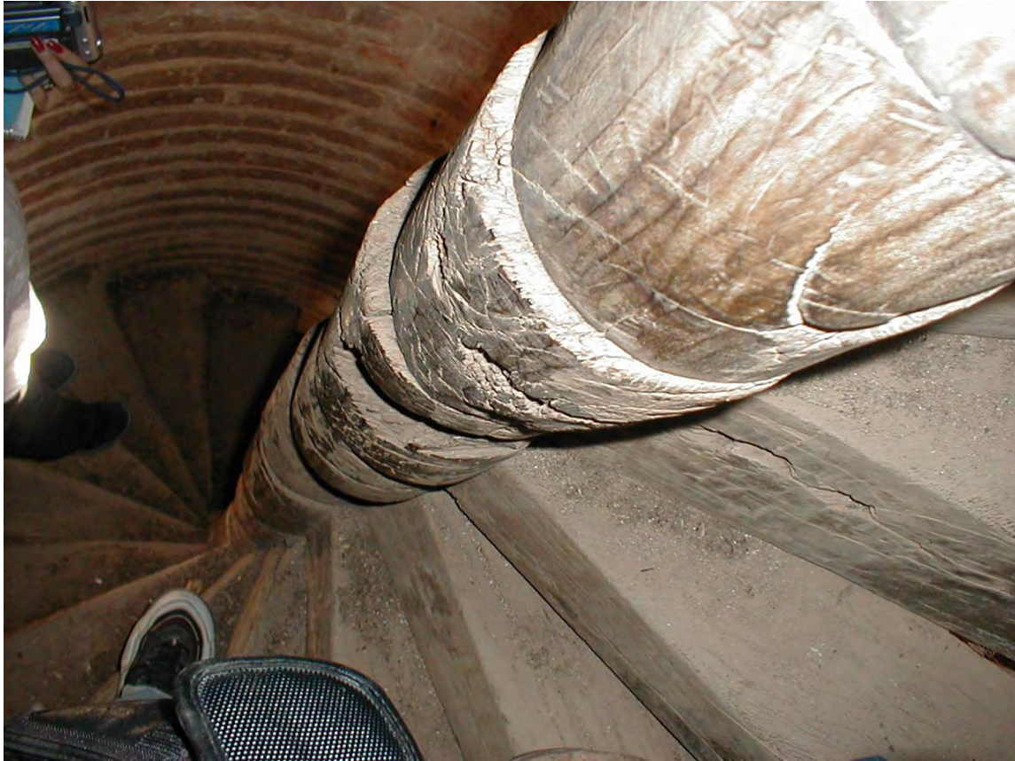
32.) Detalle de escalera con el sistema de machihembrado en piezas individuales.
