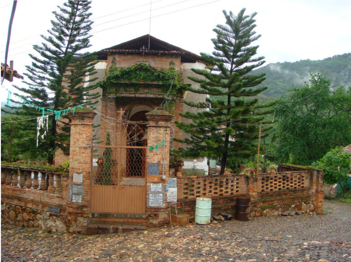
23.) Vista del ingreso principal (nótese el tamaño de las araucarias y la eflorescencia del frontón), Registro de julio 2008.
