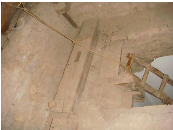
27.) Vista del terrado previo a la cubierta.
