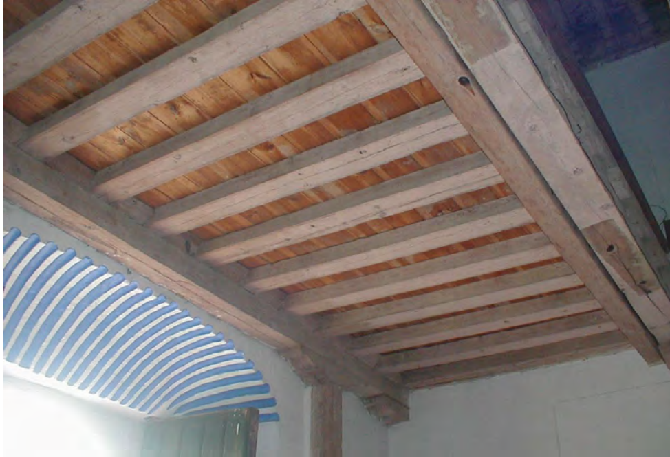
26.) Detalle del tapanco o coro de la iglesia por la parte inferior, ubicado en la zona de ingreso principal.
