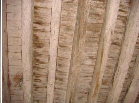
11.) Vista por la parte inferior.
