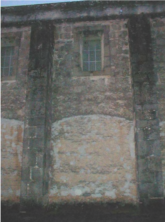
7.) Detalle del muro norte.
