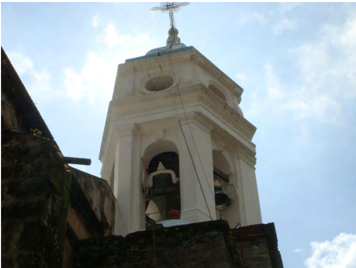
49). Detalles del engrosamiento de los pilares.
