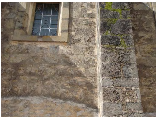
31). Detalle de las juntas del contrafuerte del muro sur.
