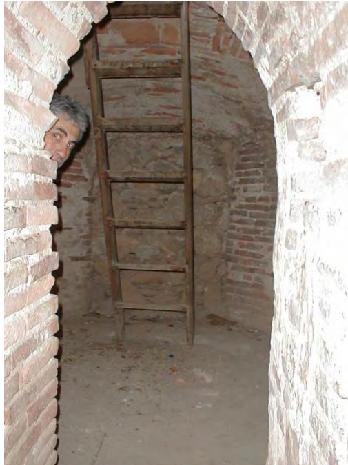
31.) Escalera previa al campanario, arco parabólico y bóveda mixta de piedra y ladrillo.
