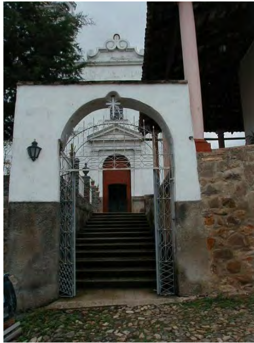
28.) Detalle del ingreso por el lado Poniente, nótese el desnivel.
