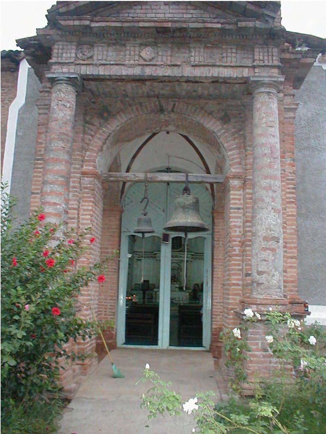
30.) Ingreso principal (registro del 2001). Arcos de medio punto, hechos en ladrillo (Aún no tenía tanta maleza el frontón).
