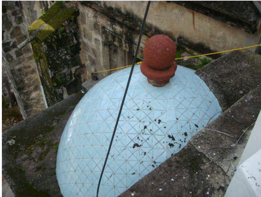
19.) Cupulín que remata la escalera de caracol. Nótese las intersecciones entre los diferentes cuerpos.
