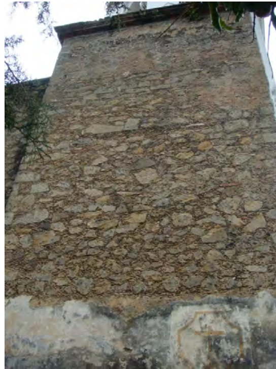
8.) Detalle del campanario lado norte.
