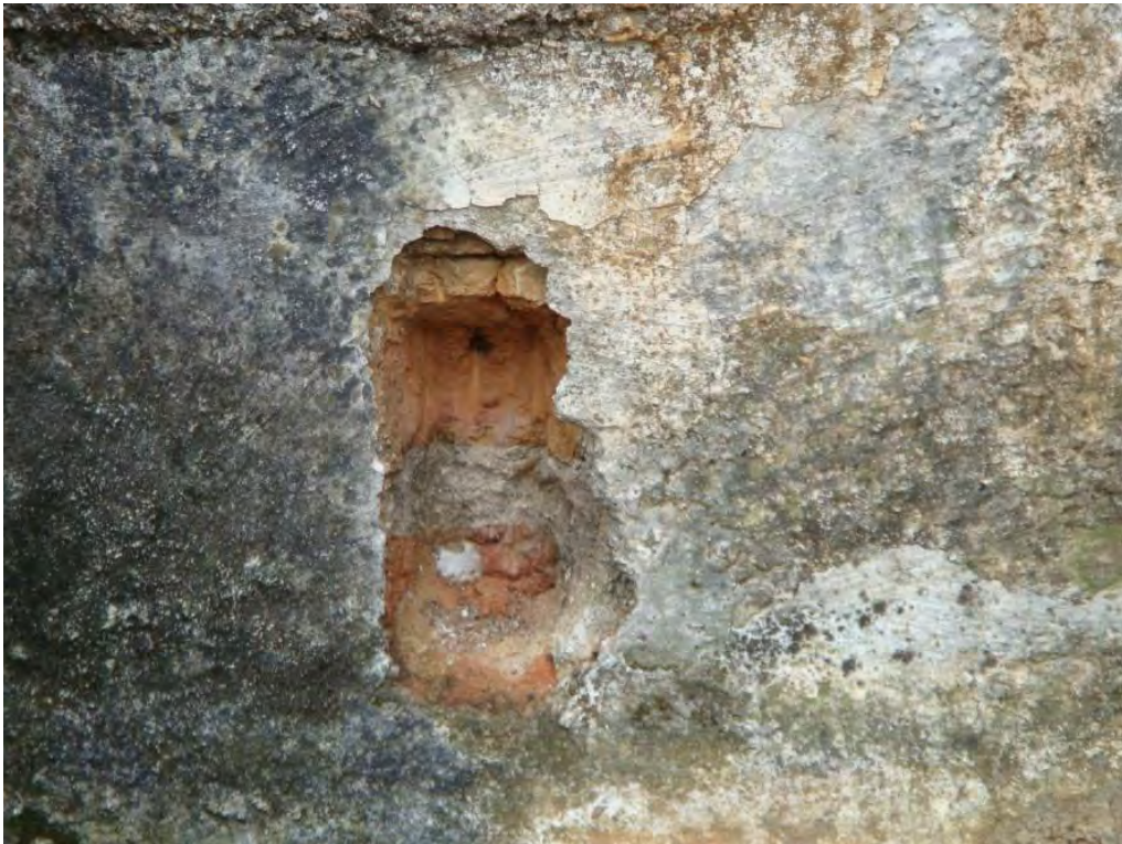
12.) Detalle del muro sur, donde se puede apreciar el ladrillo bajo el zarpeado.
