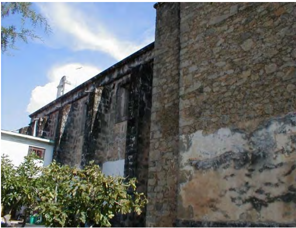
19). Reparaciones en el muro del campanario.
