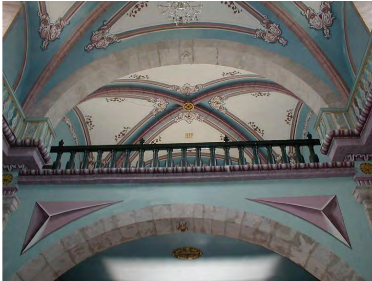
34.) Detalle de la vista hacia el coro desde la nave, donde apreciamos no solo los arcos y la bóveda superior sino también el entrepiso.
