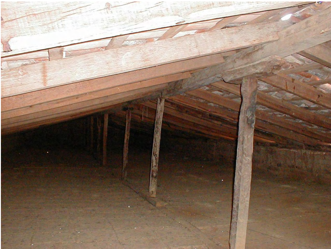
13.) Vista por la parte inferior.
