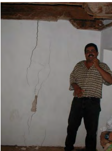
Vista interior del muro poniente en el tapanco.
