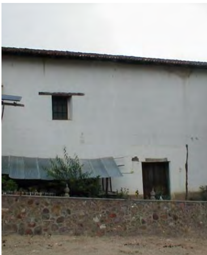
18.) Estado actual de los dinteles del muro oriente en Santa María
