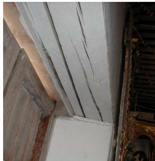
18.) Estado actual de los dinteles del muro oriente en Santa María
