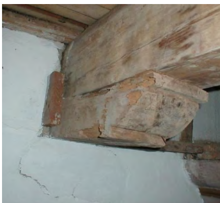
57.) Detalle de ménsulas en Los Reyes.
