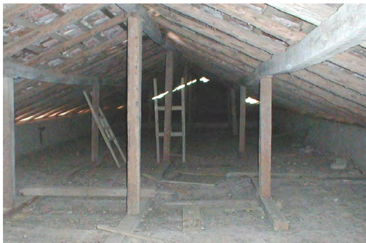
31.) Vista de la cubierta de tijera en Santa María.
