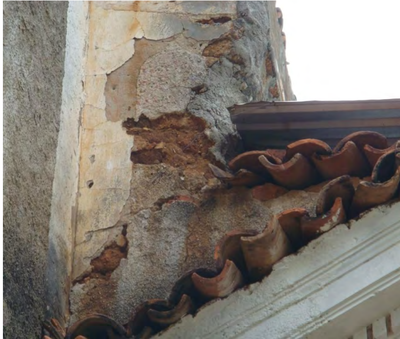
58.) Detalle de unión de cubierta y muro.
