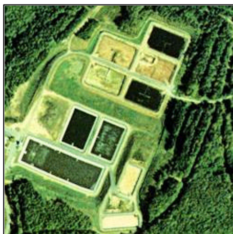
Figura 147. Estació depuradora d'aigües residuals al municipi de Falmouth, Cape Cod.
