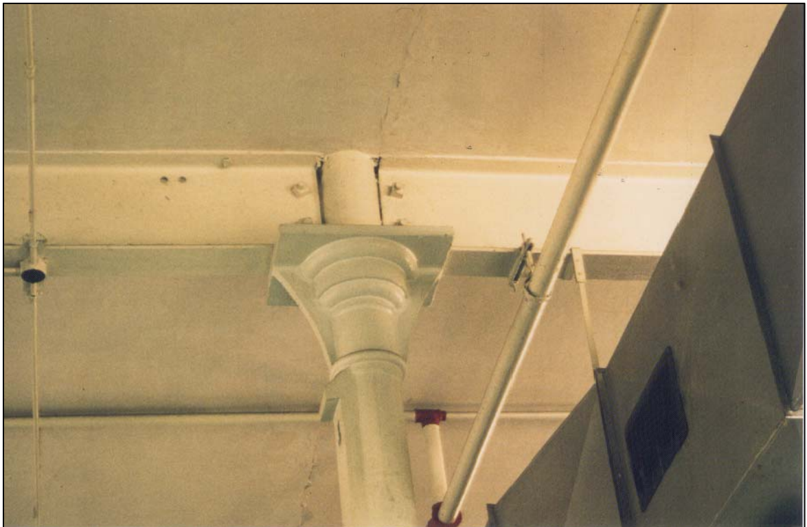
Figura 31 Capitell singular. Malgrat el seu disseny singular, té 2 carteles i un relleu per a fixar els embarrats. També es pot apreciar la prolongació superior del tub. Colònia Borgonyà, edifici A (Sant Vicenç de Torello. 1892)
