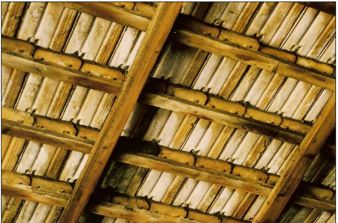
Figura 2 Coberta de teula plana col.locada a salt de garça. Colònia Palà (Navàs).
