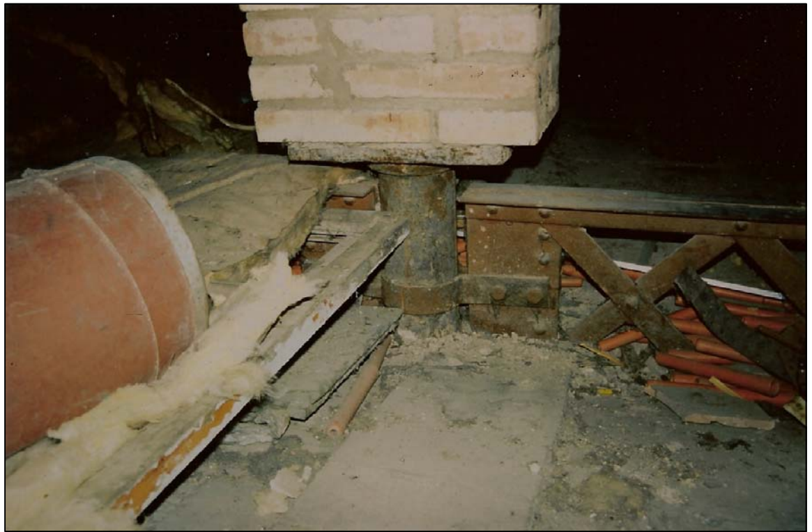
Figura 36 Unió d'una columna de ferro colat, un pilar de maó i dues jàsseres de gelosia. Cal Manen o Cal Riera (Puig-Reig. 1903–1905)
