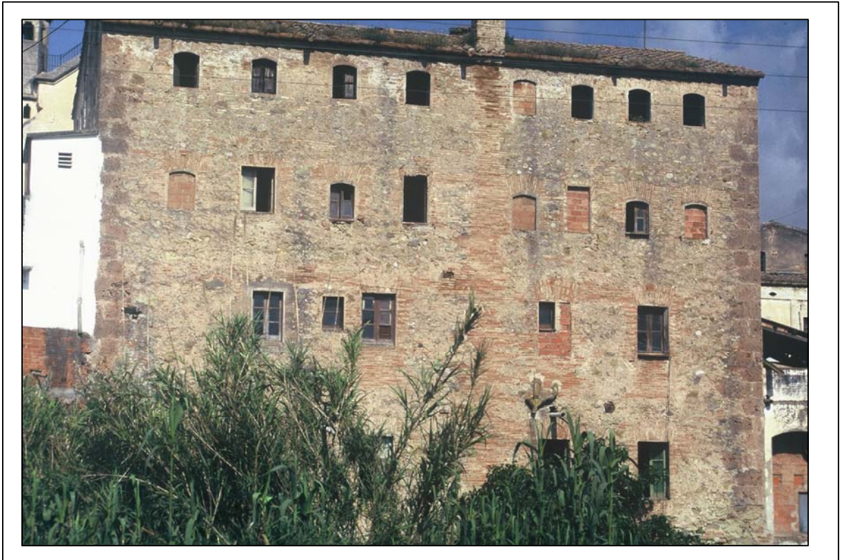
Figura 5 Molí de Can Bros (Martorell). Aquest edifici, malgrat que pot haver tingut diferents creixements, mostra una estructura de murs amb poques i petites obertures.
