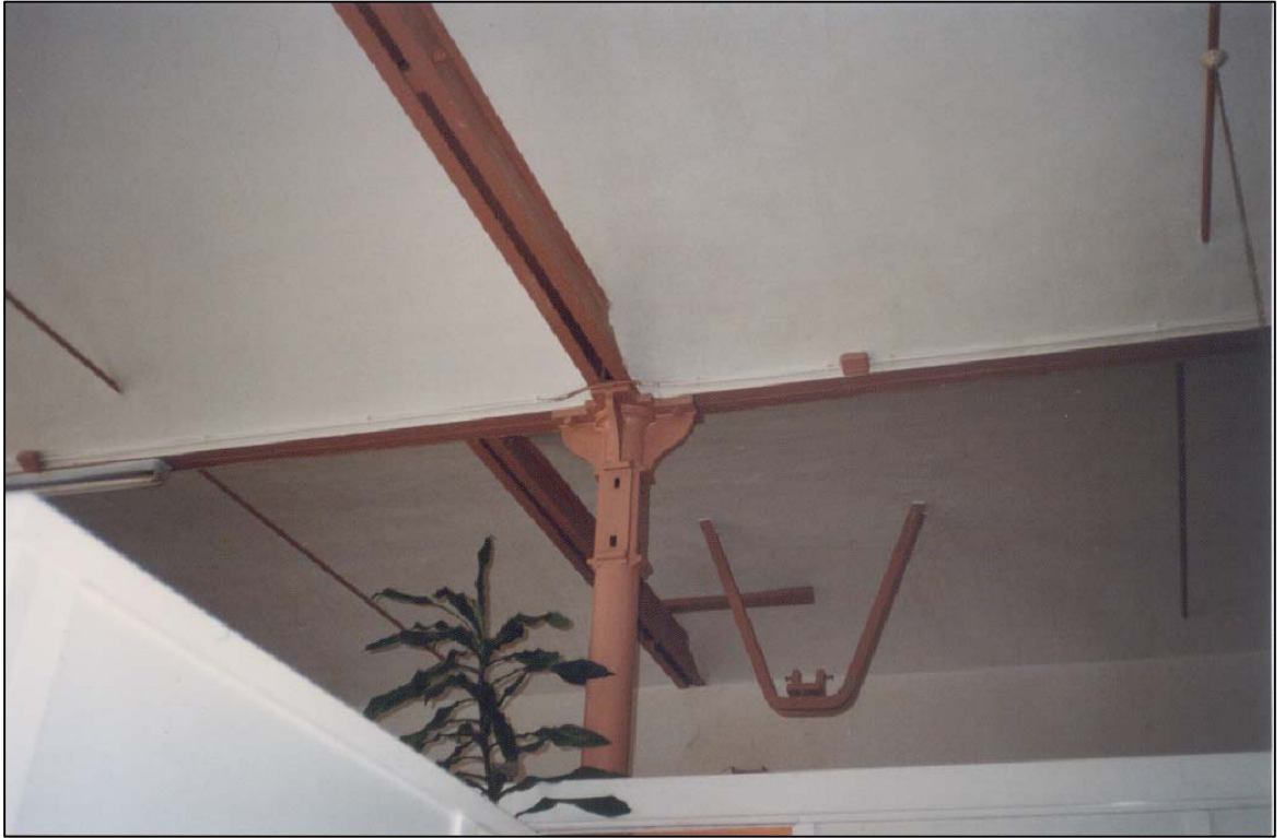
Figura 30 Columna de ferro colat amb capitell tipus C.2. Vapor Ros (Terrassa. Principis s. XX)
