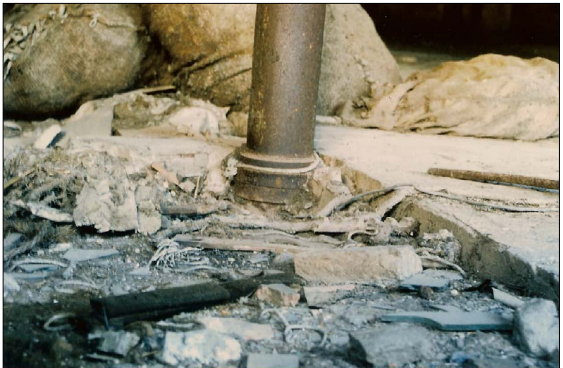
Figura 37 Base d'una columna de ferro colat. Colònia Palà (Navàs. Riu Cardener. Anterior a 1877)
