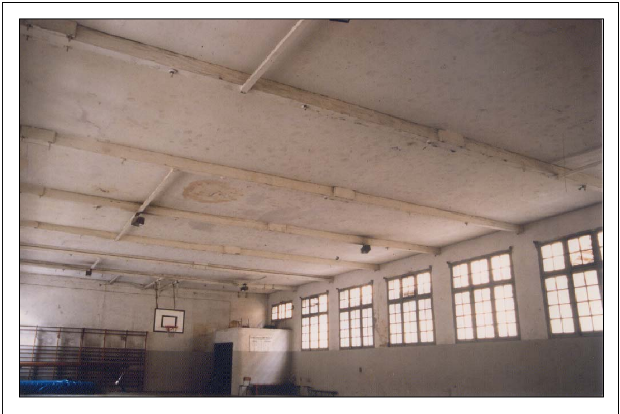
Figura 37 Cal Sampere (Sabadell. 1912) (A la part inferior de les encavallades s'ha construït un fals sostre d'encanyissat i guix)
