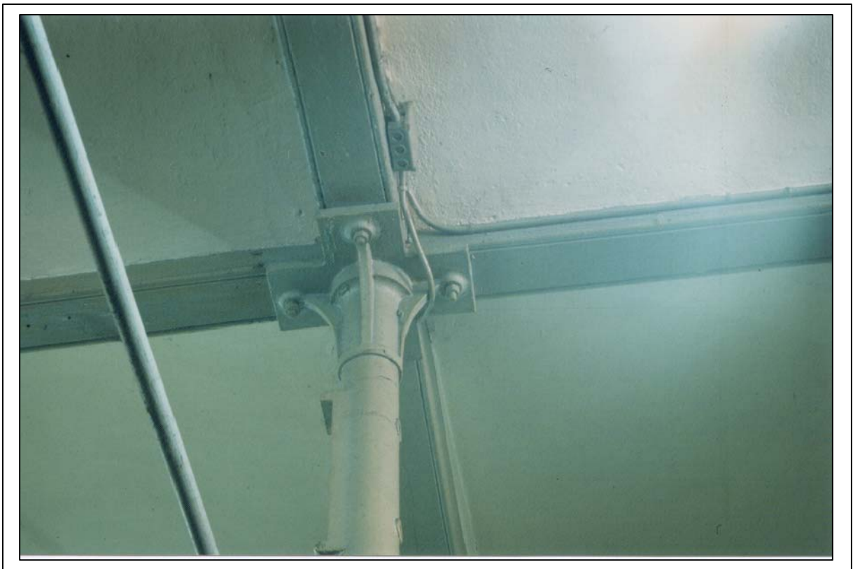
Figura 29 Columna de ferro colat amb capitell tipus C.1. Fàbrica Pont, Aurell, Armengol (Terrassa. 1876)
