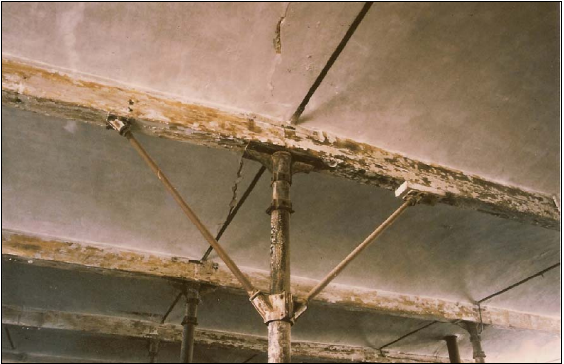
Figura 44 Intervencions en l'estructura. Reforç de les jàsseres de fusta amb tornapuntes. Fàbrica del Guix (Manresa)
