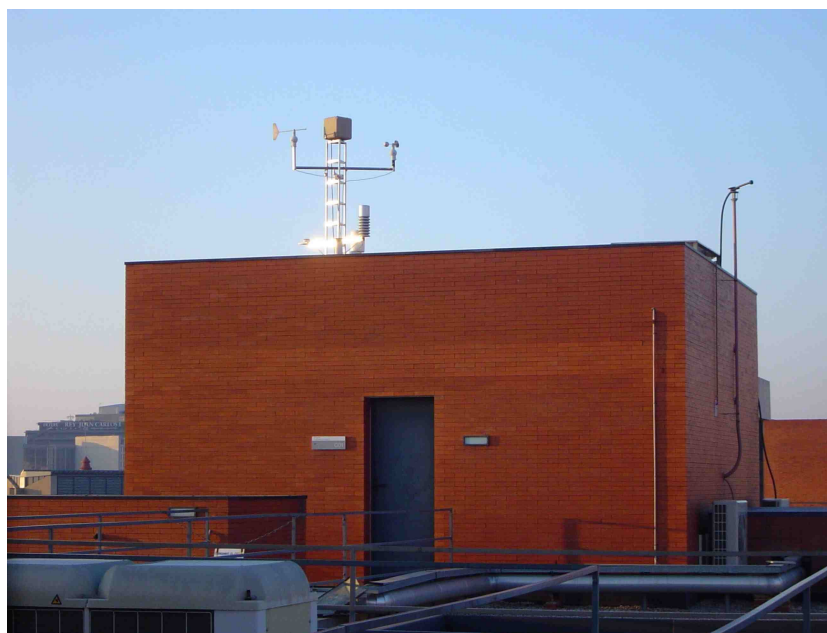
Figura 33: Fachada principal de la caseta de la estación radiometeorológica del Campus Nord
