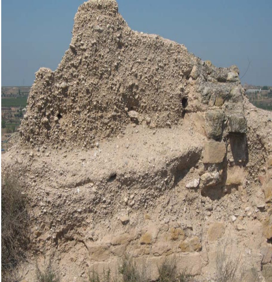
5 Detall del mur nord amb base de pedra i tapial en alçat
