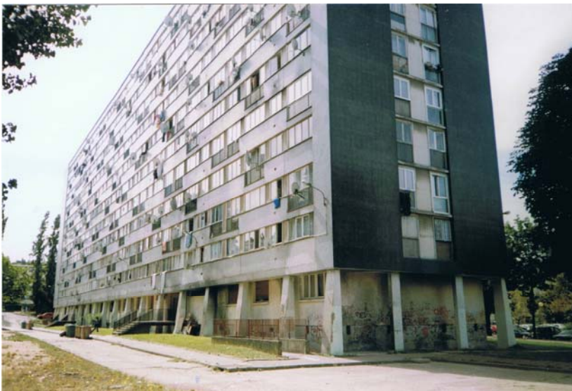
FIGURA 11.2.11. Edifici d'habitatges a Clichy-sous-Bois (Bas-Clichy)
