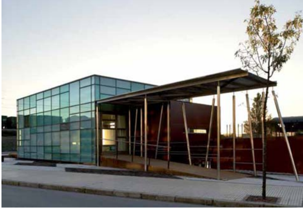
FIGURA 11.1.3. Edifici del Punt Net de La Calzada
