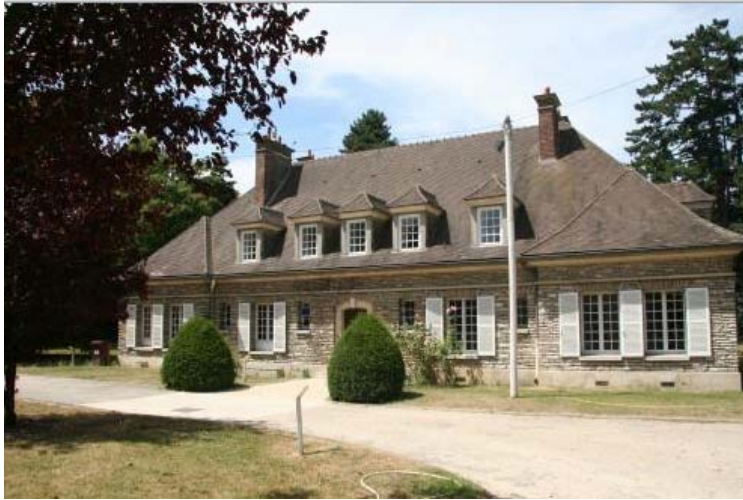
FIGURA 11.2.17. Mansió Formigé , pol sociocultural a Montfermeil
