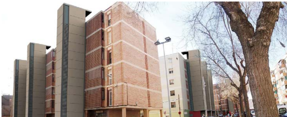
FIGURA 11.1.11. Instal·lació d'ascensors als edificis de la Mina Vella
