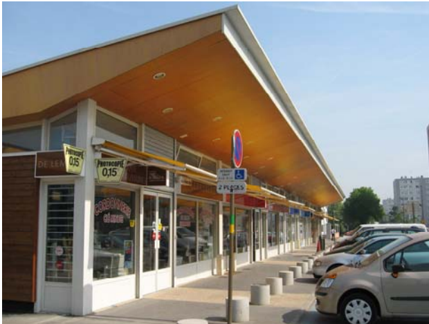
FIGURA 11.2.28. Centre comercial de Coteaux de l'Orge
