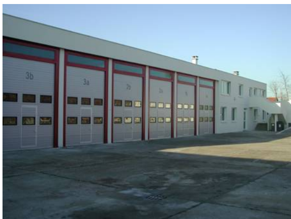
FIGURA 11.2.25. Noves instal·lacions per usos industrials – Viry-Chatillon
