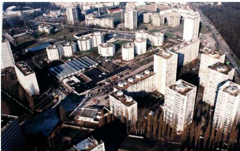
FIGURA 11.2.8. Imatge aèria de "Les Bosquets" - Montfermeil
