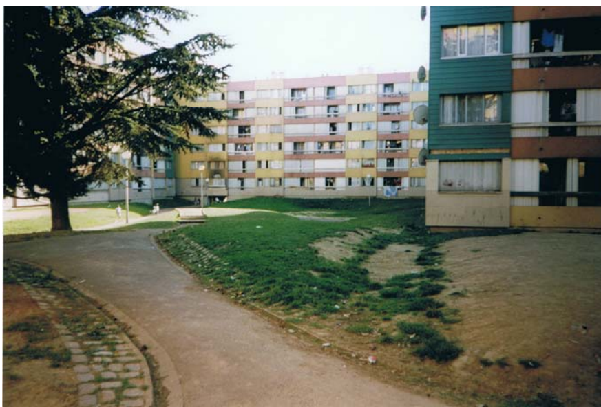
FIGURA 11.2.3. Interior d'illa als barris del nord d'Aulnay-sous-Bois
