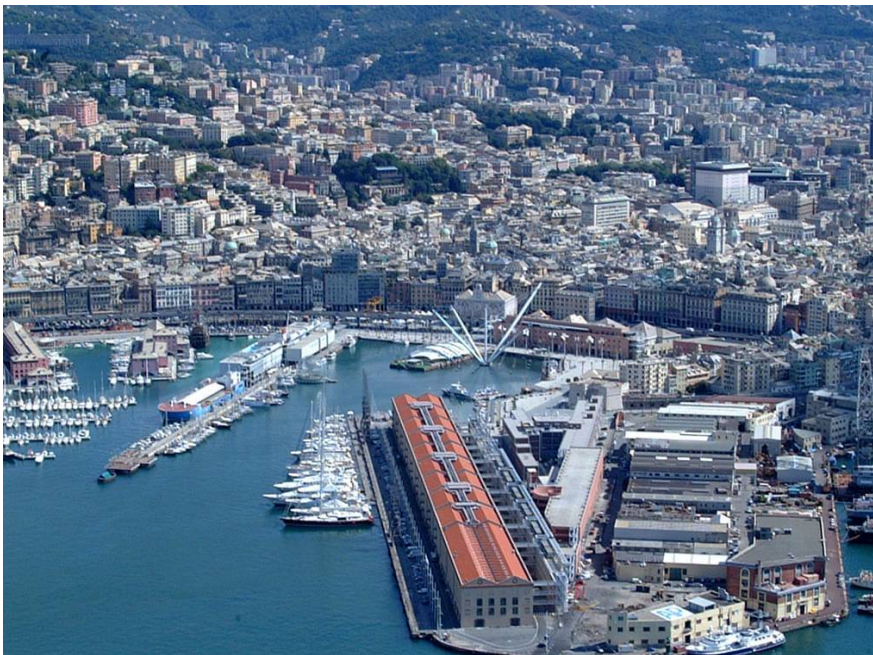
FIGURA 11.3.9. Imatge aèria del port antic, renovat per l'exposició del 1992
