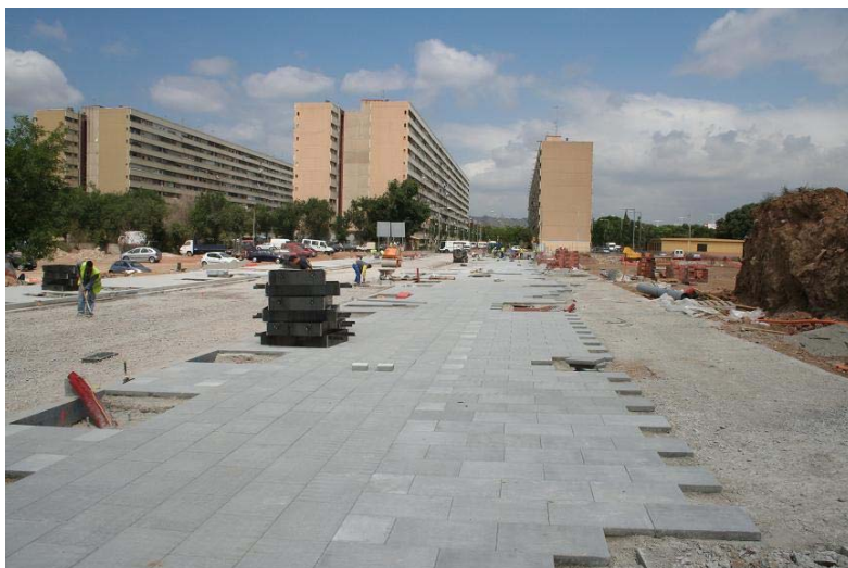
FIGURA 11.1.9. Transformació urbanística de la Mina – carrer Llevant
