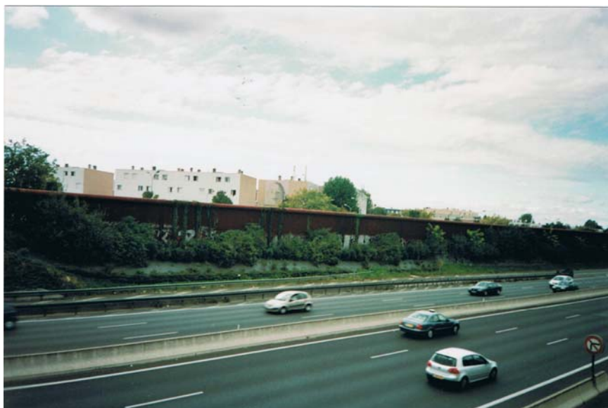
FIGURA 11.2.21. Autovia A6 al seu pas pel terme de Grigny, separant el centre urbà de La Grande Borne (al fons de la imatge)
