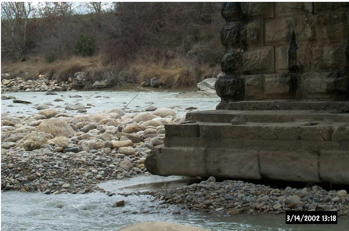
**Figura 5.13.- Detalle de descalzamiento del pilar del puente ubicado junto a la sección L5. Dicho puente separa los tramos de Lagüarres y Capella.**
