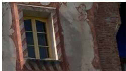
75-17: Detalle de ventana y encuentro paramento con revoco con obra vista en fachada posterior. Se aprecian las bandas transversales en los puntos en que el esgrafiado aparece, de igual manera como si se levantara en rollo la capa de revoco. Fotografía: Guillem Carabí, agosto de 2010.
