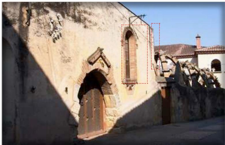
**73-09:** Edificio de la prensa de aceite, a continuación de los lavaderos. En rojo se señala una ampliación posterior de la ventana, y el muro, ajenas al proyecto de Jujol. Fotografía: Guillem Carabí, agosto de 2010.
