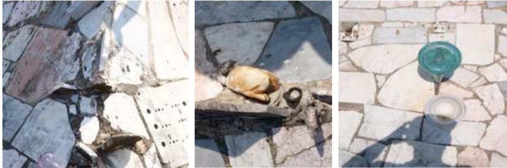
78-04: Diversos detalles de la superficie de la cubierta piramidal. Se pueden apreciar los restos de vajilla, tinajas, el gato y otros objetos, incrustados entre las piezas fragmentadas de mármol a modo de *trencadís*. Fotografías: Guillem Carabí, marzo de 2007.
