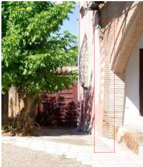
75-16: Detalle de la fachada posterior donde se señala la línea de unión entre distintas superficies de la fachada posterior, identificada por bandas transversales intercaladas. Fotografía: Guillem Carabí, agosto de 2010.
