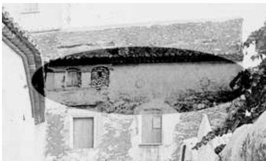
**73-06:** Detalle del área correspondiente a la planta desván. Se aprecia la reforma de las ventanas en construcción que aumentan el perímetro de su abertura, y dos discos estrellados llenando el espacio vacío de la derecha. Actualmente, los discos han desaparecido.
