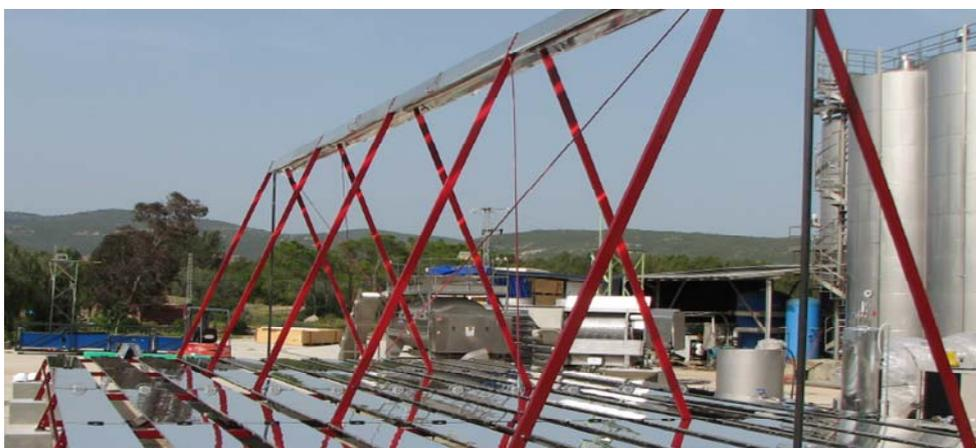
**Figura 2-15. Captador lineal Fresnel LF-11 de Industrial Solar GmbH [87].**
