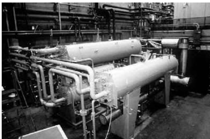
**Figura 3-10. Prototipo de enfriadora de triple efecto de 390 kW del tipo *Dual Loop Cycle* de la empresa Trane [169].**
