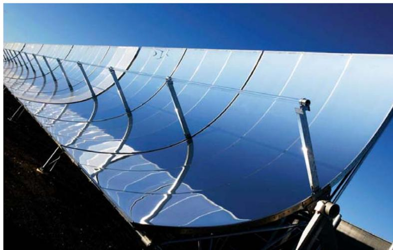
**Figura 2-10. Captadores cilindro-parab3licos para la producci3n de electricidad [58].**
