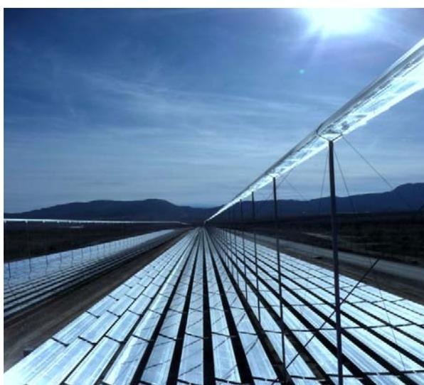
**Figura 2-12. Captadores lineales Fresnel en una planta solar termoeléctrica [80].**
