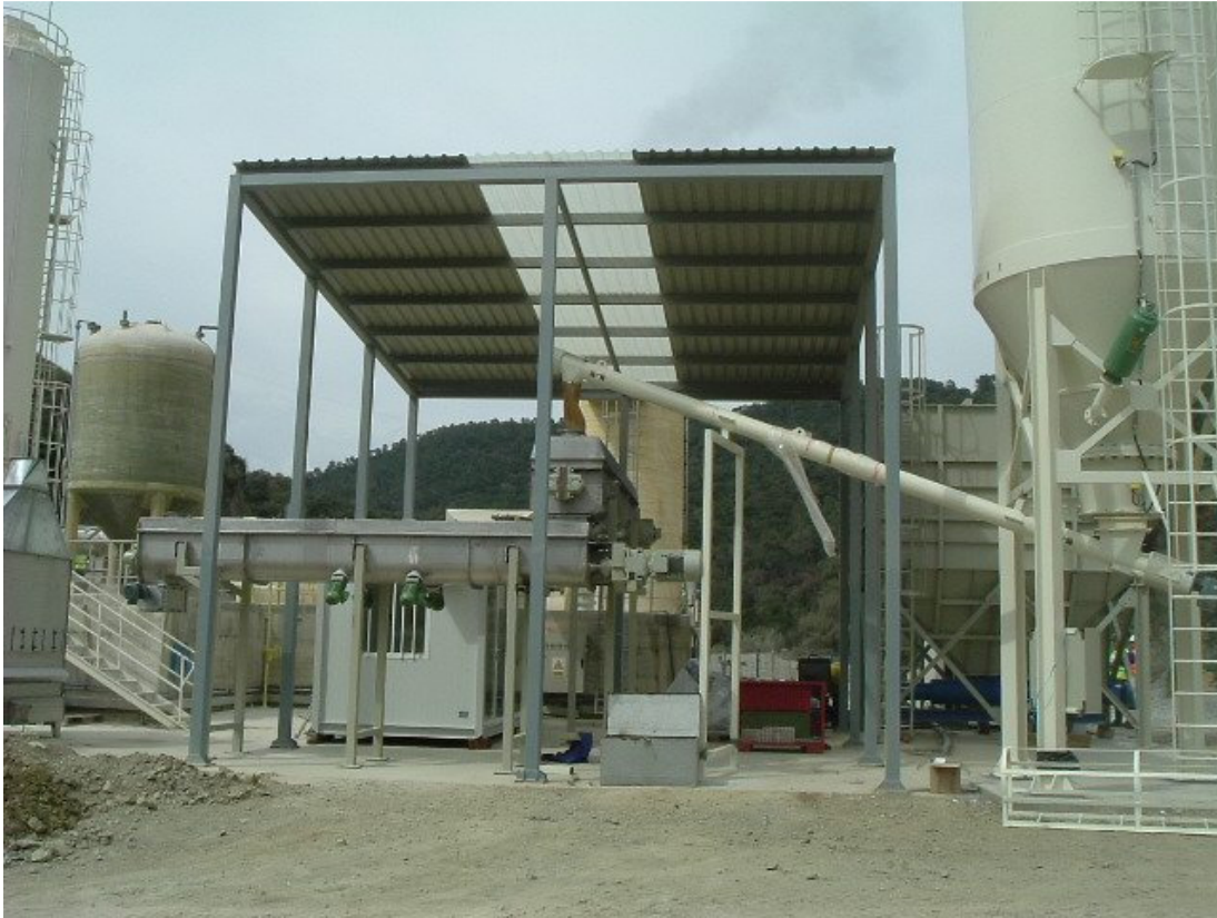
Fase de construcción de la planta. A la derecha se aprecia el silo de cal y detrás la unidad mezcladora
