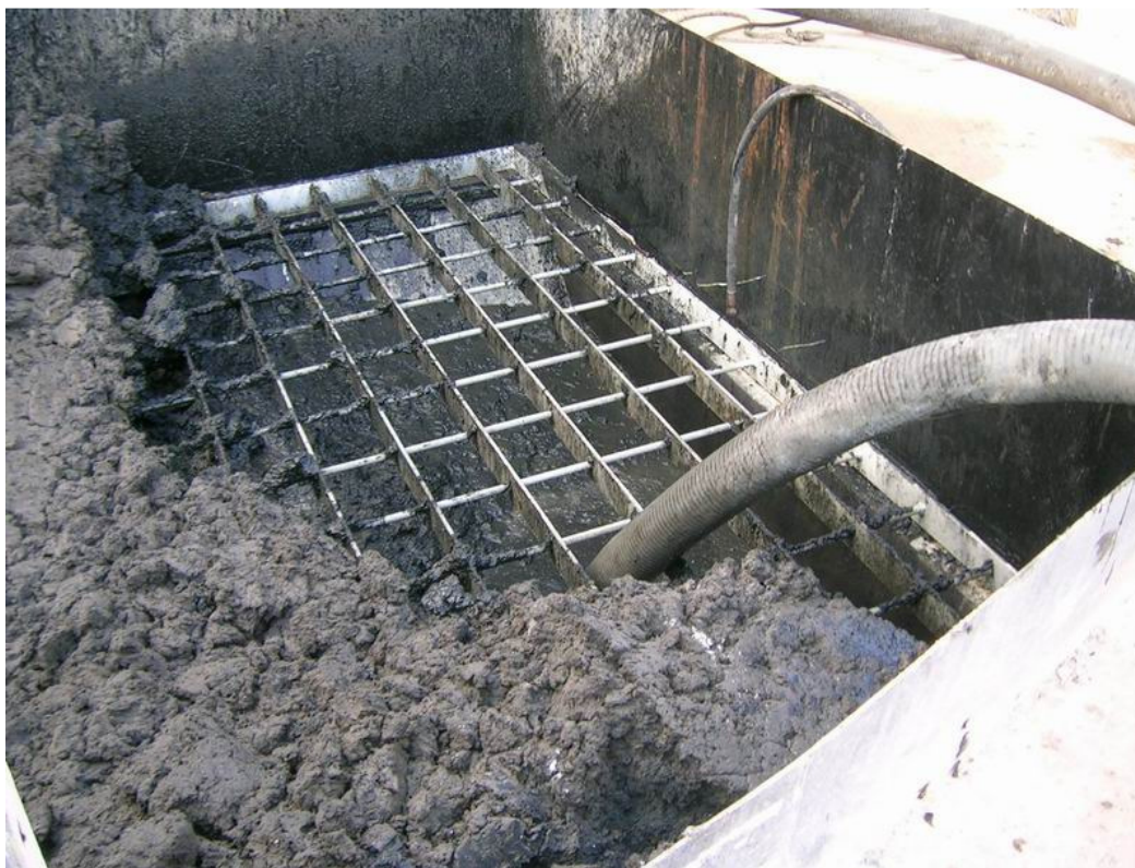
Fase de pruebas inicial . Bombeo de los lodos con agua añadida a la tolva desde cuba.
