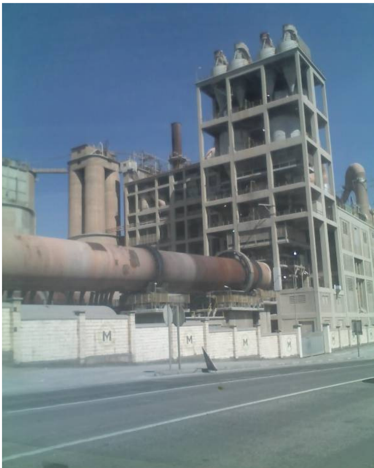
Horno nº 4 en la fábrica de St. Vicenç del Horts de Ciments Molins en la que se hicieron las pruebas industriales (al lado de Carretera N-340)
