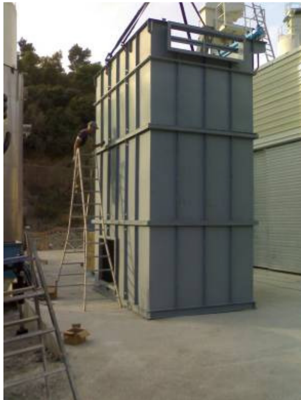
Instalación del filtro de mangas (imagen octubre 2008)
