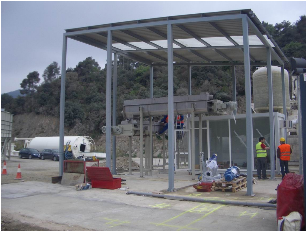
Fase de construcción de la planta. Se aprecia la estructura, reactores, cabina de control y acopio de material
