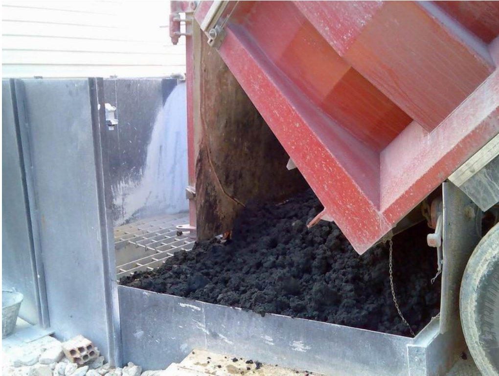
Fase de pruebas. Vertido de los lodos en el foso de recepción
