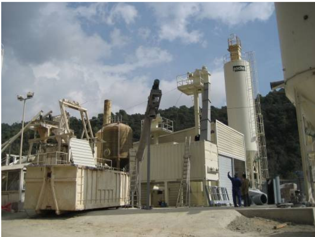
Aspecto Planta tras reformas 2008 (imagen octubre 2008)
