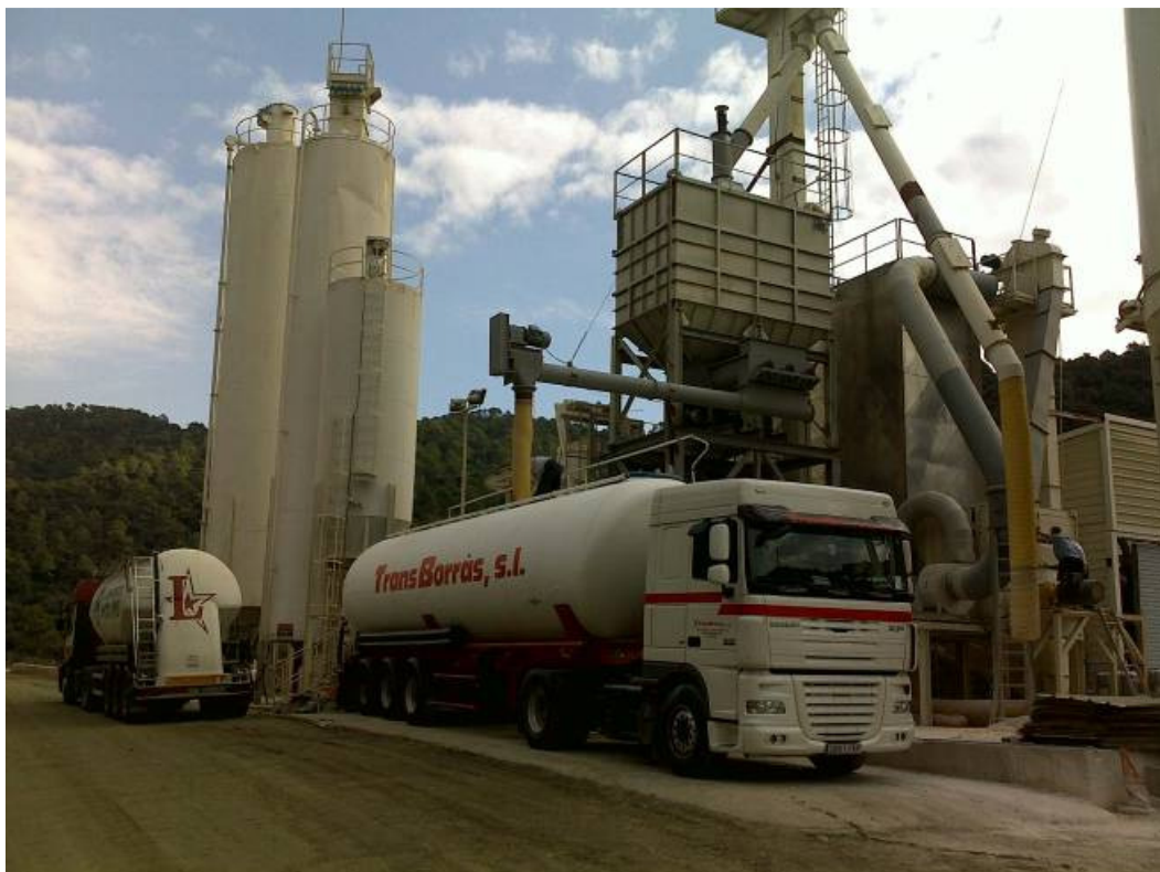
Descarga de silo a cuba durante prueba industrial
