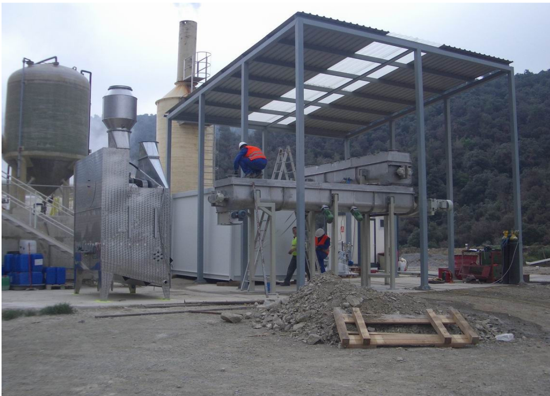
Planta de tratamiento en construcción. Pueden apreciarse los reactores y el filtro de partículas en su emplazamiento
