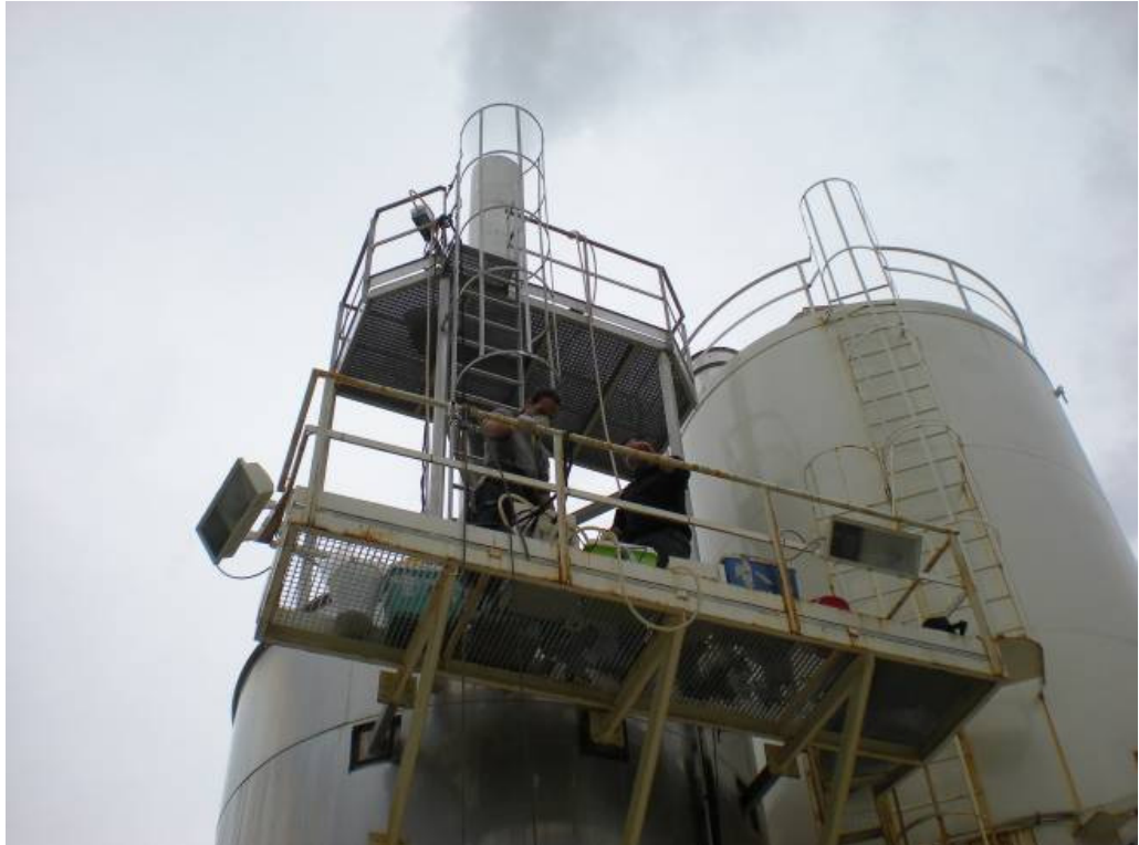
Prueba de emisiones en chimenea del scrubber (septiembre 2009)
