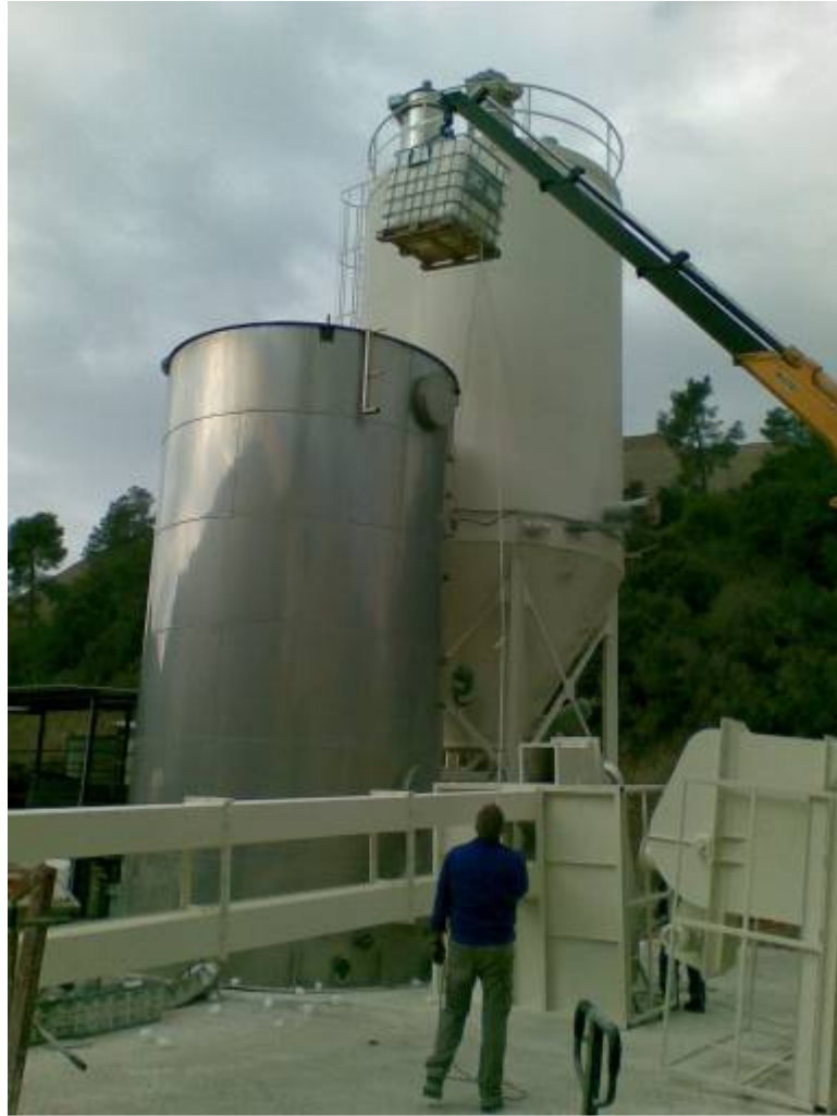
Instalación del nuevo scrubber (60.000 m 3 /h)
