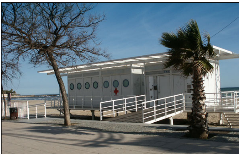
Figura 8.14 Edifici central de salvament, mòdul de socorrisme i senyalització de platges a la Platja del Regueral (Cambrils)
