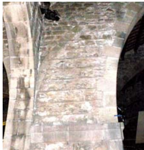
En els contraforts de la nau doble son clarament visibles l'arrencada dels arcs que pertanyen a les arcades diafragmàtiques enderrocades (Foto de l'autor).
