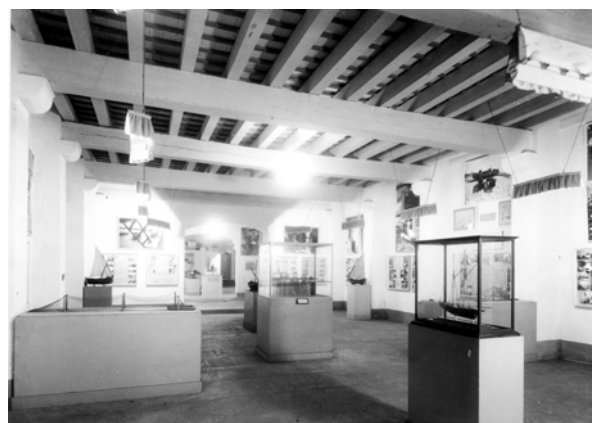
Aspecte de la planta baixa amb les jàsseres moltes de les quals eren en gelosia recobertes amb taulons de fusta. Observeu la compartimentació de l'espai motivada fonamentalment pel mur central que divideix la planta.
