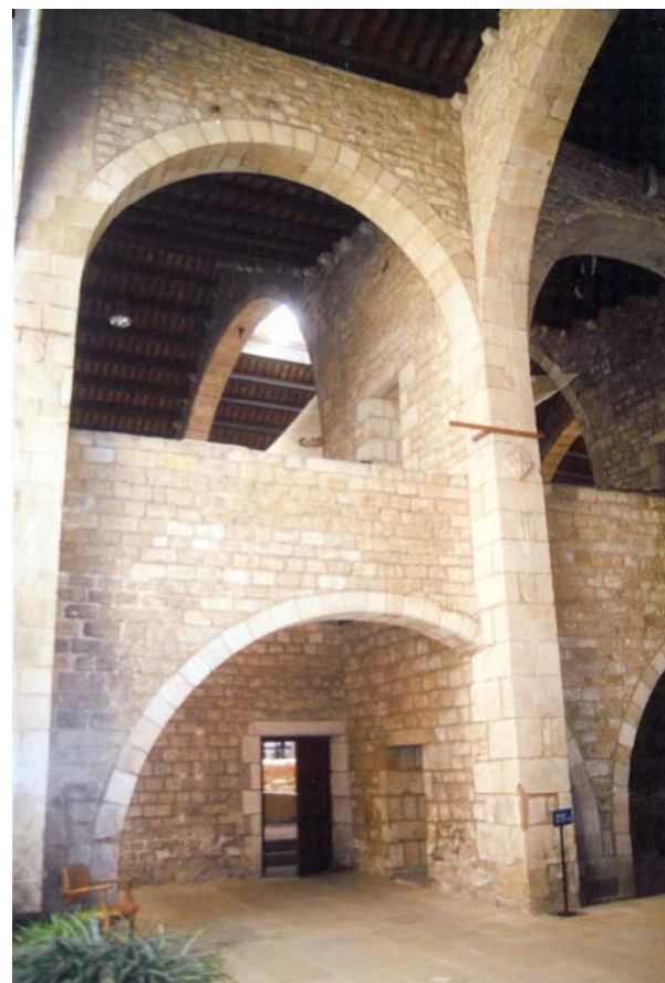
Els contraforts entre les arcades diafragmàtiques; en primer pla els arcs corresponents al gran cos de les naus, al fons els arcs corresponents a les naus dites de la Generalitat (Arxiu Terradas Arqtes.)
