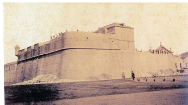
Fotografia presa durant l'enderroc del baluard (Fons Abajo las murallas obra citada)
