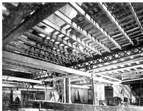
Nou forjat metàl·lic amb jàsseres de gelosia recolzades, damunt de nous pilars per tal de reduir la superfície de cadascun dels trams (Foto arxiu Diputació de Barcelona)
