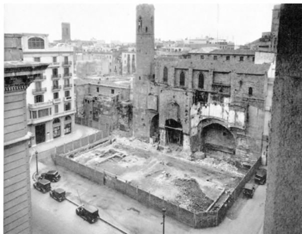
La plaça Berenguer durant les obres d'urbanització i construcció de la casa Padellás (Font A. Florensa, La valorització urbanística del circuit romà. Obra citada).
