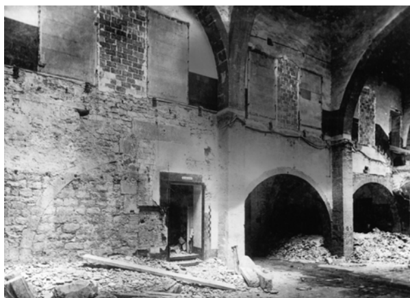
El mur de Llevant de la nau 1, abans de la restauració, entre les arcades diafragmàtiques 3,4 i 5.
