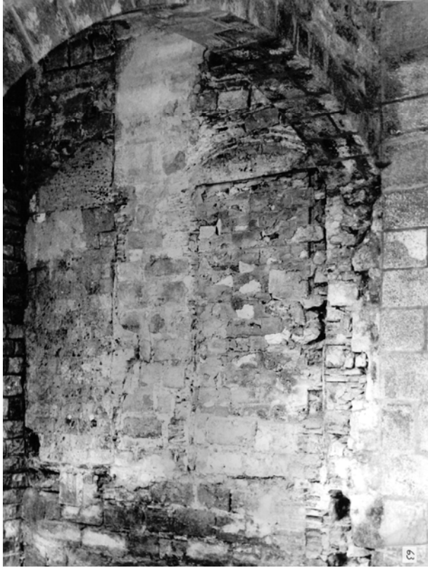
Interior del pòrtic de Pere II mostrant el contrafort del XVII. Novembre de 1940.
