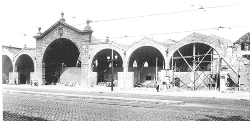
La façana en procés de restauració 1952 (Arxiu Museu Marítim de Barcelona).
