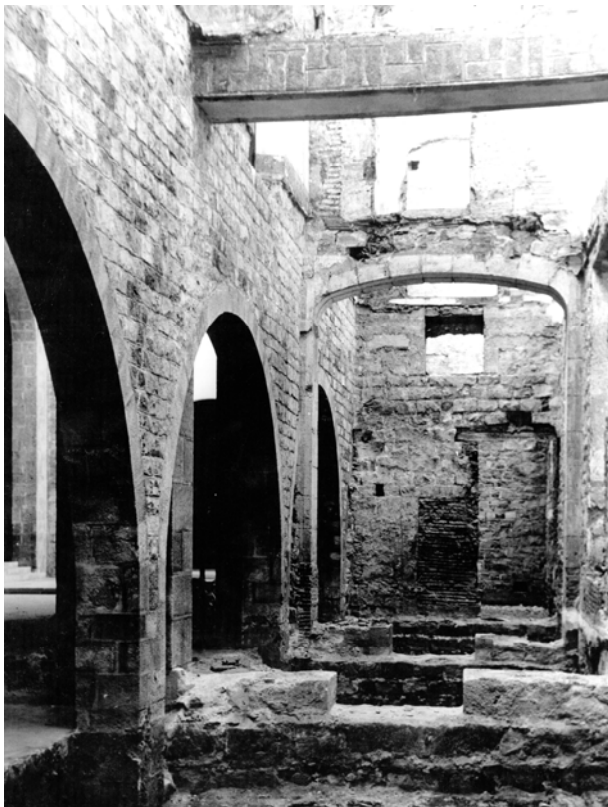
Interior del pòrtic de Pere II. S'observen els arcs del pòrtic en construcció, l'estintolament i passos dels contraforts entre les naus de mar i les naus de la Generalitat. Agost 1940.
