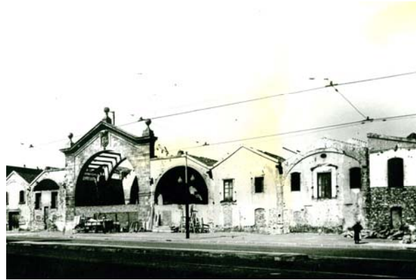
La façana sud. Abril 1952. S'observa que la façana no té contraforts
