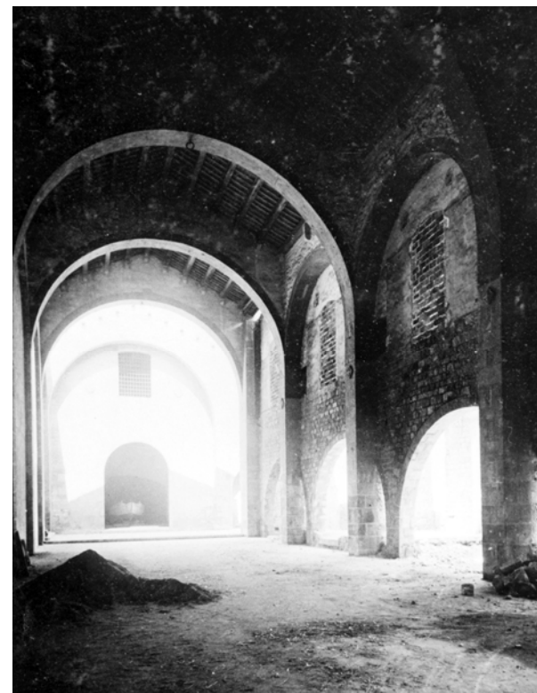
La nau 1 amb els arcs de pòrtic a Pere II, vers l'edifici de Porxo Nou.
