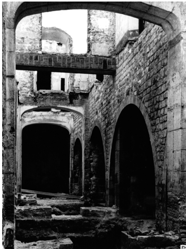
Interior del pòrtic de Pere II amb els arcs reconstruïts.
