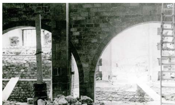
Els arcs del pòrtic de Pere II i el pilar contrafort de les arcades diafragmàtiques al setembre de 1942.
