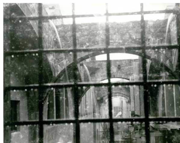
El pati entre el gran cos de naus i la sala Marques de Comilles. S'observen les canals de desguàs i la continuïtat de les arcades aqüeductes com a contraforts.
