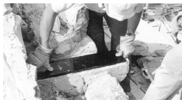
Operació d'unir els permòdols (Arxiu Terradas Arquitectes).
