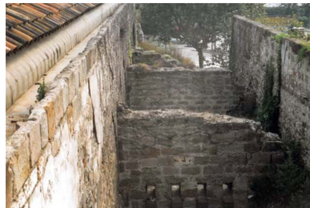
Els contraforts de ponent de les arcades diafragmàtiques entre la 8ª arcada aqüeducte (amb els arcs cegats) i la muralla (Arxiu Terradas Arquitectes).
