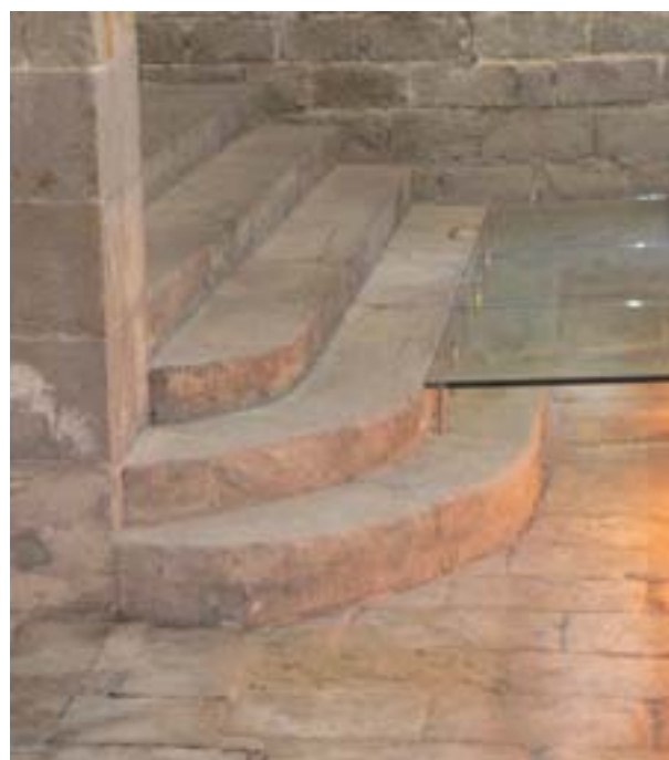
La darrera restauració de Porxo Nou ha permès trobar el paviment original i dos graons de l'escala. (Arxiu Terradas Arqtes.).
