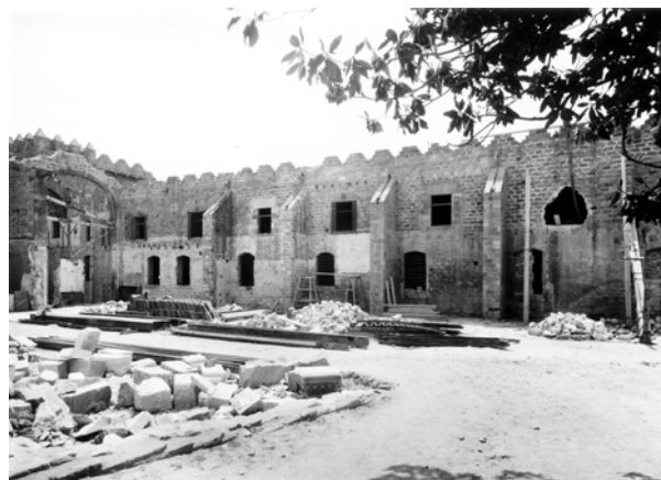
L'edifici de Porxo Nou en restauració on s'observen totes les perforacions practicades en el mur de llevant.
