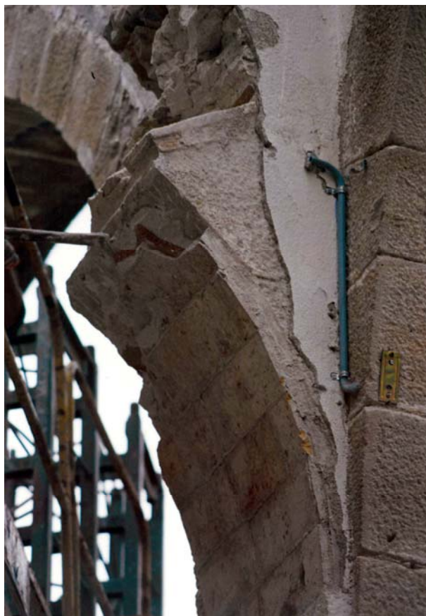
L'arrencada de l'arc inexistent a l'últim mig tram de la sala Marqués de Comillas. (Arxiu Terradas Arquitectes).
