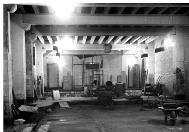
Dues fotografies de la construcció dels fals pilars i del mur divisor de la planta baixa del Porxo Nou. (Arxiu Diputació de Barcelona).
