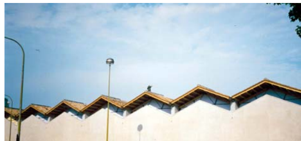
La façana executada.
