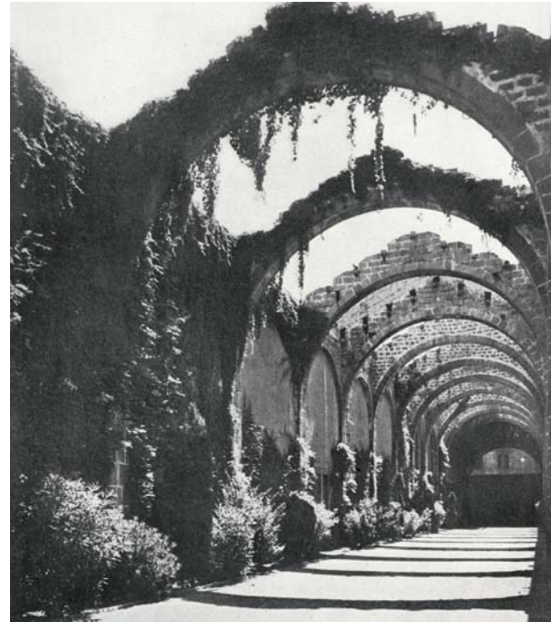
La nau 3 amb l'aspecte de ruïna (Fons Ajuntament de Barcelona. Jardines y Monumentos. Obra citada).
