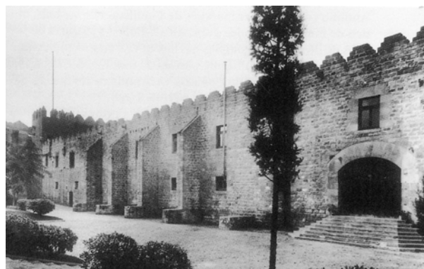
A la restauració de A. Florensa el nivell de jardí era més baix com ho demostra el fet que hi havien 8 graons per accedir a Porxo Nou (Arxiu Museu Marítim de Barcelona).
