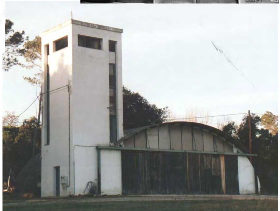
Estat actual de l'hangar
