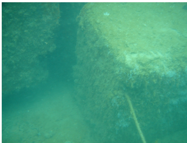
Figura 9.1. Cajones de hormigón movidos en el puerto de Vilanova.
