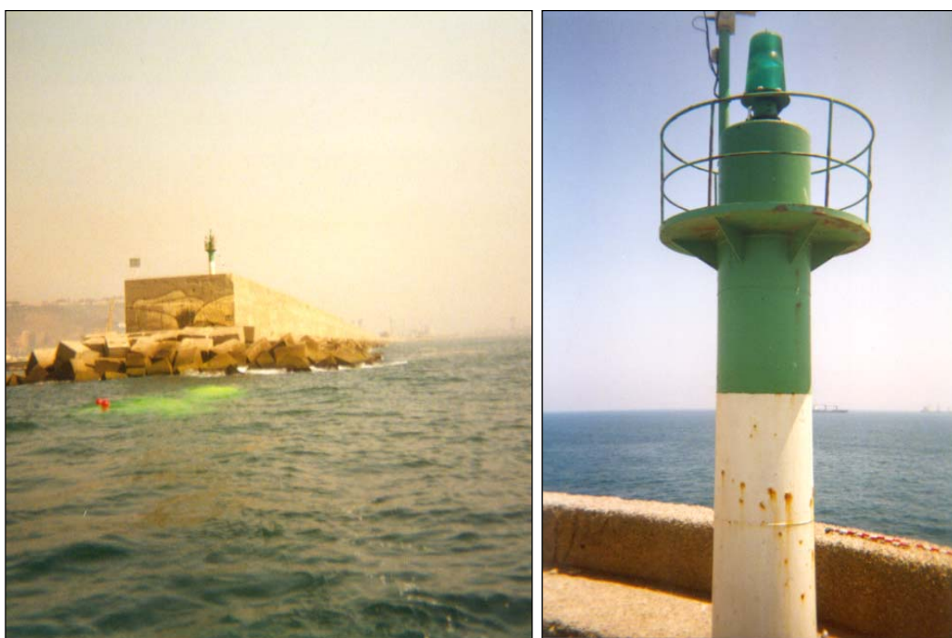
Figura 6-9. Situación de las cámaras de vídeo en el Dique del Este.
