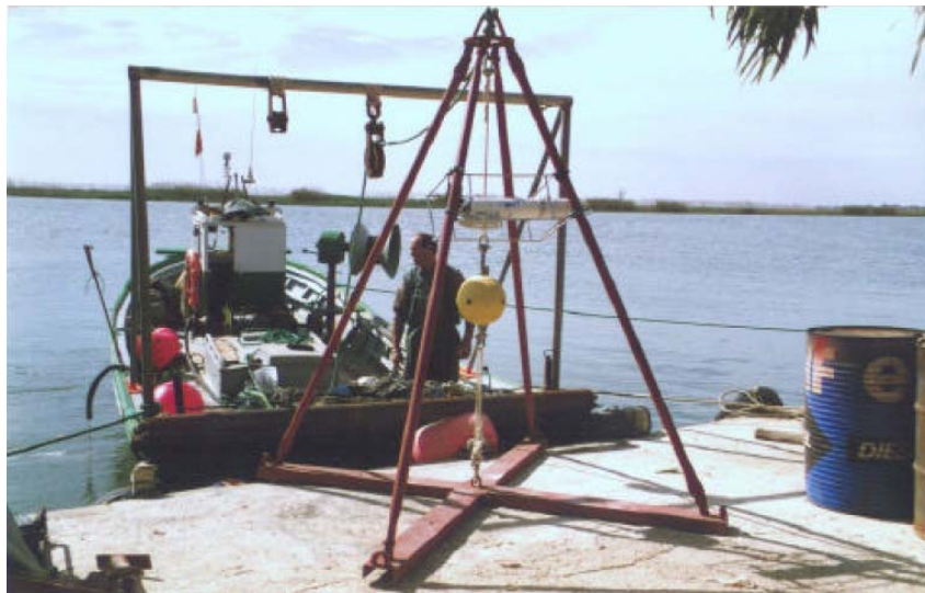
Figura 6-3 Tetrápodo-Instrumental con S4DW correntímetros y sensor de presión.
