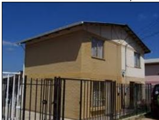
Foto N° 28: Viviendas sociales, Talca.
