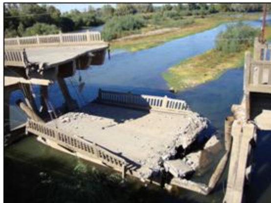
Foto N° 15: Puente río Claro, acceso oeste ciudad de Talca.
