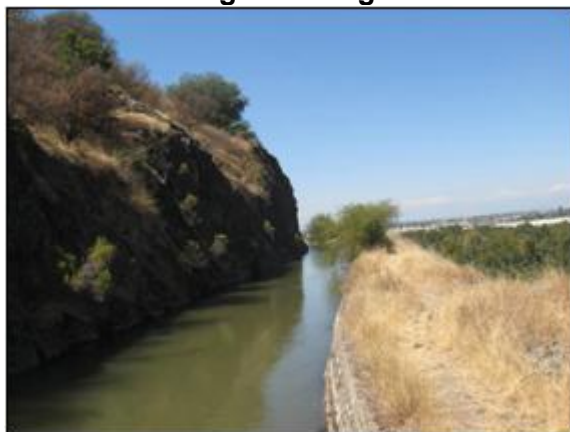
Foto N° 25: Canal de agua de riego: zona de Pencahue.
