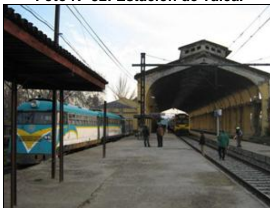
Foto N° 32: Estación de Talca.
