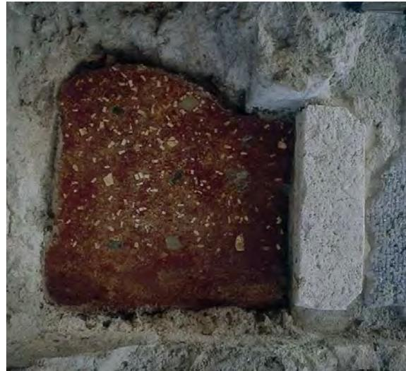
Figura 38 Fragmento de opus signinum a la entrada del vano 56
