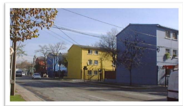
Fotografía 3: Tipología de viviendas de viviendas unifamiliares, interior del parche
