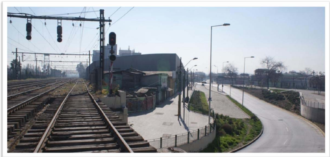
Fotografía 47: Borde poniente, línea del ferrocarril y calle Exposición Fuente: N. Ahumada, 2012
