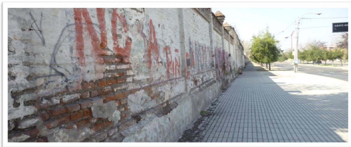
Fotografía 44: Borde este, calle Mirador, borde duro costado Club Hípico de Santiago Fuente: N. Ahumada, 2012
