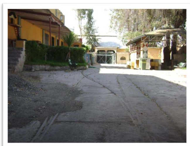
Fotografía 6: Vista interior Central de Leche
