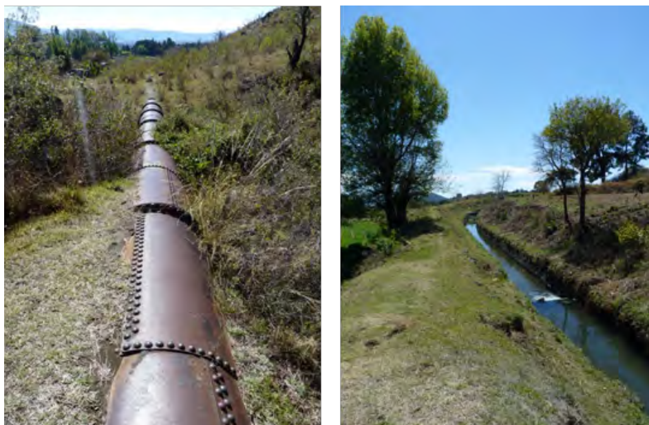
Imagen 32 y 33. Tubería que conecta la Casita Blanca con la Sala de Turbinas y el canal que va del Manantial de Atlimeyaya a la Presa de la CIASA y luego a la Casita Blanca. M. Castellanos.
