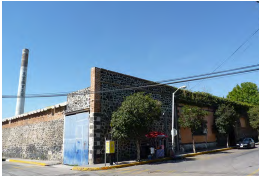
Imagen 9. Ex fábrica El Carmen. Fachada principal. M. Castellanos
