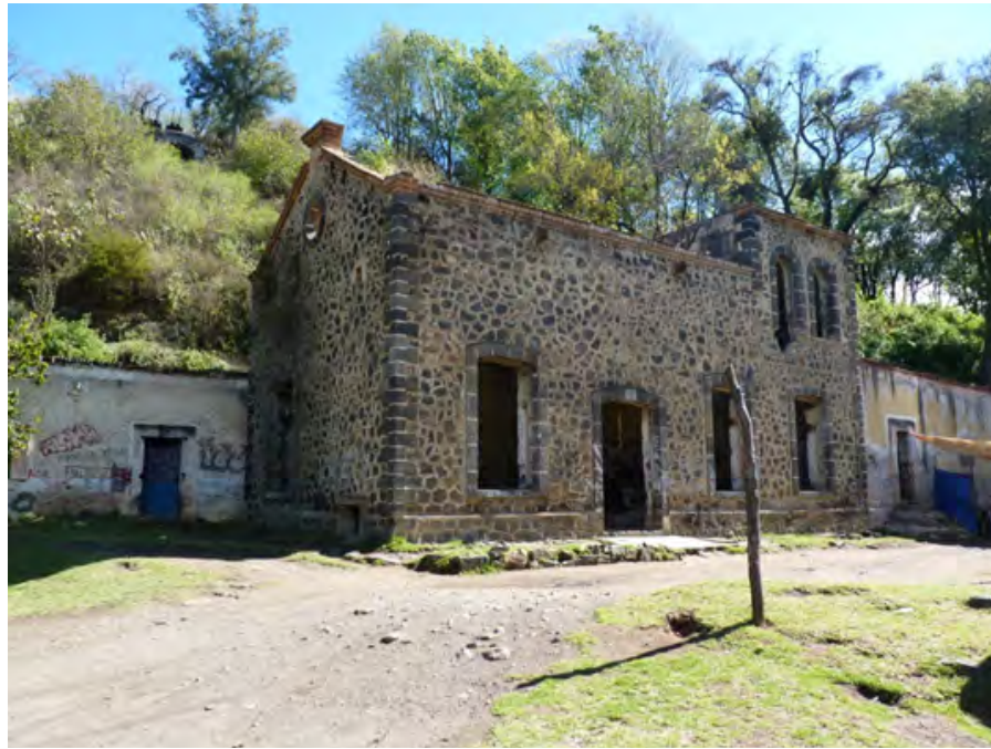
Imagen 34. Edificio de la Presa de CIASA. M. Castellanos
