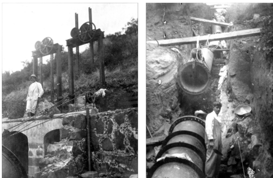
Imagen 16 y 17. Instalaciones hidráulicas. Construcción de la presa de la CIASA, AS-25-25580 y instalación de tubería AS-25-25581, AHA s/f.
