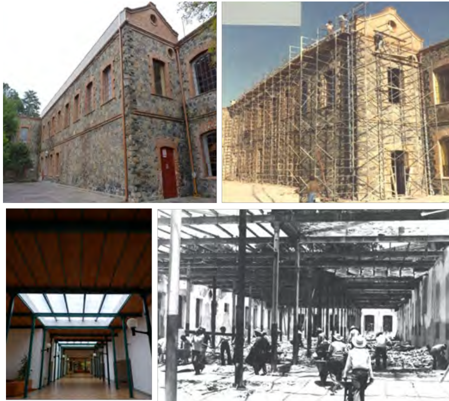
Imágenes 39, 40, 41 y 42. Durante las obras de restauración de la ex fábrica textil de Metepec y del estado actual. (Antes), AHEM, Colección Fotográfica, Sección Metepec, Serie Restauración de la Ex Fábrica de Metepec, Exp. 1, (Después) M. Castellanos.
